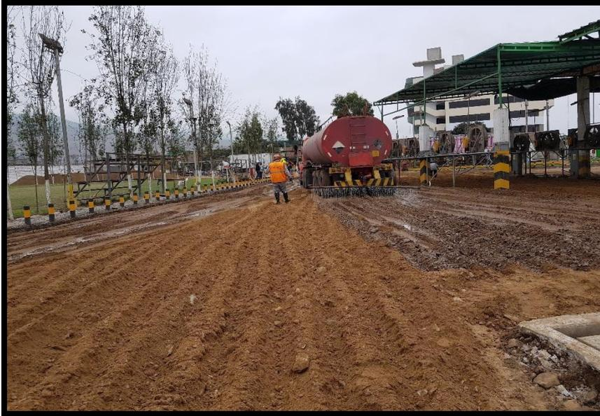
*Figura 44.* Aplicación del cloruro de Calcio.
