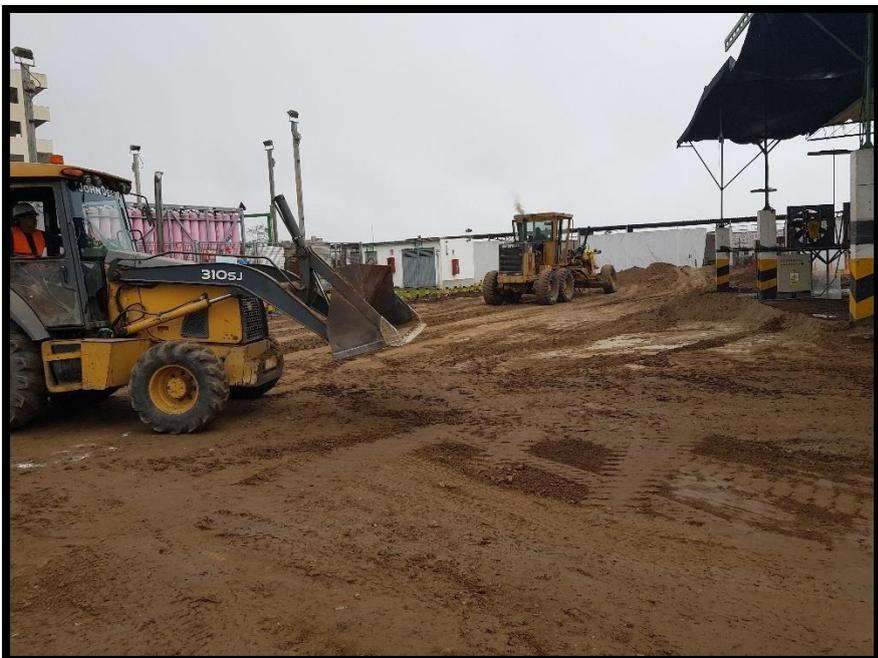
*Figura 43.* Motoniveladora y cargador frontal tendiendo el afirmado.
