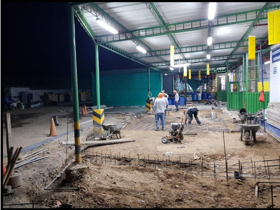
Figura 26. Construcción de Losas de concreto y sistema de canaletas en Planta Santa Elena.
