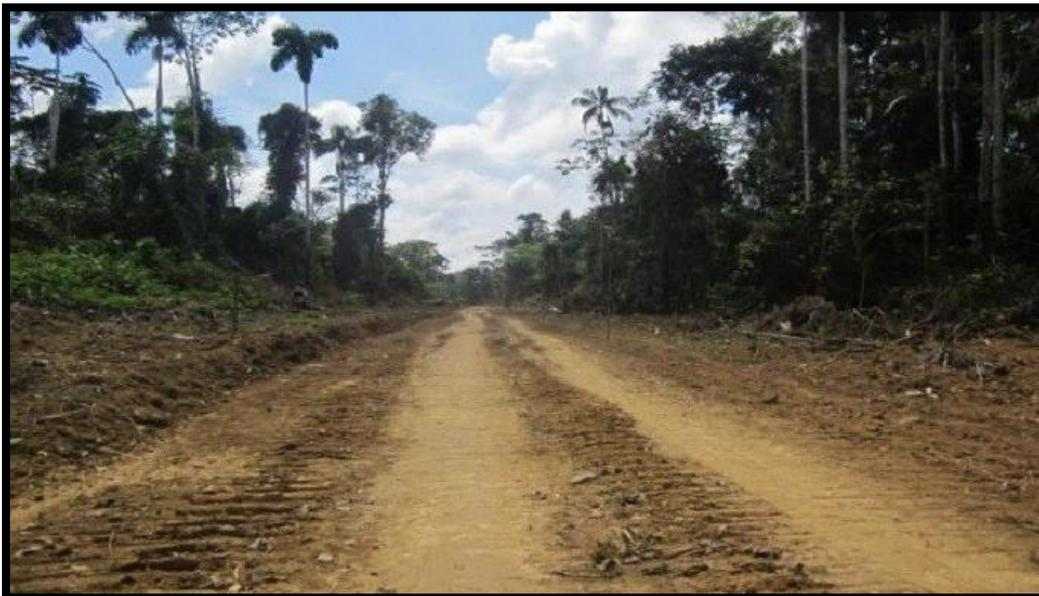
*Figura 10.* Superficie de carretera afirmada con presencia de baches y en mal estado.
