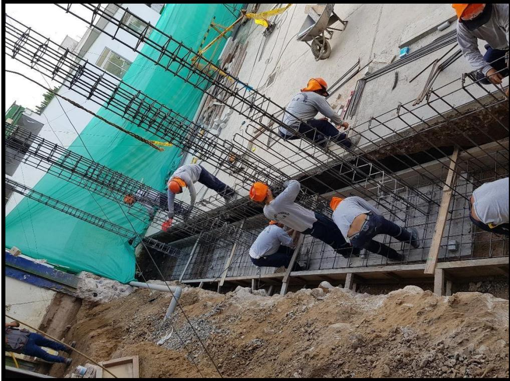
Figura 23. Construcción de Almacén de Congelados, pórticos de ingreso (parte 1).
