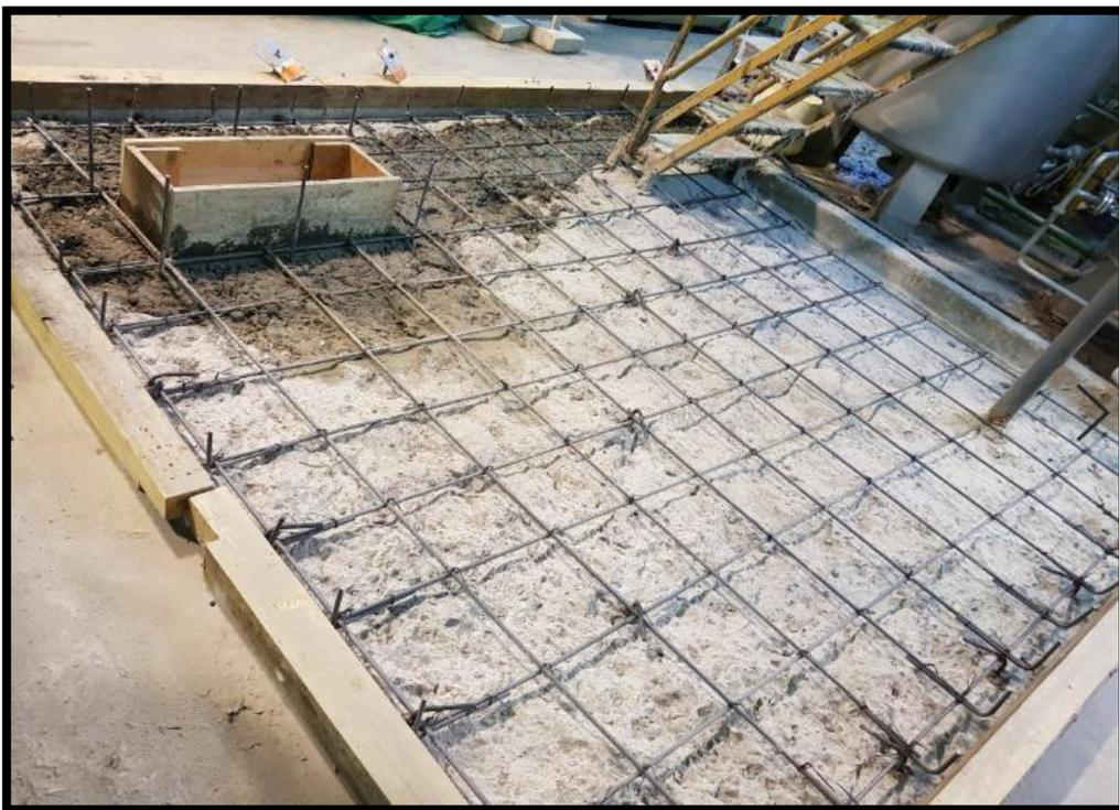
*Figura 18.* Construcción de Losas de concreto armado en Planta de producción.
