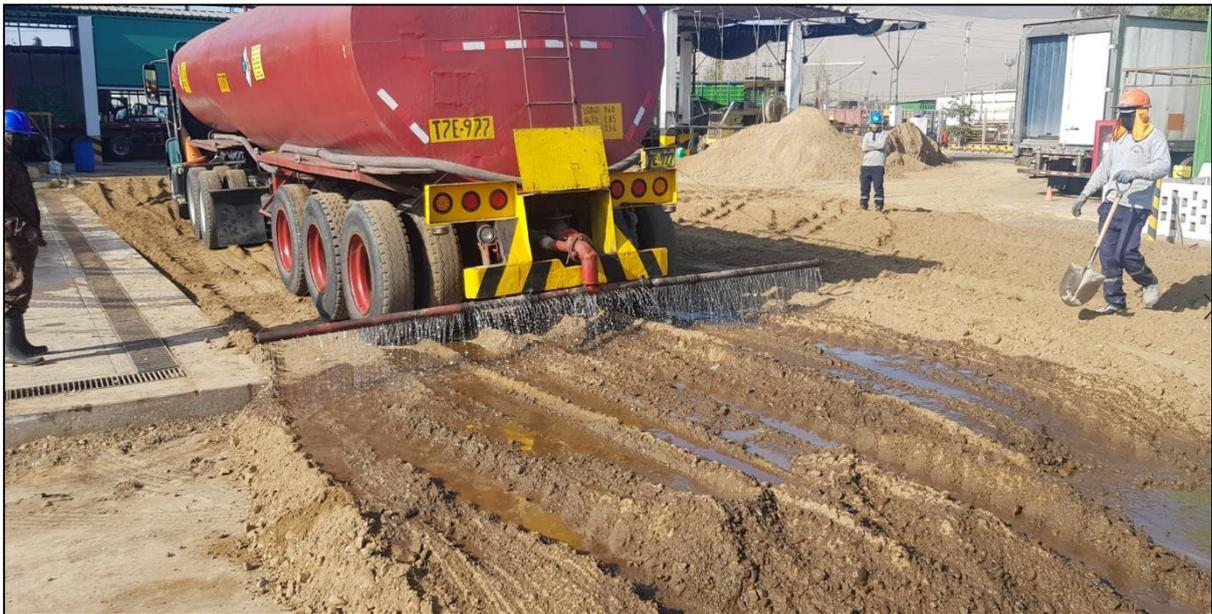
Foto 3. Aplicación de Cloruro de Calcio para una mejor estabilización del suelo.
