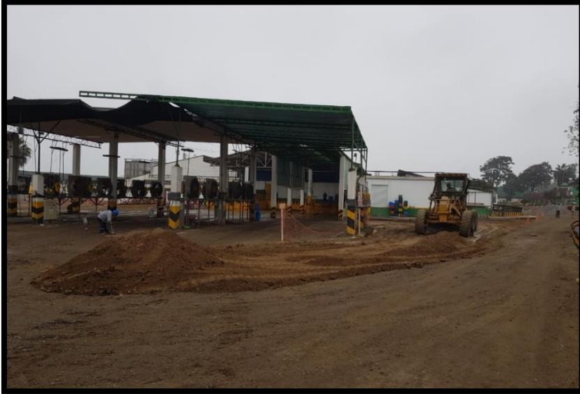
*Figura 40.* Cargador Frontal y Motoniveladora realizando escarificación y corte de 0.20m al terreno.
