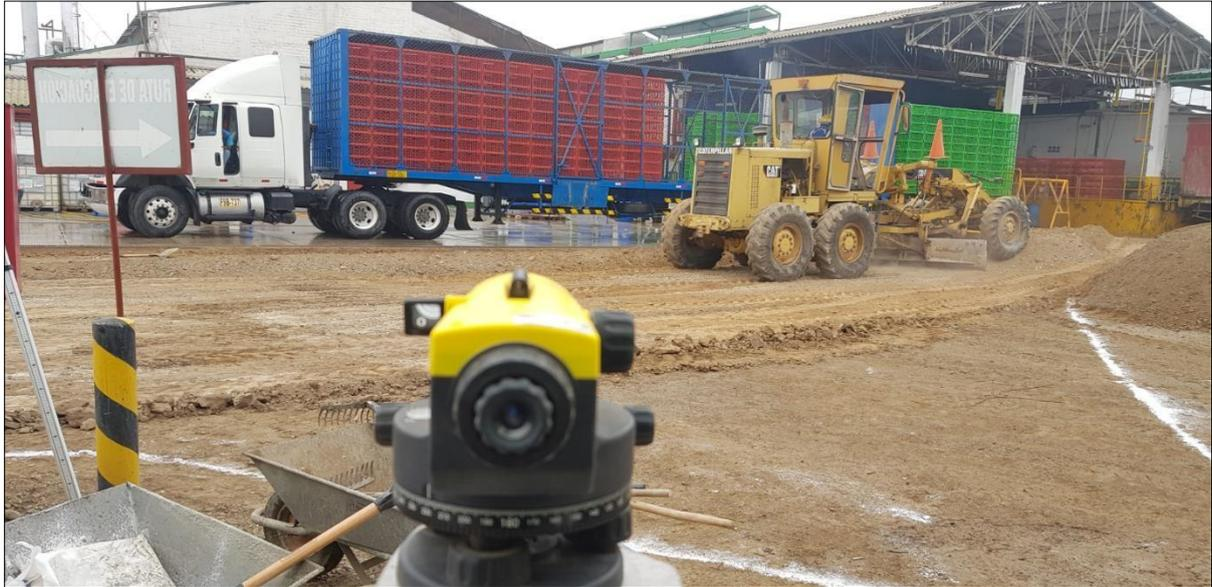
Foto 1. Trabajo de Topografía para medir los niveles durante el Mejoramiento de Suelo.
