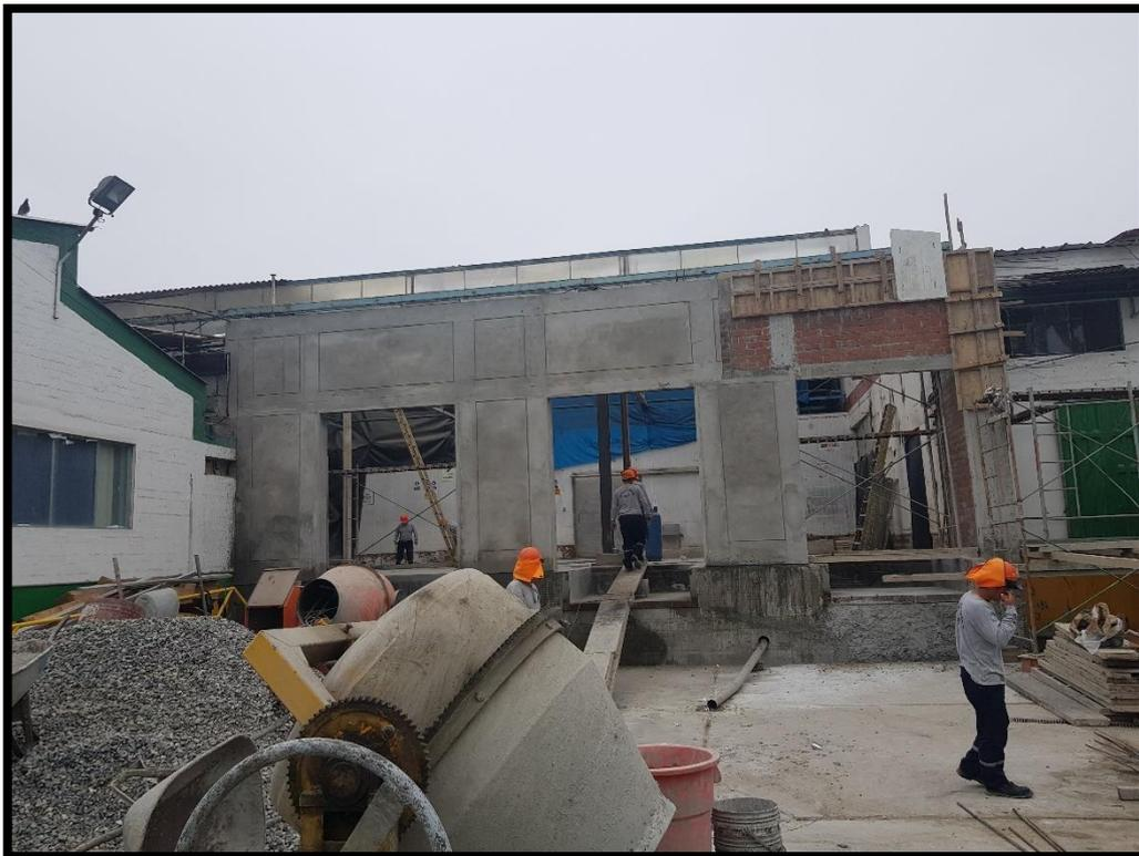
Figura 24. Construcción de Almacén de Congelados, pórticos de ingreso (parte 2).
