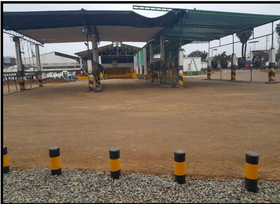
*Figura 47.* Resultado del mejoramiento de suelo con afirmado y cloruro de calcio. (Parte 2)
