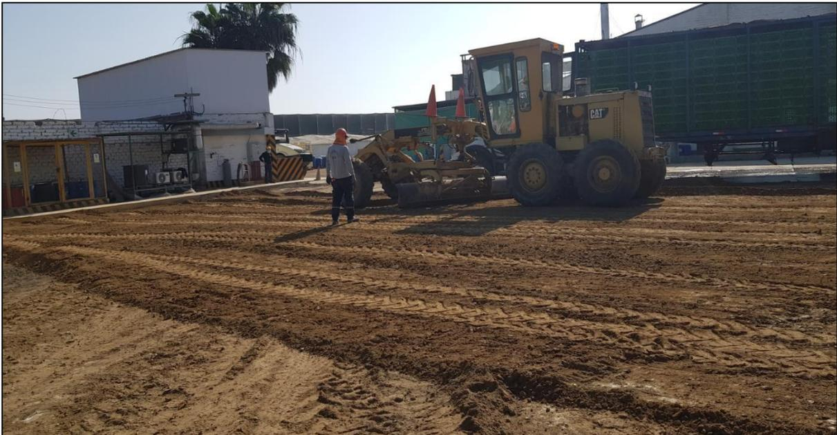
Foto 2. Retroexcavadora escarificando y nivelando
