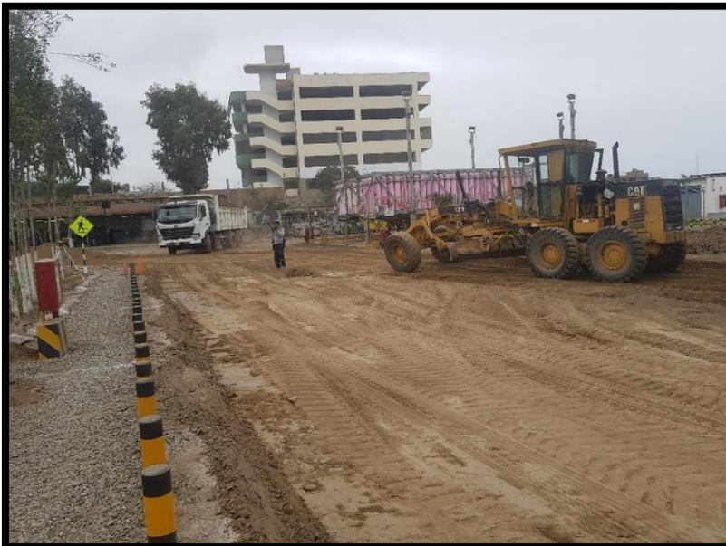
*Figura 41.* Compactación y nivelación de la sub rasante.
