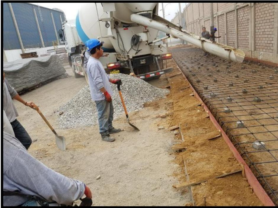
*Figura 19.* Construcción de Losas para almacén de residuos.
