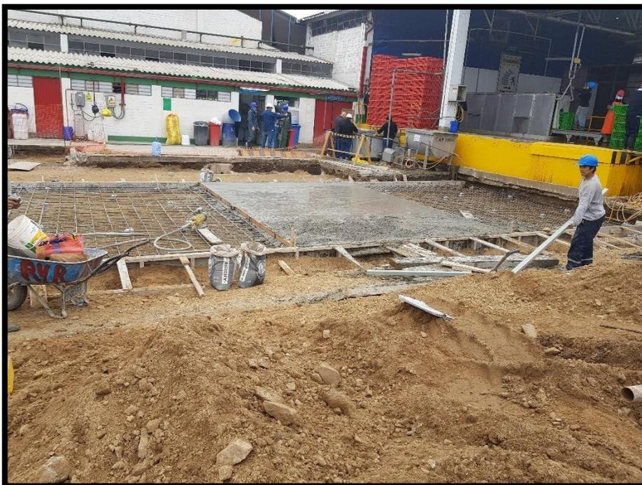
*Figura 20.* Construcción de concreto armado para Descarga de Jabas.
