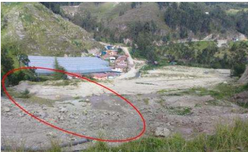
Figura N° 18. Infiltración de agua en temporada de lluvia – Llushcapampa.
