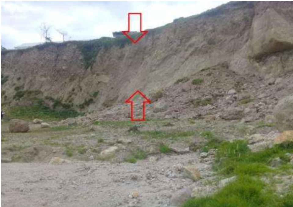
Figura B. N° 2: Escape principal del deslizamiento
