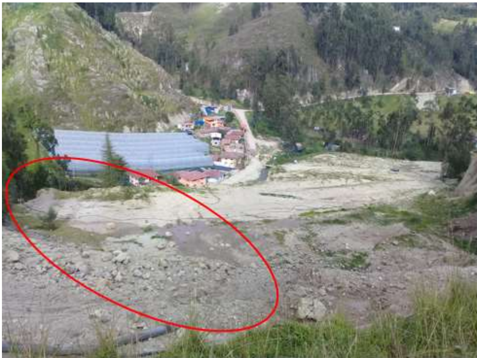
Figura B. N° 4: Infiltración de agua de tubería
