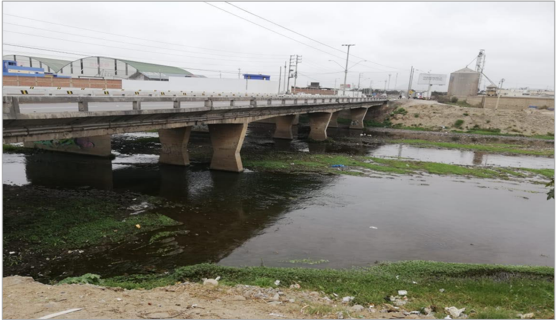
Figura 17. Puente Moche (1951). Fuente: Elaboración propia.
