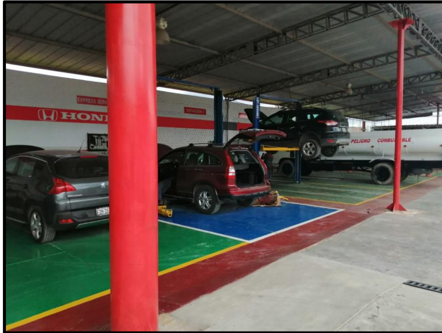
Figura 17 En la fotografía se aprecia que, no se identifica cada área según el organigrama, no se muestran bancos de trabajo, ni depósitos de desechos, tampoco se observa drenajes adecuados para desperdicios líquidos.
