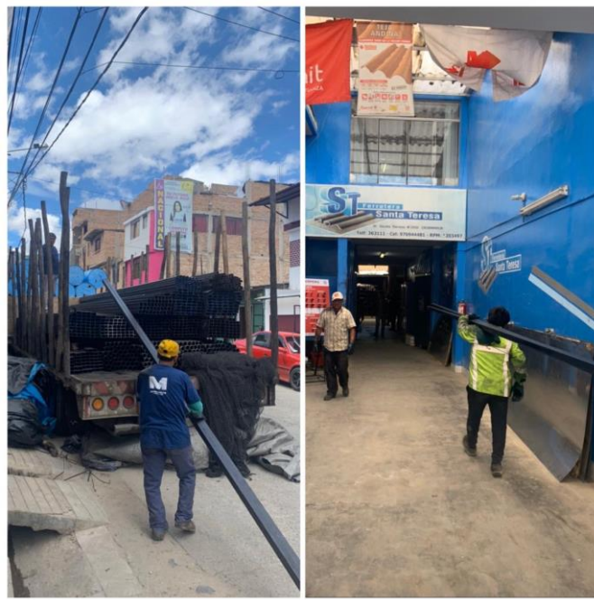
Figura N°4: Descarga de materiales.
