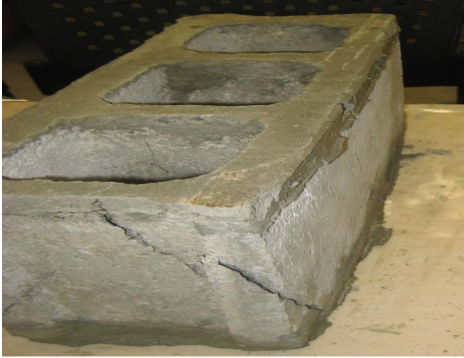
fotografía 39 Falla en tabique exterior, bloque con CCA
