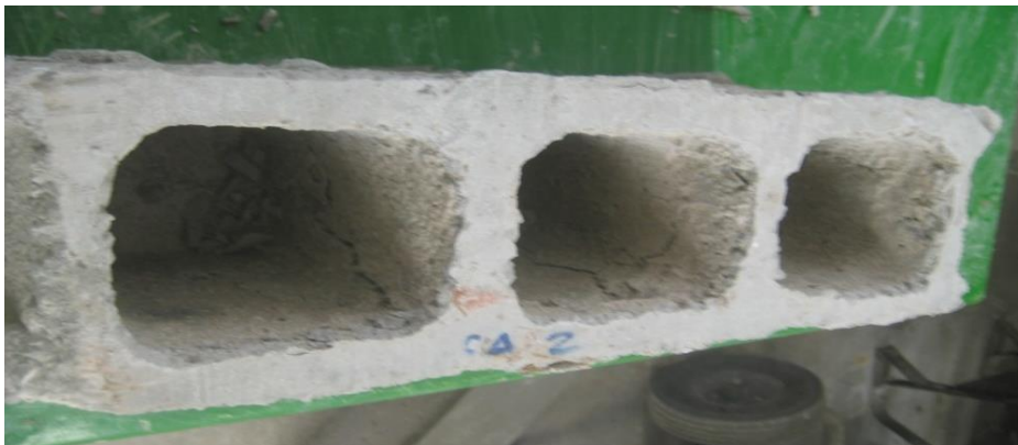
fotografía 37 Falla en el interior, bloque con CA
