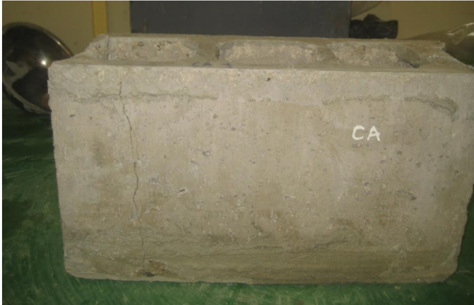
fotografía 36 Rajadura, bloque con CA
