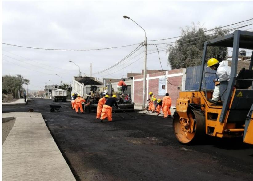
*Figura 16:* Compactación de carpeta de rodadura flexible. Jr. Mateo Pumacahua.
