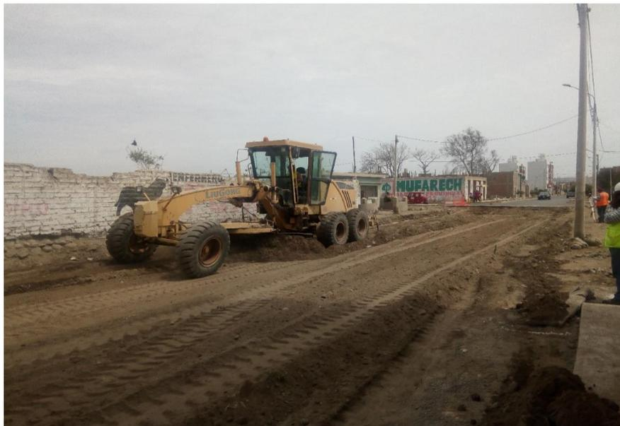
*Figura 13:* Conformación de la subrasante del Jr. Mateo Pumacahua.
