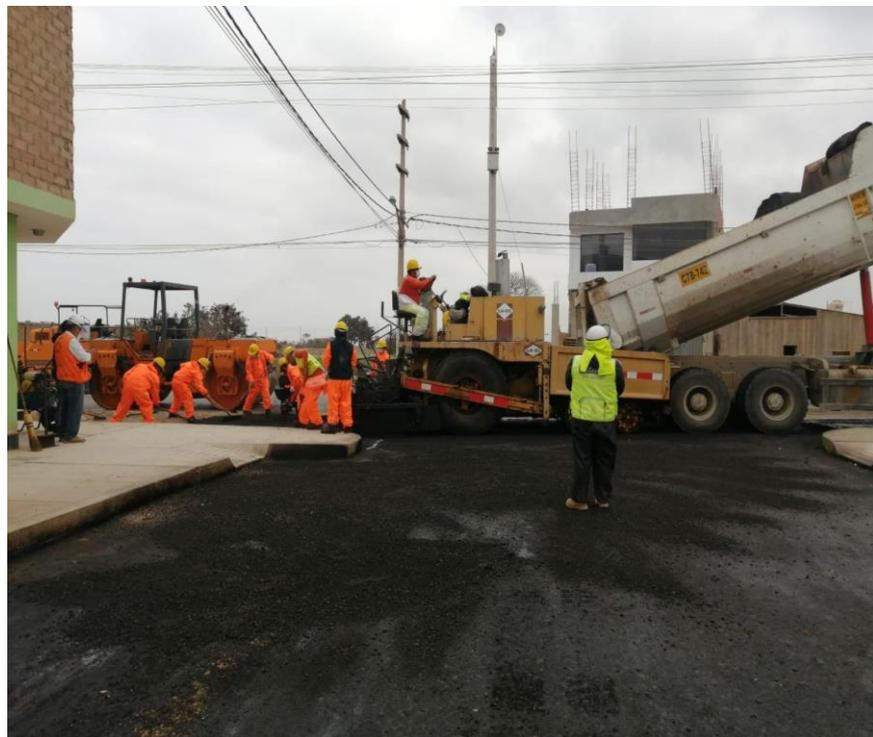
*Figura 15:* Colocación de carpeta de rodadura flexible. Jr. Mateo Pumacahua.
