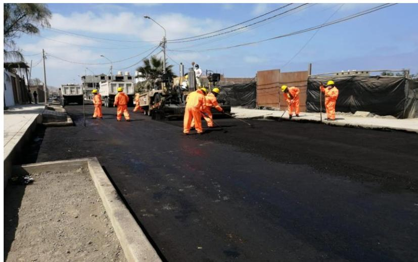
*Figura 17:* Esparcimiento de concreto asfáltico. Jr. Mateo Pumacahua.
