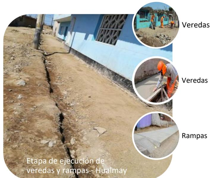
*Figura 22:* Excavación de sardineles de vereda. Jr. Mateo Pumacahua.
