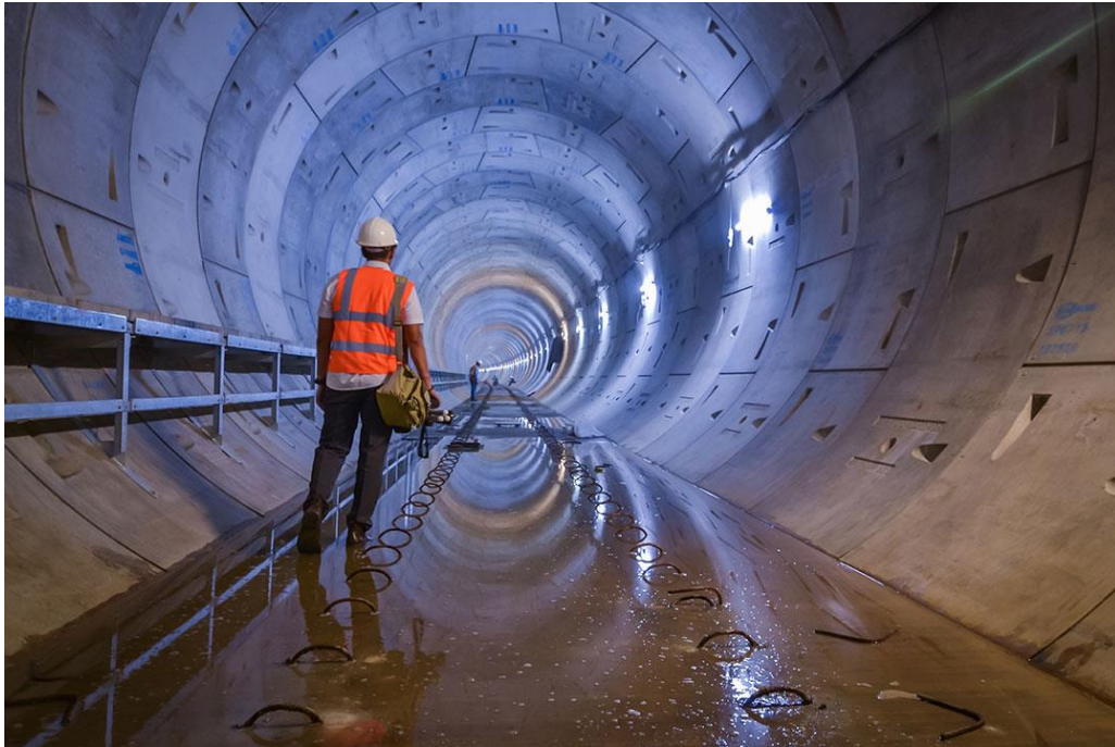
Figure 5: Aplicaciones de Hormigón con Fibra de Acero
