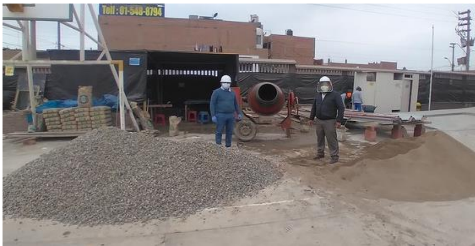
Figura 26: Agregado fino y grueso
