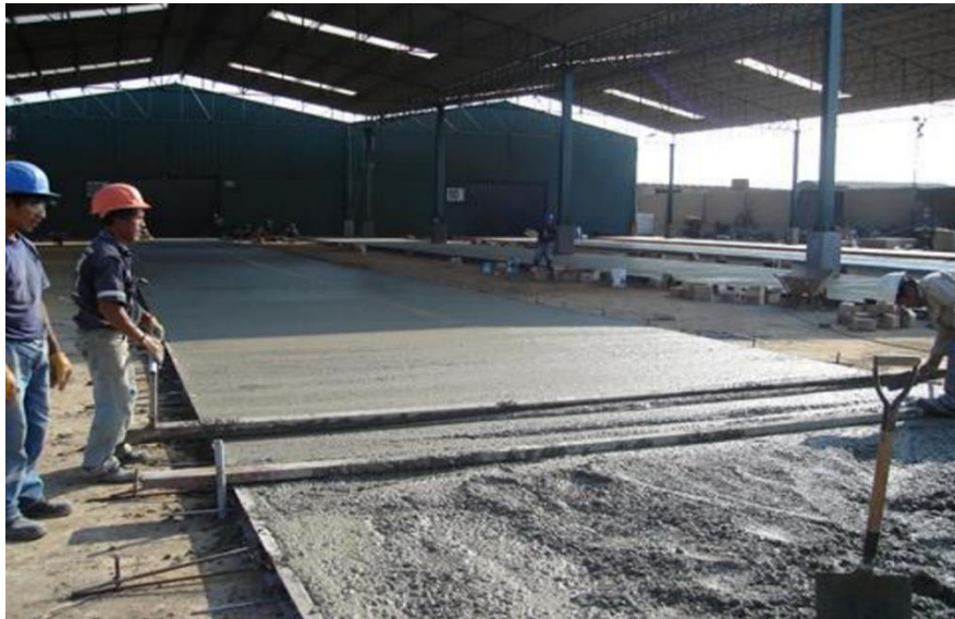
Figura 16: Losa de concreto reforzado con fibra de acero reciclado
