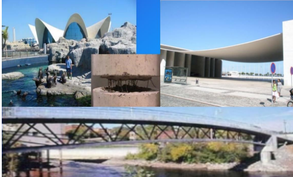
Figure 3: Aplicaciones de Hormigón con Fibra de Acero
