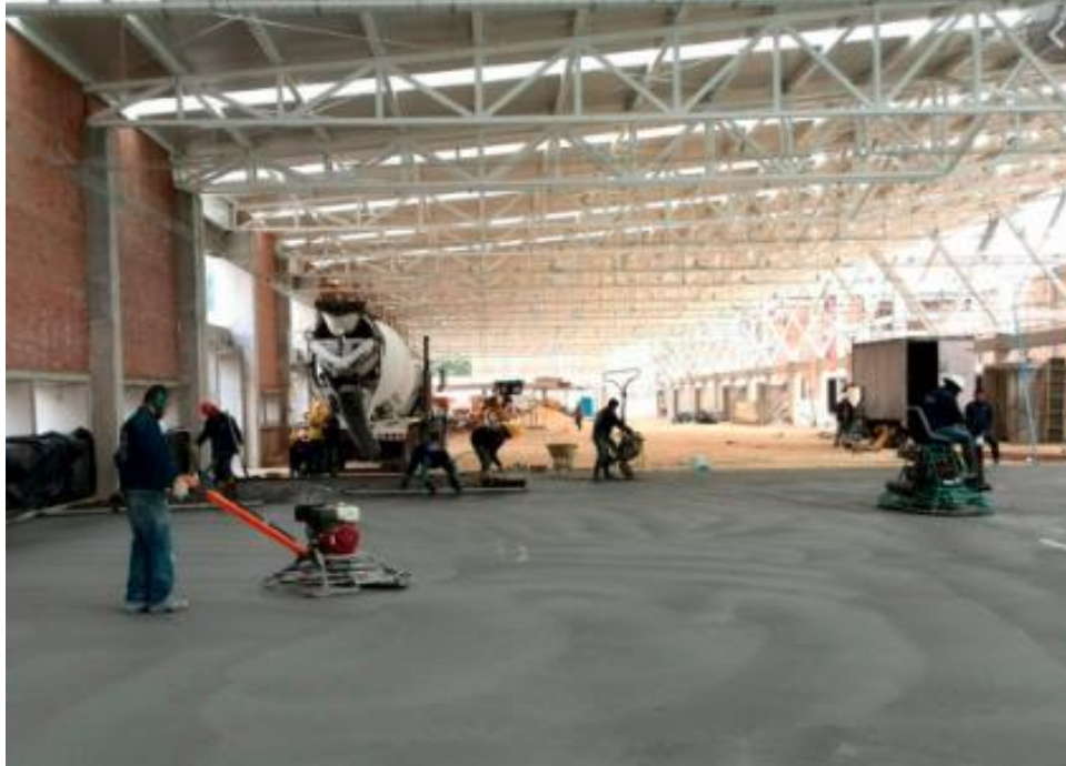
Figura 15: Pisos industriales y losas de concreto con fibras de acero
