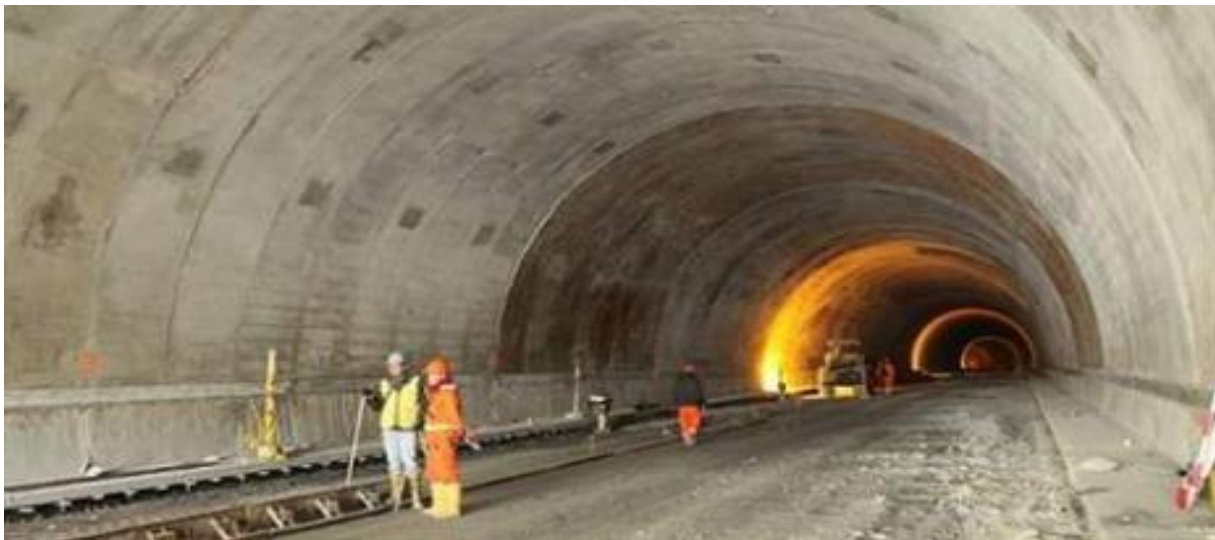
Figura 12: Túnel construido con concreto reforzado con fibras de acero
