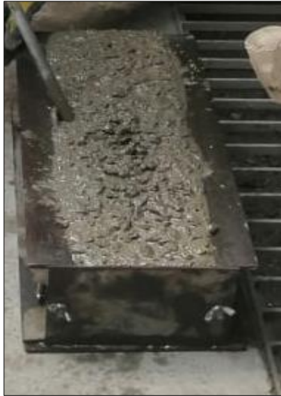
Figure 42: Elaboración de viguetas prismáticas armadas con fibra de acero reciclada
