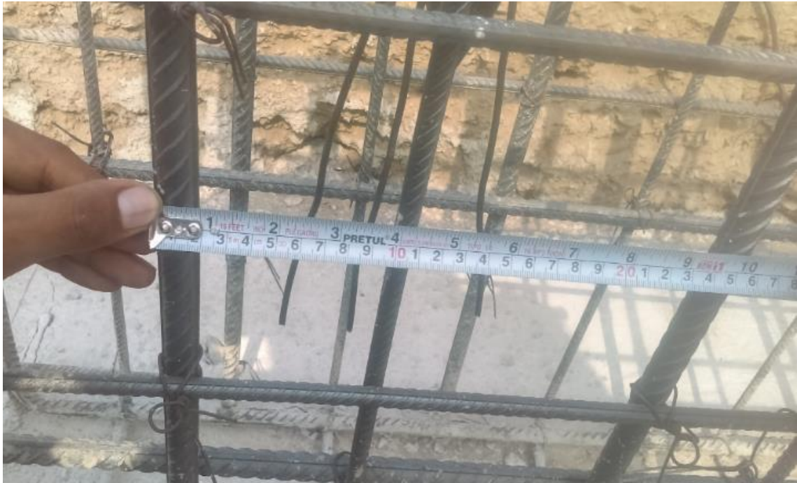
Figura 4. Inspección de acero de pedestales. Obra “Grifo Ransa Vencedor
