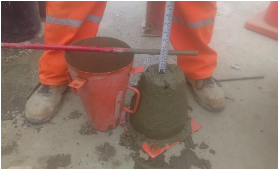
Figura 5. Utilización de cono de abrams para verificación de slump. Obra “Grifo Ransa Vencedor.
