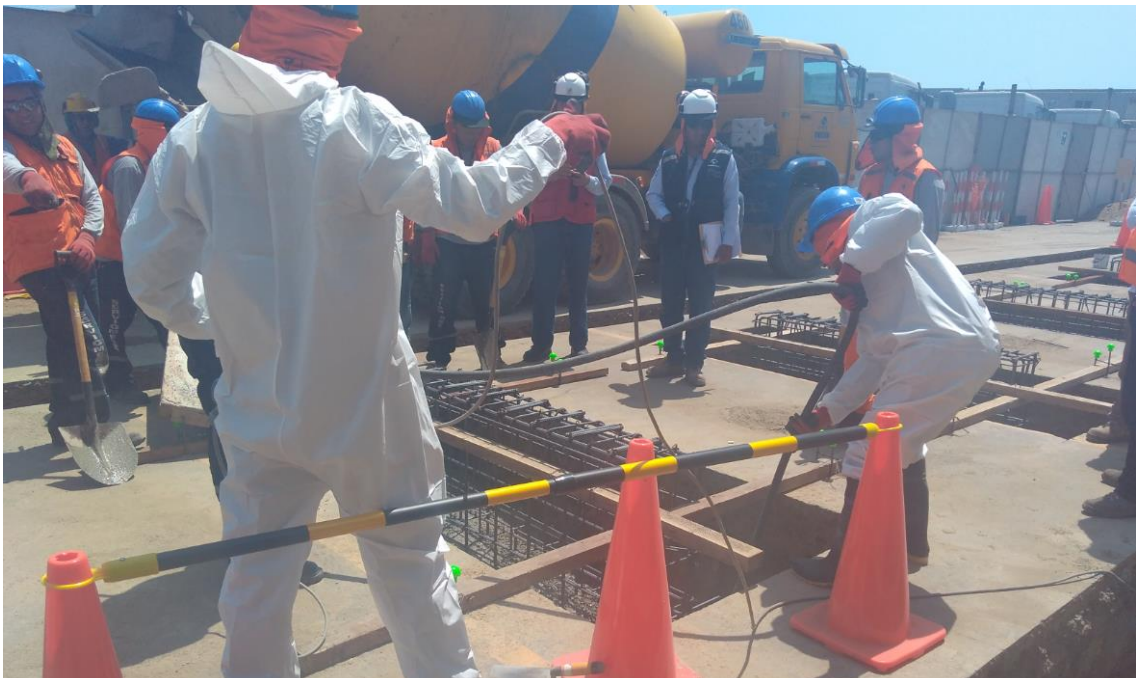
Figura 3. Vaciado de zapatas de pedestales. Obra “Grifo Ransa Vencedor
