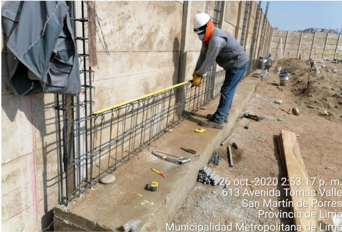
Figura 10. Medición y verificación de dimensionamiento de sobrecimiento armado cuyas medidas cumplen según lo especificado en los planos.
