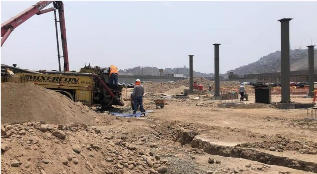
Figura 13. Instalación de columnas metálicas para techo cannopy EDS TOMAS VALLE
