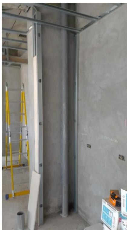
Figura 37. Instalaciones sanitarias, estas serán recubiertas con planchas como columnas falsas.
