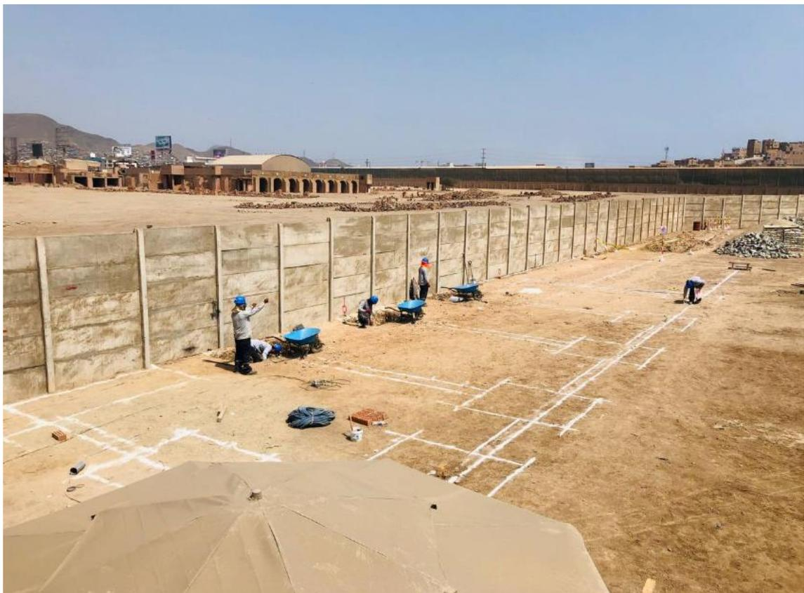
Figura 9. Trazo y replanteo en del terreno para los inicios de construcción de la edificación donde se encontrará el market, oficinas y cuarto de tableros (Área liberada por el cliente)
