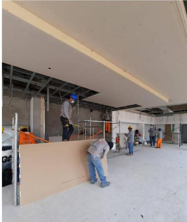
Figura 38. Colocación de planchas en cielo raso de tienda, como se puede apreciar el diseño de los 2 niveles de cielo raso.
