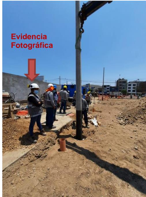
Figura 15. Instalación de postes eléctricos en perímetro de EDS TOMAS VALLE
