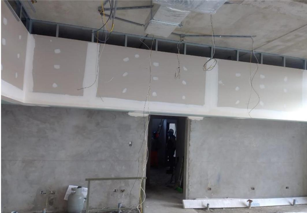
Figura 42. Sellado de juntas entre planchas en cenefas de drywall interior de tienda.
