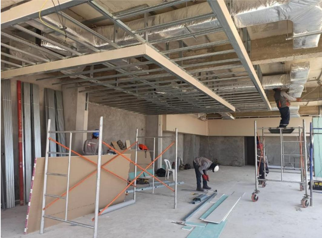
Figura 35. Estructura de cielo raso sistema Drywall, en interior de tienda.
