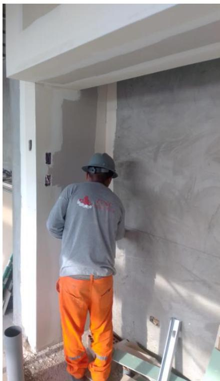
Figura 41. Sellado de juntas entre planchas en falsas columnas interior de tienda.
