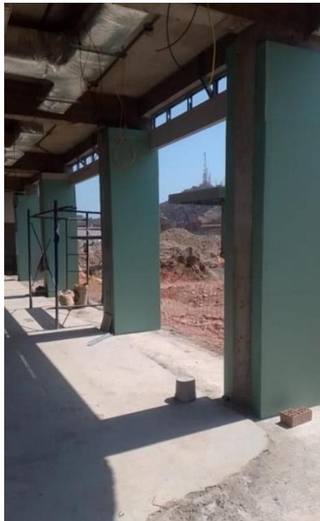
Figura 40. Colocación de planchas en falsas columnas exterior de tienda.
