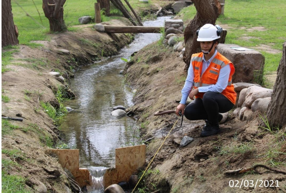
Figura 54: Colocación del vertedero combinado 90° de material de madera del canal de riego en el Entorno rural del sector Quives, km. 40, Lima – Canta, año 2021.
