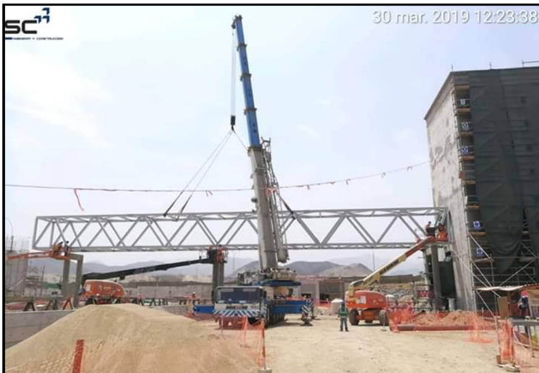
FIGURA 30: MONTAJE DE PUENTE METALICO – CD SAGA FALABELLA.
