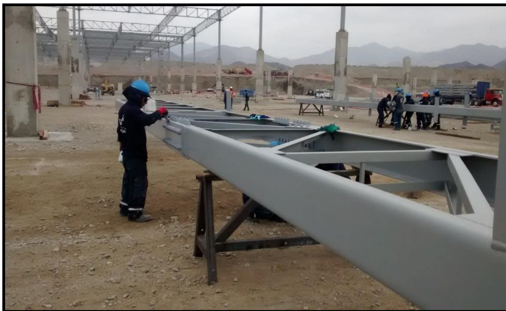
FIGURA 62: Resane de pintura en partes dañadas
