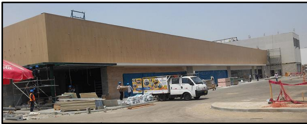
FIGURA 19: Instalación de Cerramiento - CENTRO COMERCIAL VIVANDA - ASIA
