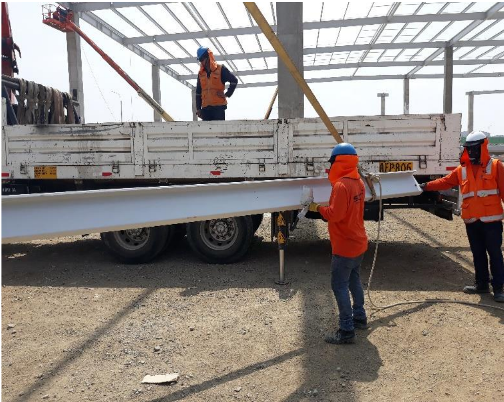
FIGURA 94: Montaje directo de la unidad a correas para techo.
