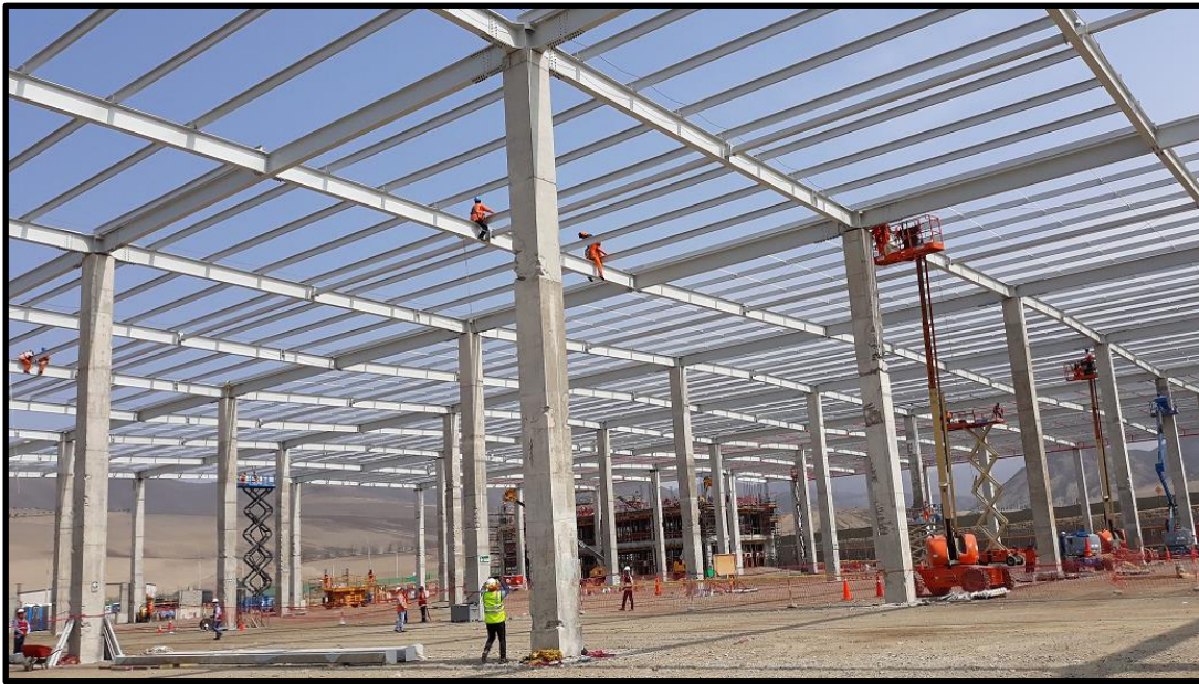
FIGURA 29: MONTAJE DE ESTRUCTURAS METALICAS – CD SAGA FALABELLA
