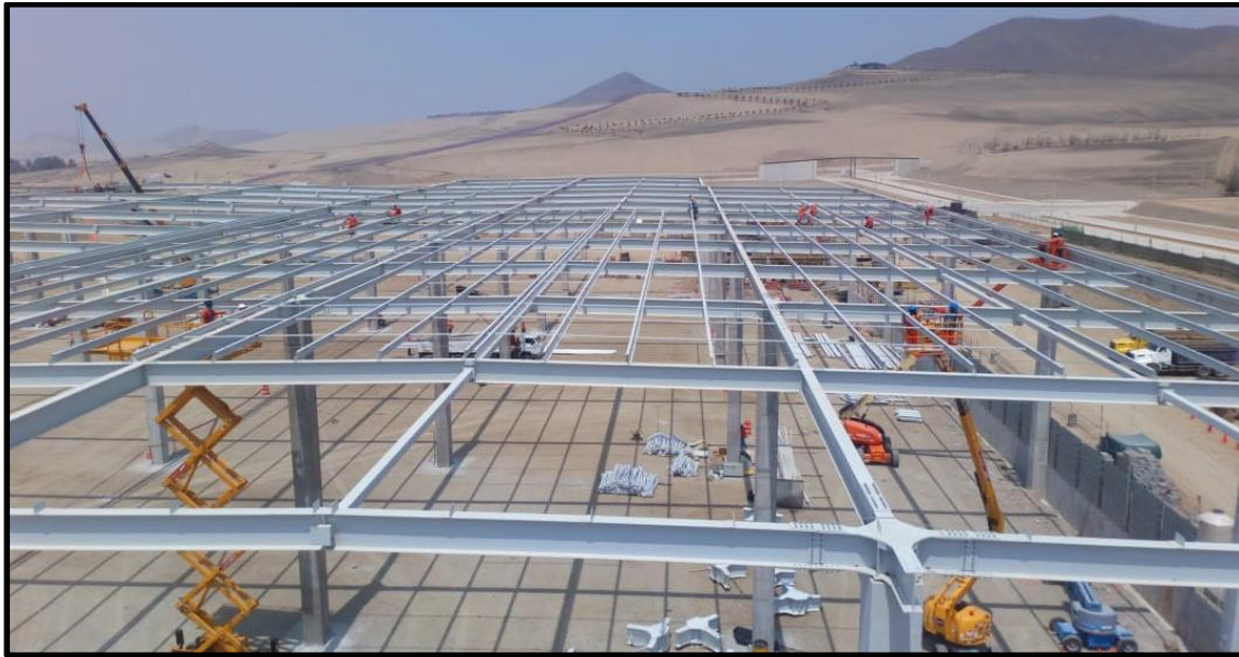
FIGURA 92: Instalación de Colgadores entre Correas de Techo.
