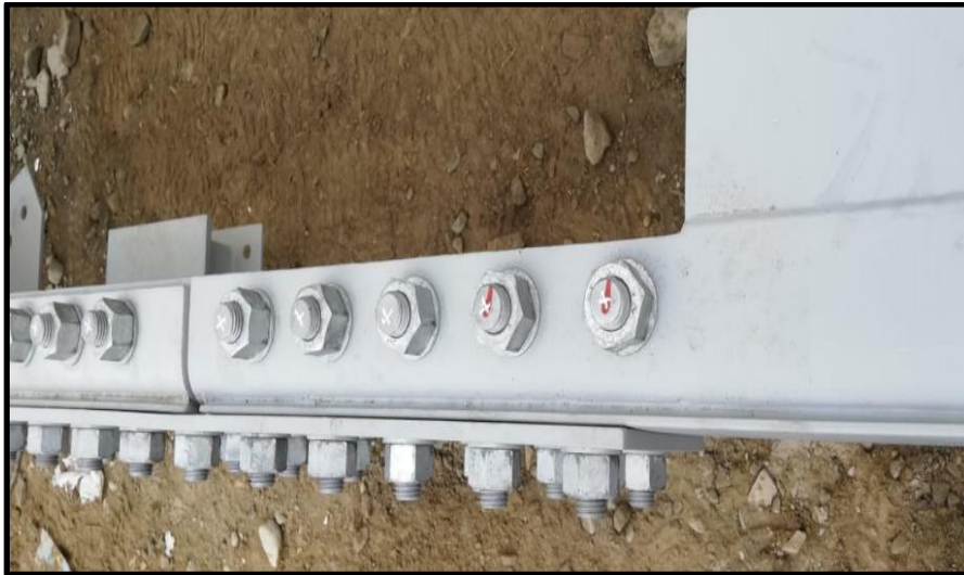
FIGURA 61: Marcado de pernos verificados
