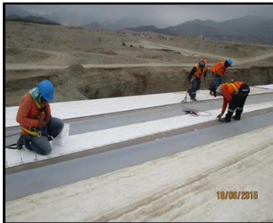
FIGURA 17: Instalación de Cobertura - CD SODIMAC - LURIN
