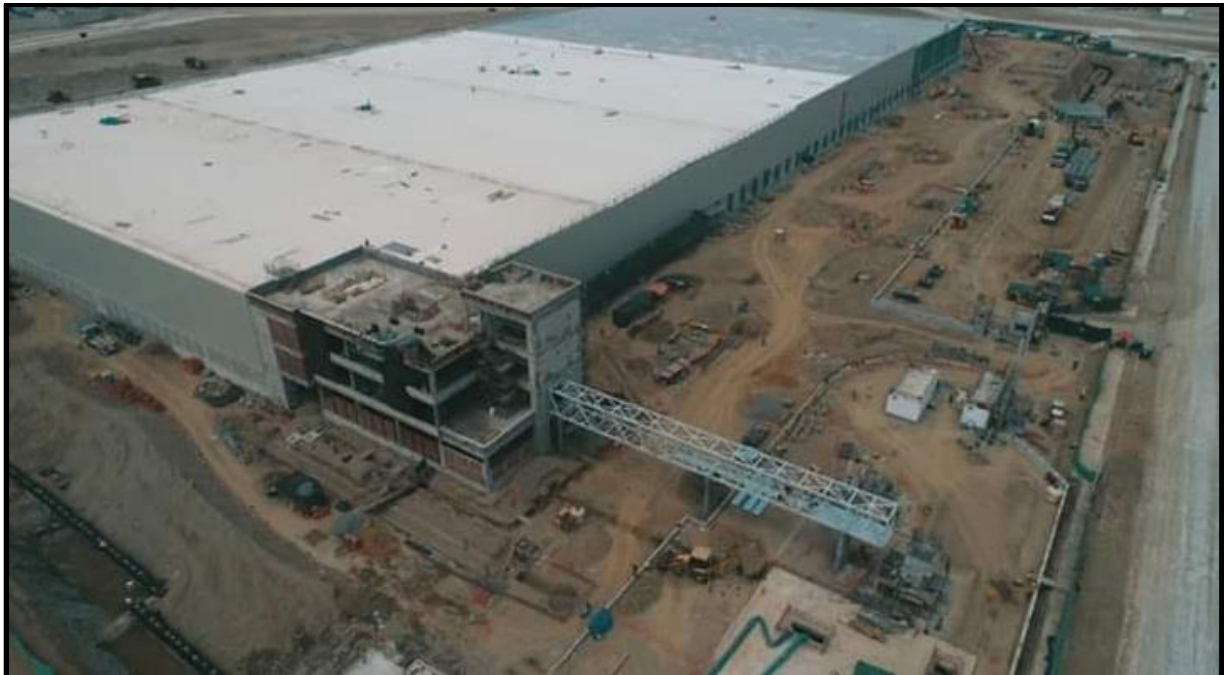
FIGURA 32: MONTAJE DE COBERTURA – CD SAGA FALABELLA.
