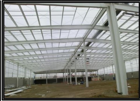
FIGURA 24: Montaje de Estructuras Metálicas
