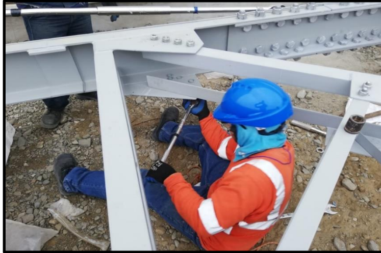
FIGURA 59: Ajuste de empalme
