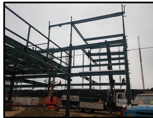
FIGURA 18: Montaje de Estructura Metálica - CENTRO COMERCIAL VIVANDA - ASIA
