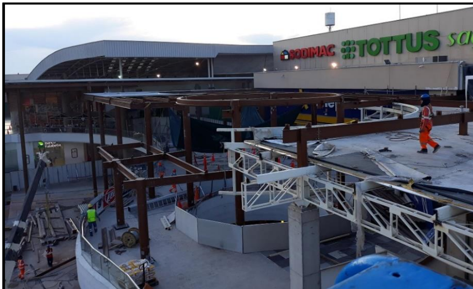
FIGURA 27: Montaje de estructuras – Open Plaza - Pucallpa
