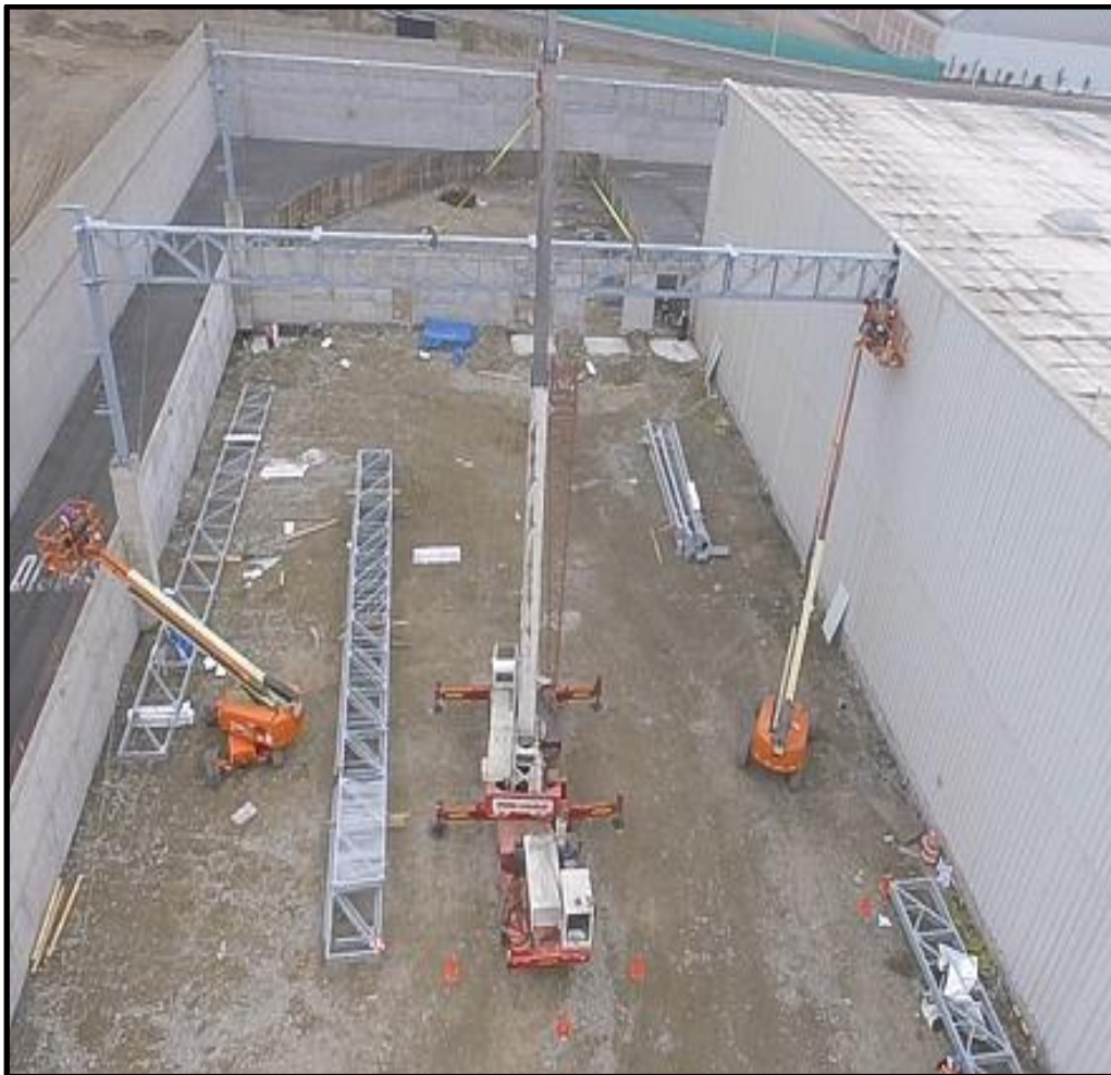
FIGURA 63: Montaje de pórtico empalmado
