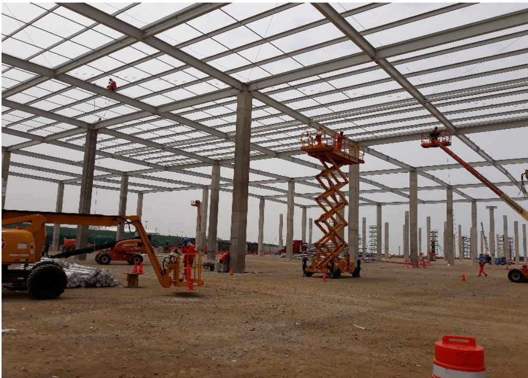
FIGURA 95: Montaje de estructuras metálicas.
