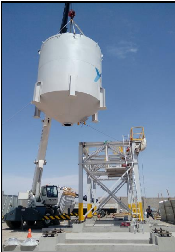
FIGURA 21: EXSA - SILOS DE EMULISIÓN MATRIZ - TACNA
