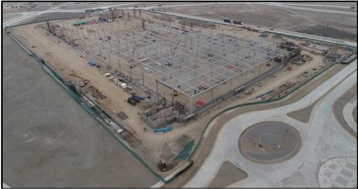
FIGURA 31: MONTAJE DE ESTRUCTURAS METÁLICAS – CD SAGA FALABELLA.
