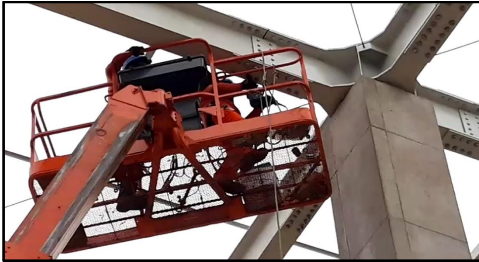
FIGURA 84: Ajuste de perno con pistola de impacto
