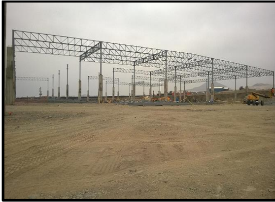
FIGURA 16: Montaje de Estructura Metálica - CD SODIMAC - LURIN
