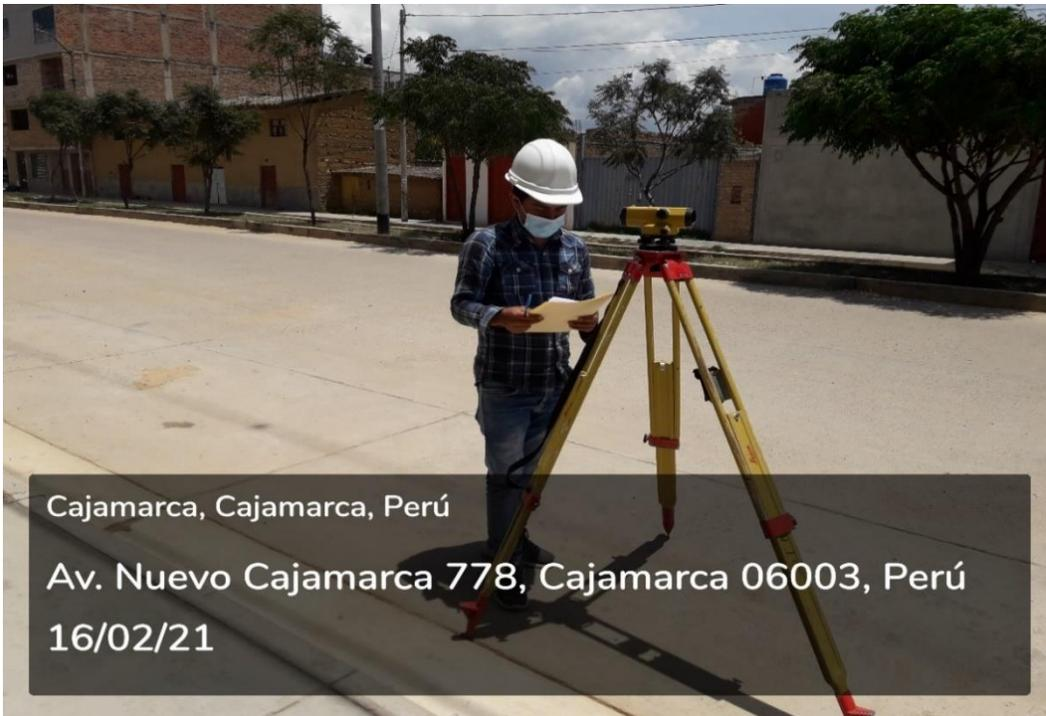
*Figura 41:* Tesista realizando la nivelación para obtener las pendientes de las cunetas de la Av. Nuevo Cajamarca.
