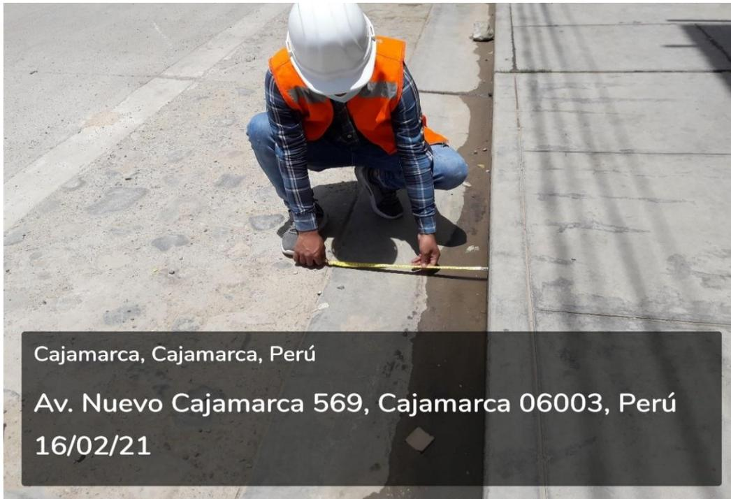
*Figura 37:* Tesista obteniendo el ancho de la cuneta en las calles de la Av. Nuevo Cajamarca.
