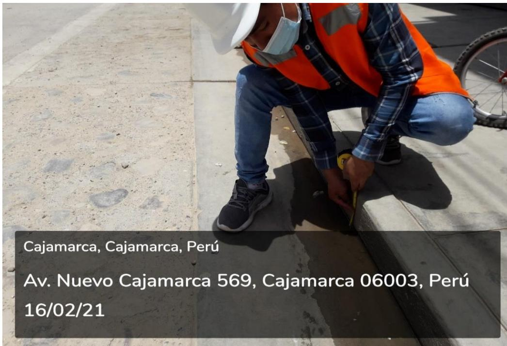
*Figura 38:* Tesista obteniendo la profundidad de la cuneta en las calles de la Av. Nuevo Cajamarca.
