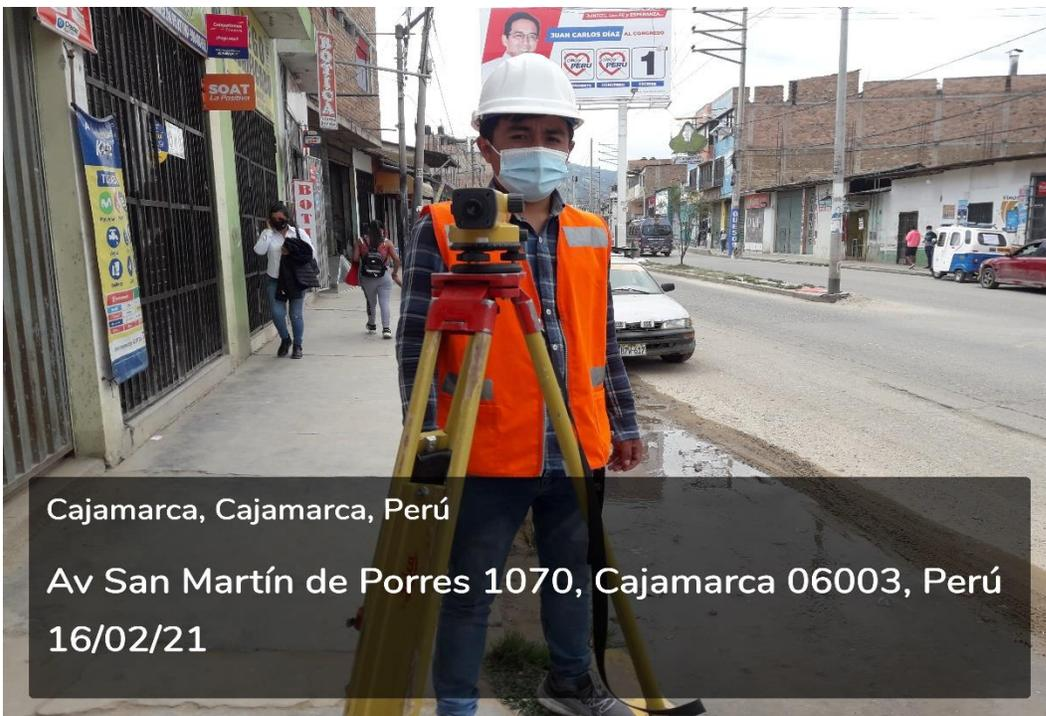
*Figura 42:* Nivelación para la obtención de las pendientes de las cunetas de la Av. San Martín de Porres.
