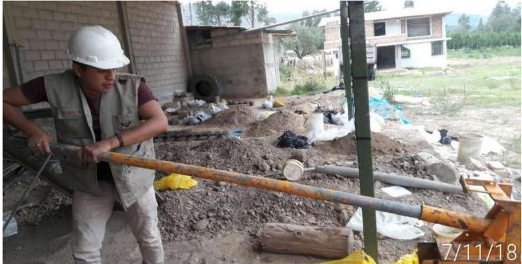
*Figura 15.* Prensado del material para elaboración del bloque de tierra.
