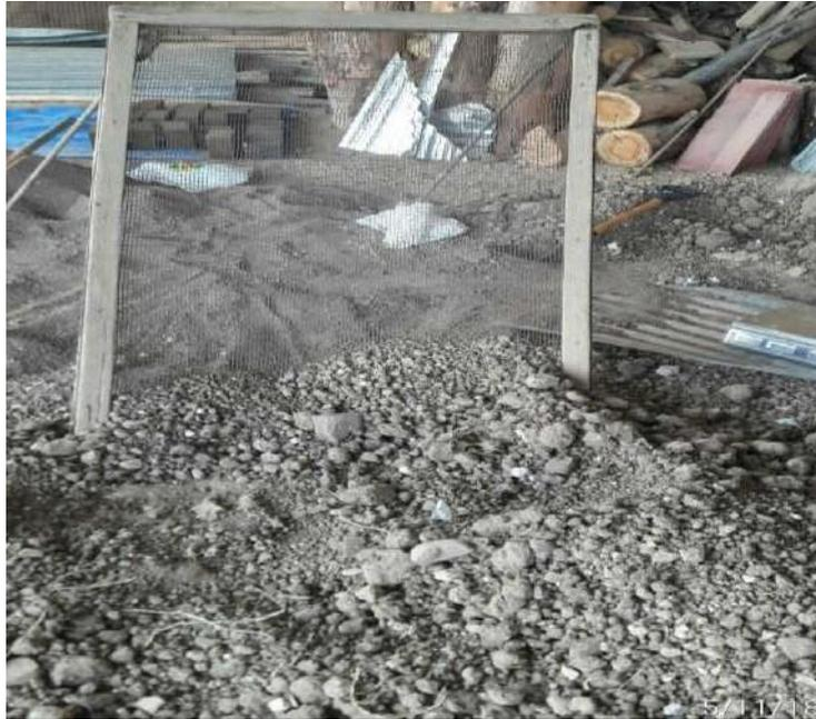
*Figura 12.* Tamizado del material para elaboración de los bloques de tierra.
