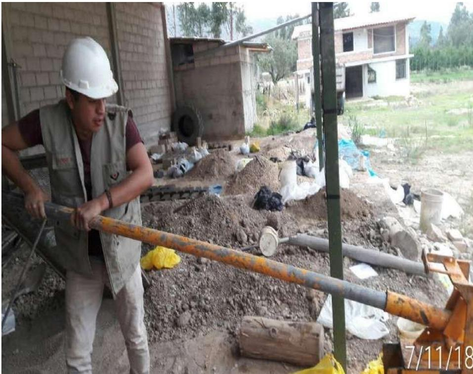
*Figura 46.* Prensado del material de tierra en la maquina Cinva-ram.
