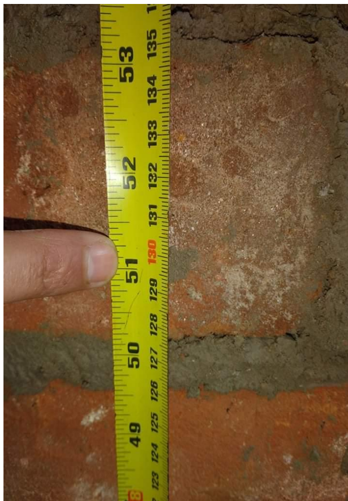
Figura 23. Construye muros durante una jornada de trabajo de más de 1.30m de altura.
