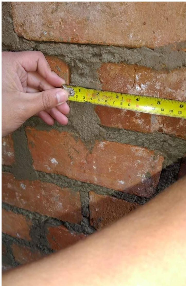
Figura 25. Juntas verticales como horizontales son mayores a 15mm
