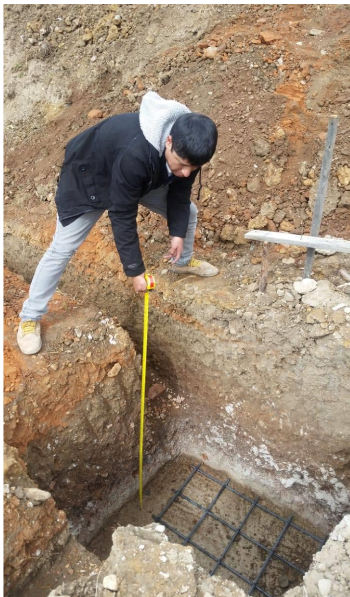
Figura 21. Medición de la profundidad de cimentación.
