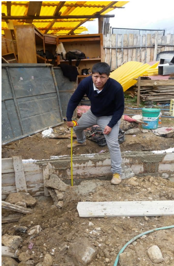
Figura 20. Medición de la altura del sobrecimiento
