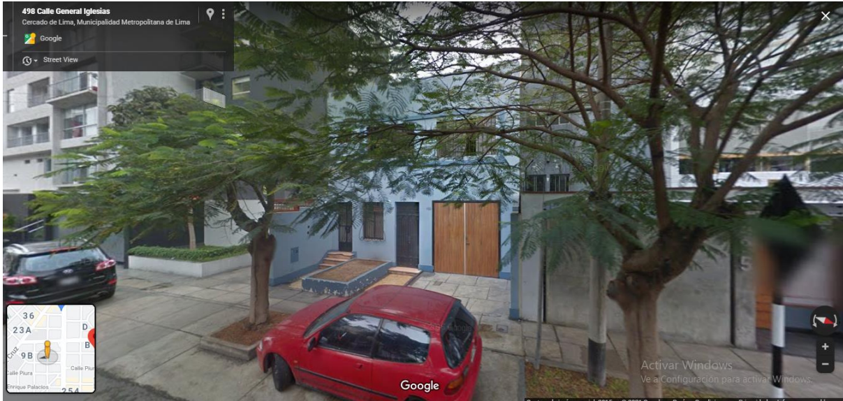
Figura 05. Ubicación del proyecto antes de la ejecución, Frente Calle General Iglesias.
