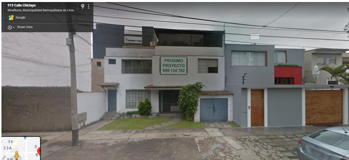
Figura 04. Ubicación del proyecto antes de la ejecución, Frente Calle Chiclayo.
