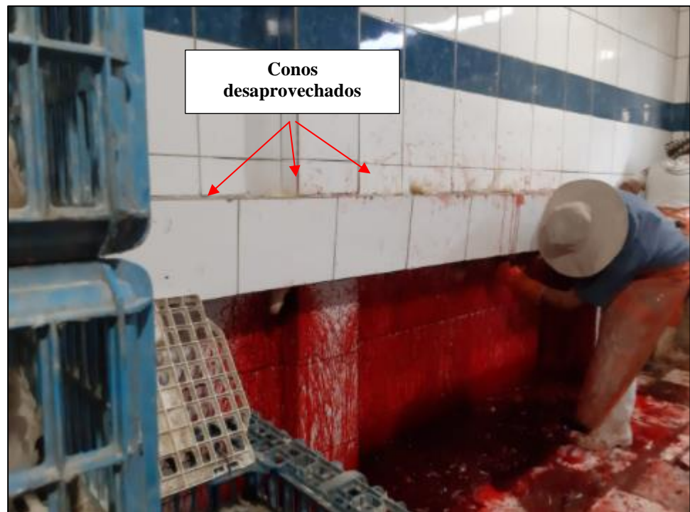
Figura 9. Conos degolladores desaprovechados.
