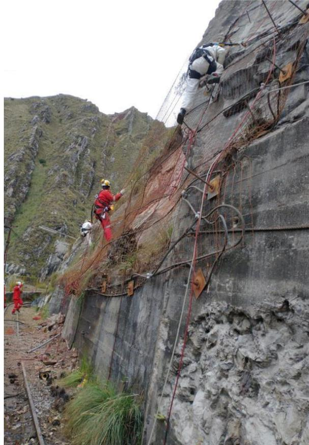
*Figura 5. Sostenimiento de taludes en operaciones mineras.*
