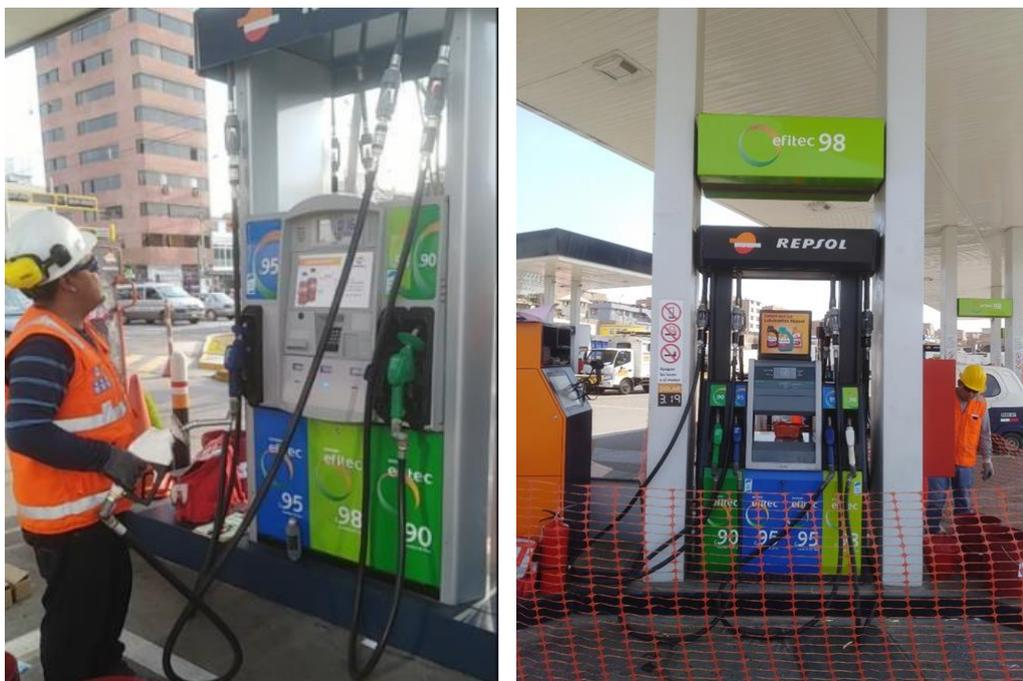
*Figura 16. Instalación de Visores de Combustible.
