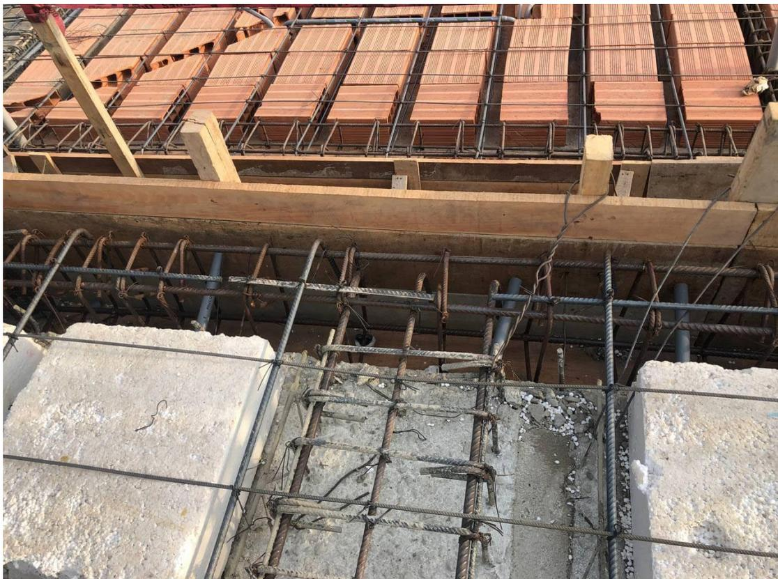
*Figura 36. Instalación de acero positivo.
