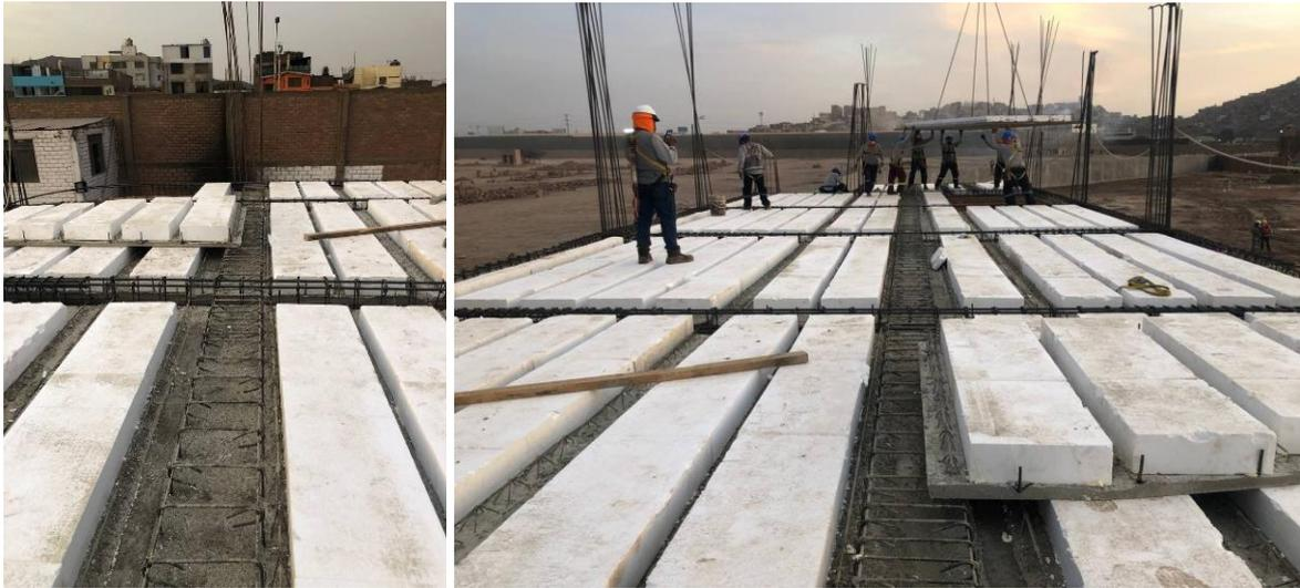
*Figura 34. Prelosas Instaladas.
