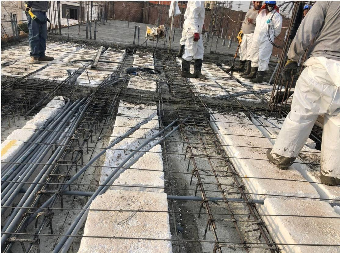
*Figura 35. Vaciado de concreto en prelosa aligerada.
