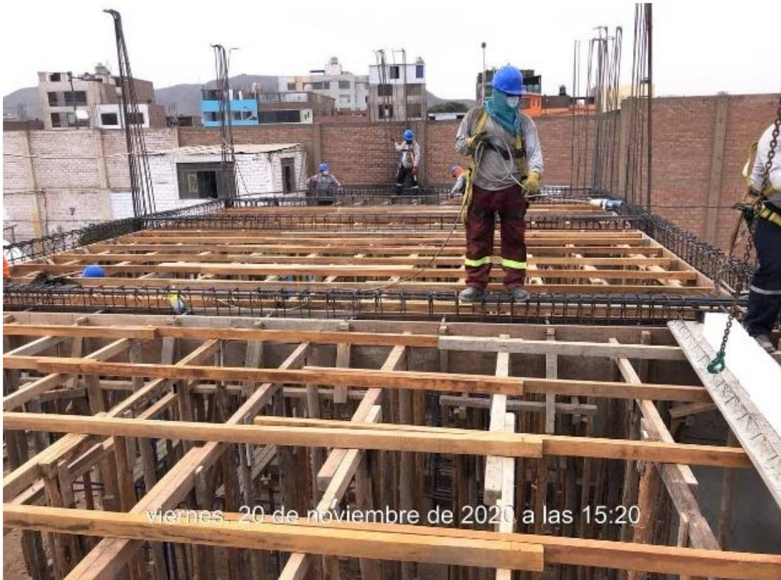
*Figura 30. Encofrado para Prelosa.
