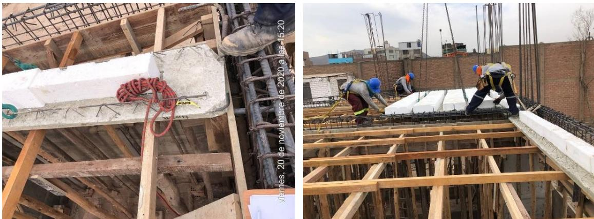
*Figura 33. Colocación de Prelosa.
