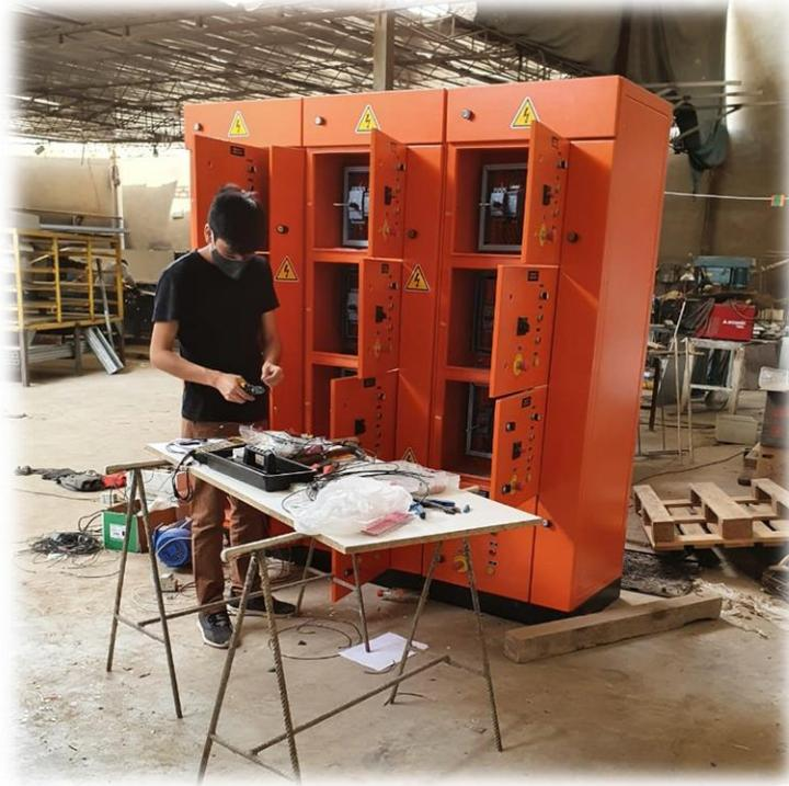
*Figura 1.3. Tablero Eléctrico - Centro de Control de Motores*
