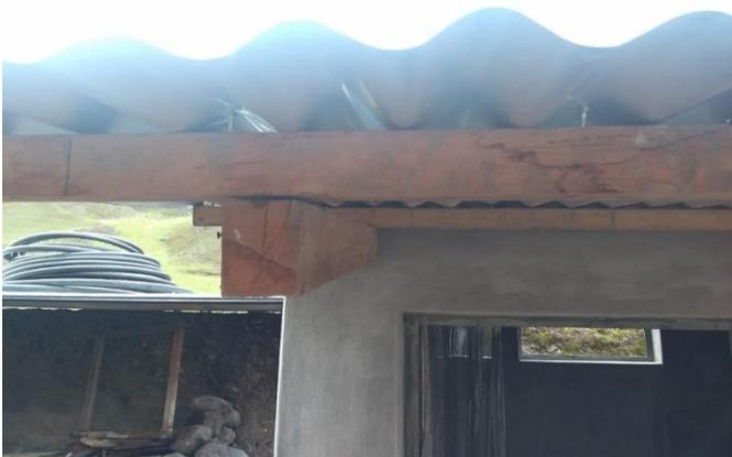
*Figura 19* Viguetas de madera mal clavadas
