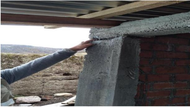
*Figura 12* Cangrejera en la fabricación columna
