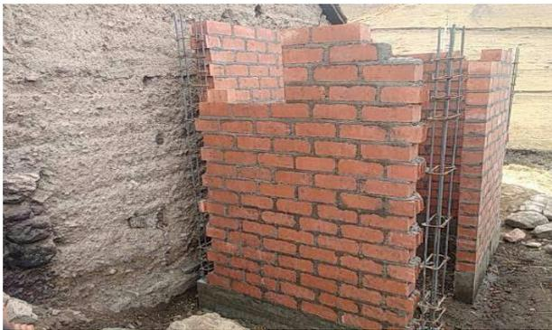
*Figura 13* Muro de ladrillo mal construido
