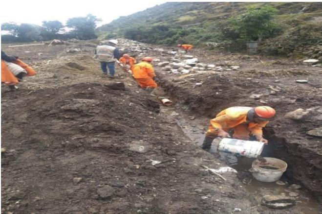
*Figura 18* Desplazamiento de zanjas por agua de lluvia
