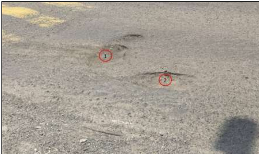
Figura 105: Hueco (Nivel Alto) – Carril Izquierdo
