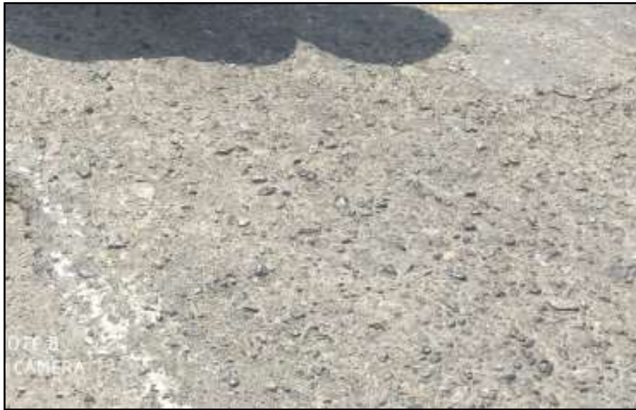
Figura 104: Pulimento De Agregados – Carril Izquierdo
