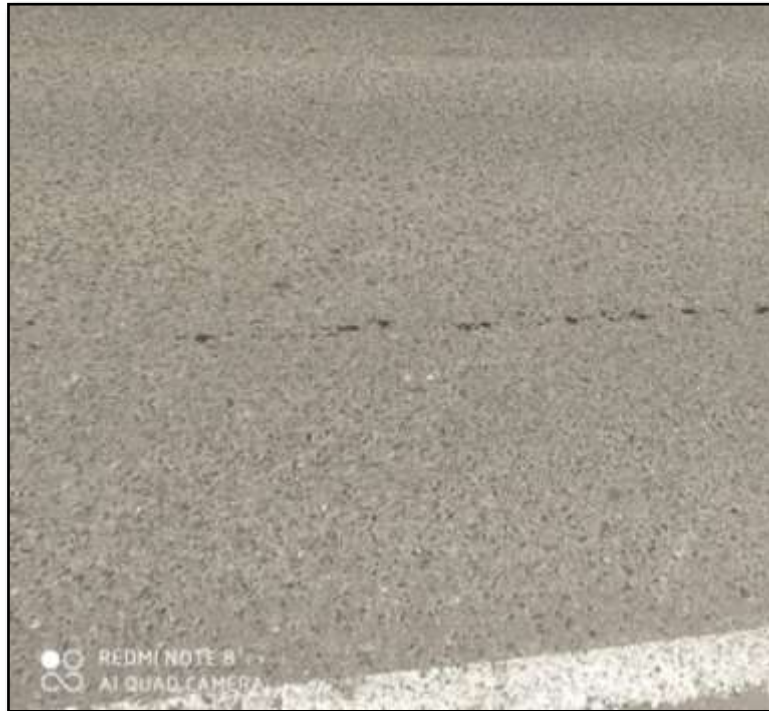
Figura 98: Pulimento De Agregado – Carril Izquierdo
