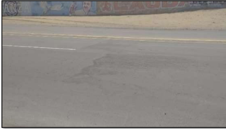
Figura 80: Pulimento De Agregado – Carril Izquierdo
