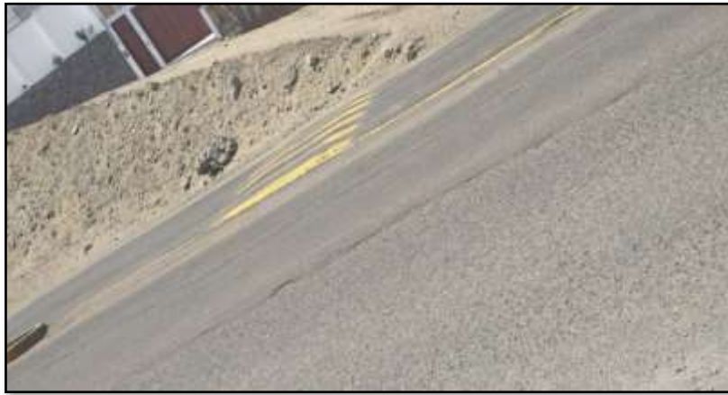
Figura 101: Ahuellamiento (Nivel Medio) – Carril Izquierdo
