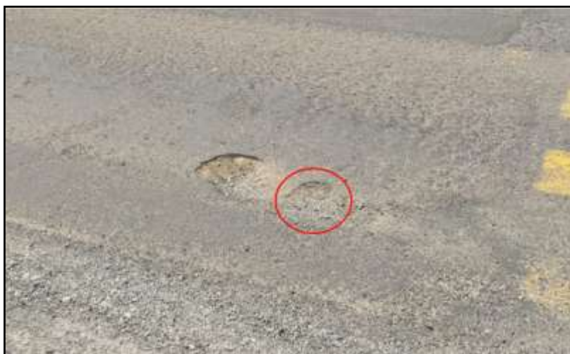
Figura 109: Hueco (Nivel Medio) – Carril Izquierdo
