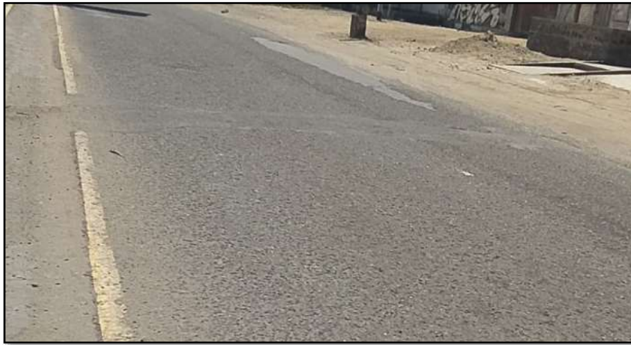
Figura 76: Falla Tipo Parcheo (Nivel Bajo) – Carril Derecho
