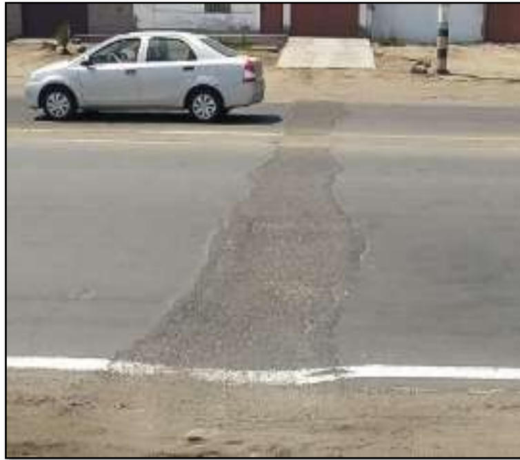
Figura 92: Depresión (Nivel Medio) – Carril Izquierdo
