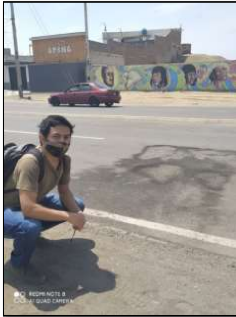
Figura 78: Falla Tipo Huecos (Nivel Medio) – Carril Izquierdo
