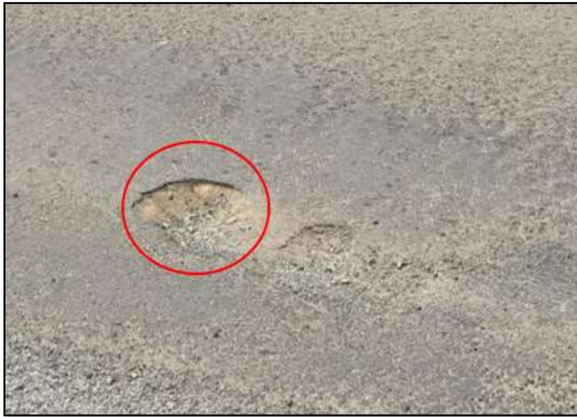
Figura 108: Hueco (Nivel Alto) – Carril Izquierdo
