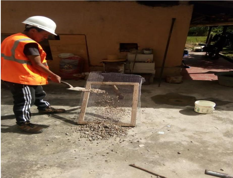
Figura 21: Tamizado de agregado grueso
