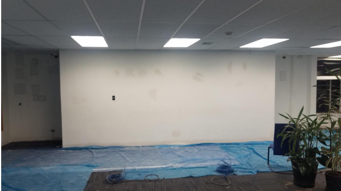
Imagen de una remodelación de oficinas para Movistar – Lima (fotografía propia de la empresa Inversiones & Contratistas ZAYD SAC)
