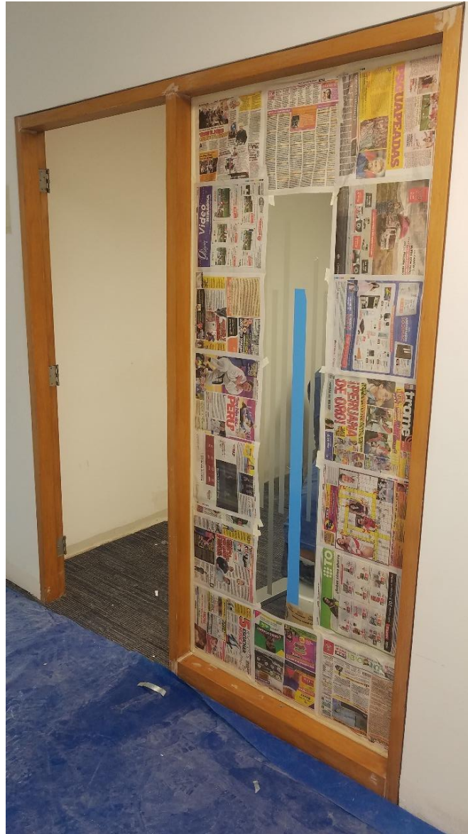
Imagen de una remodelación de oficinas para Movistar – Lima (fotografía propia de la empresa Inversiones & Contratistas ZAYD SAC)
