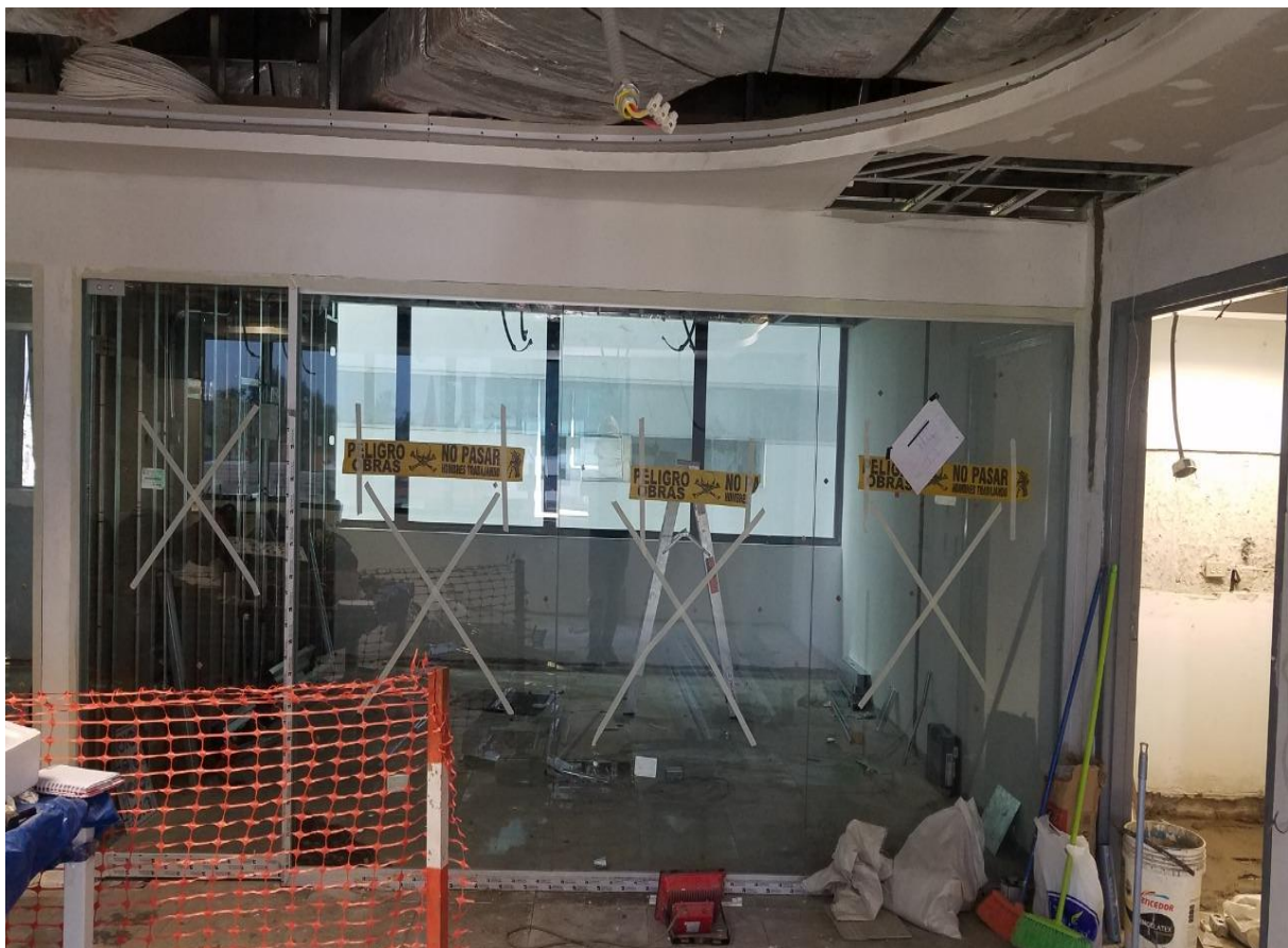
Imagen de una remodelación de oficinas para Movistar – Lima (fotografía propia de la empresa Inversiones & Contratistas ZAYD SAC)
