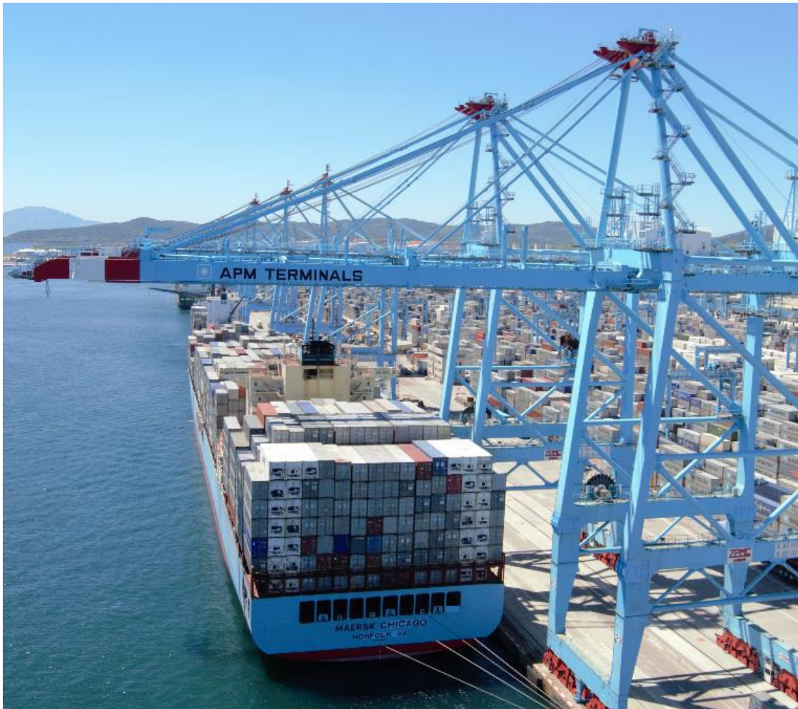
ILUSTRACIÓN 3: GRÚAS PÓRTICO DE MUELLE DURANTE UNA OPERACIÓN DE DESCARGA DE UN BUQUE (APM TERMINAL ALGECIRAS)
