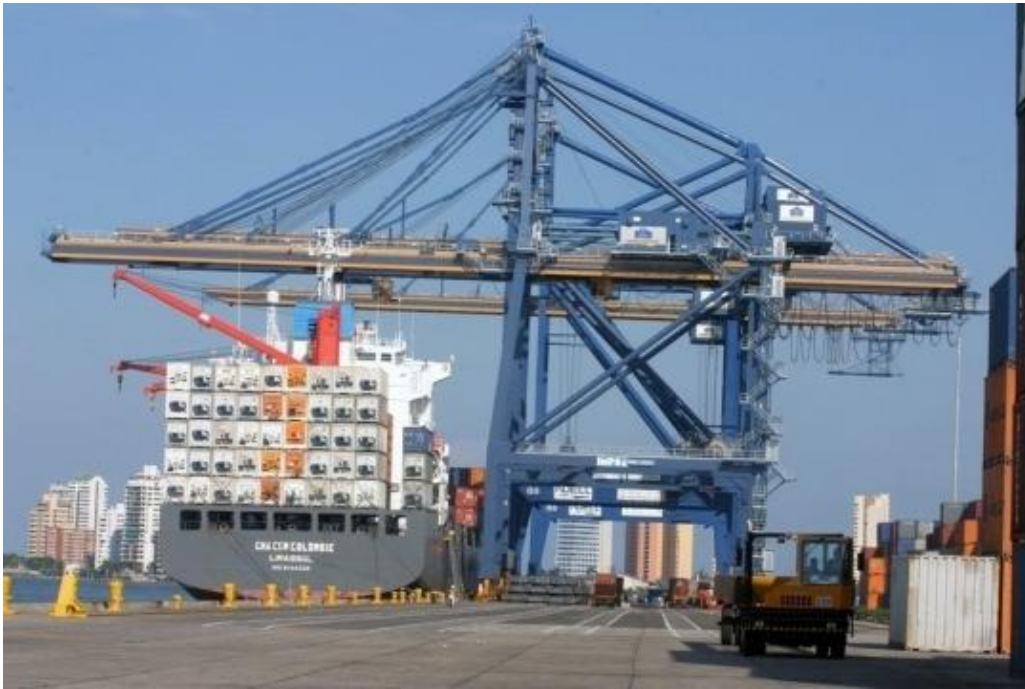
ILUSTRACIÓN 12: GRÚA PÓRTICO DE MUELLE
