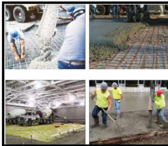
*Figura 32: Malla Electrosoldada reemplazada por Macrofibras.*
