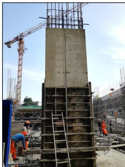
Figura 70. Encofrado vertical de columna, sótano 6.
