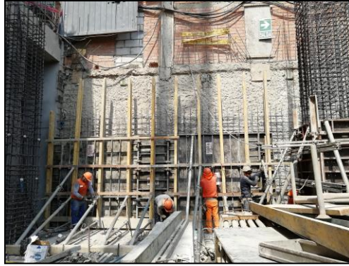
Figura 71. Encofrado vertical de placa, sótano 5.
