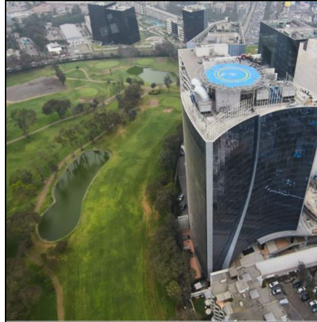
Figura 101. Vista aérea de la torre A con vista hacia el Golf Los Incas.
