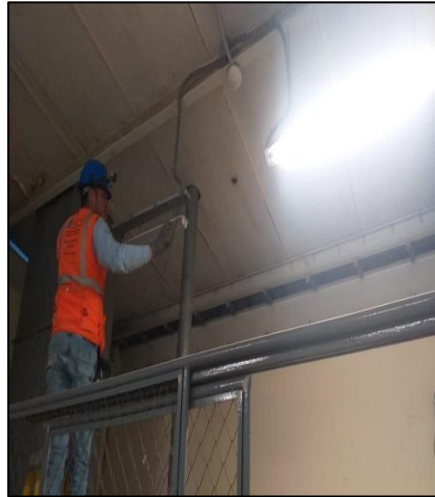
Figura 33. Desmontaje de luminarias antiguas, área de trastienda, nivel 1.
