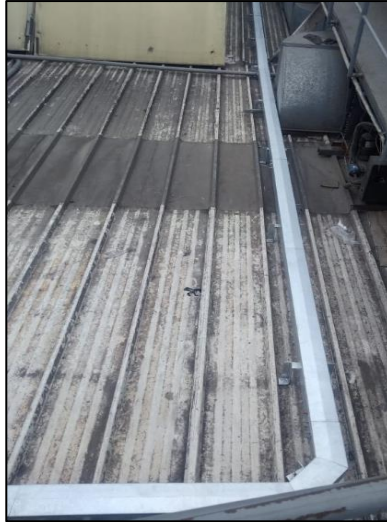
Figura 45. Instalación de bandeja y canalización en planta de techo.
