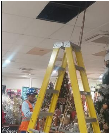
Figura 43. Tendido de alimentadores y sub alimentadores en sala de ventas, nivel 2.
