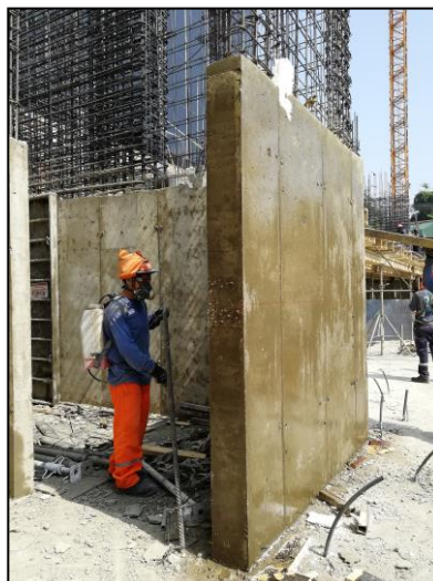
Figura 67. Placa desencofrada, sótano 9.
