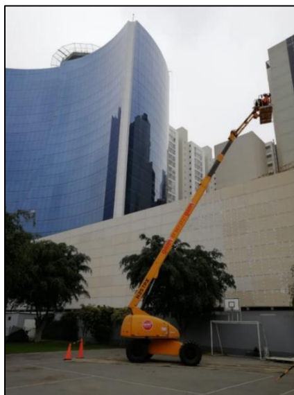
Figura 120. Supervisión de acabados de drywall, fachada Golf Colony, proyecto More.
