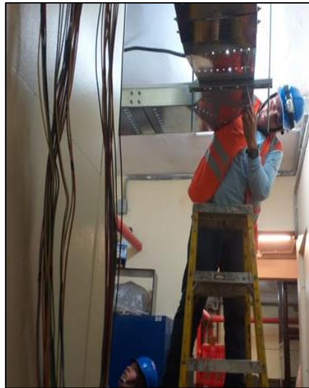
Figura 40. Instalación de bandeja Portacable en trastienda, nivel 2.
