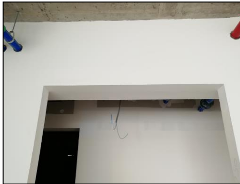
Figura 80. Masillado de drywall en dintel de puerta, piso 5.
