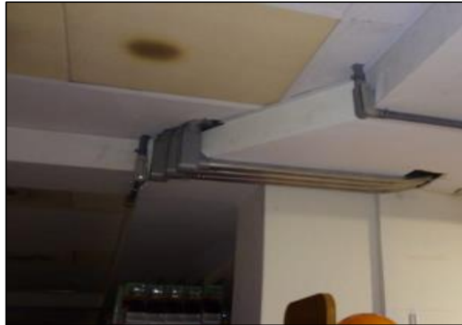
Figura 39. Instalación de entubado en sala de ventas, nivel 1.
