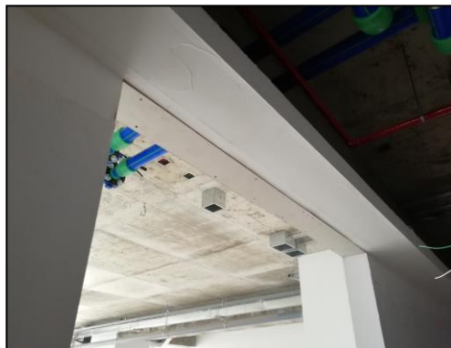
Figura 81. Remasillado de drywall en dintel de puerta, piso 5.
