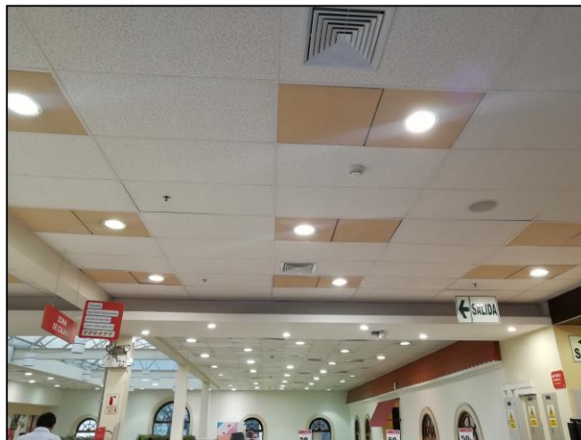
Figura 50. Instalación de downlights en baldosas, vista 3.
