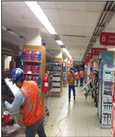
Figura 42. Tendido de alimentadores y sub alimentadores en sala de ventas, nivel 1.
