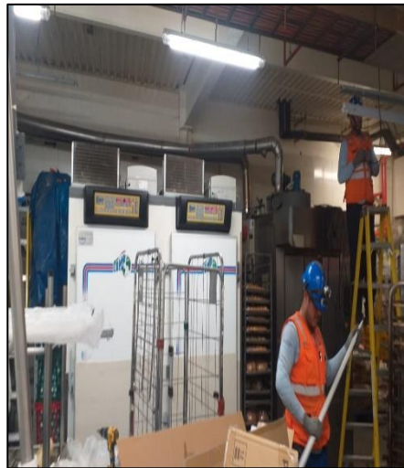
Figura 34. Desmontaje de luminarias antiguas, área de trastienda, nivel 1.
