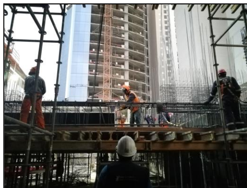
Figura 74. Encofrado horizontal con viguetas, sótano 2.
