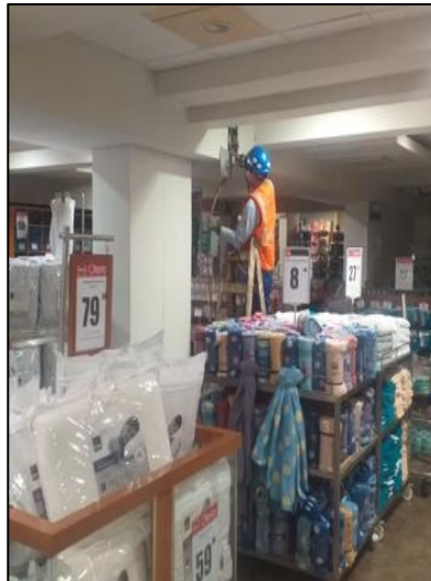
Figura 46. Tendido de alimentadores y sub alimentadores de luminarias en sala de ventas, nivel 2.
