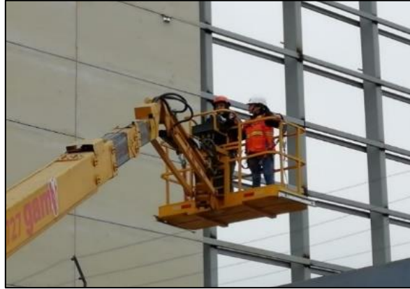
Figura 121. Supervisión de drywall en manlift, fachada Golf Colony, proyecto More.
