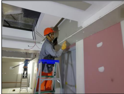
Figura 79. Instalación de planchas de drywall, piso 5.
