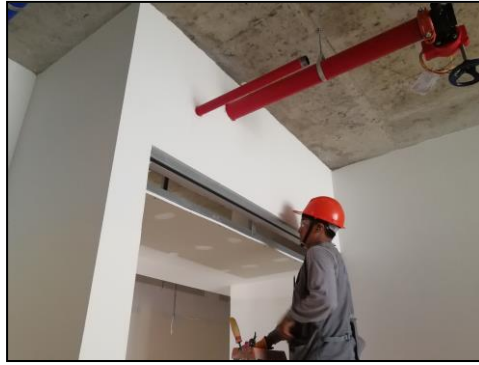
Figura 78. Instalación de perfilería de drywall, piso 5.
