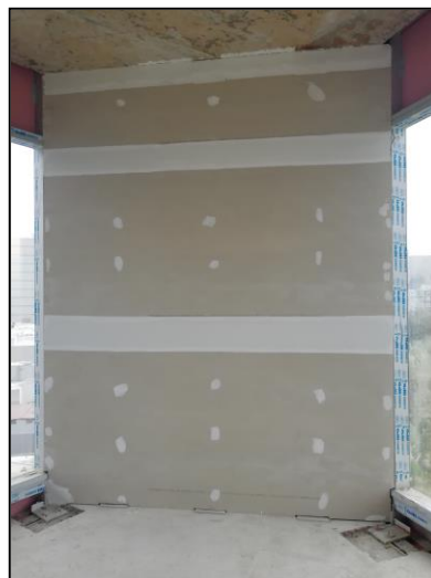
Figura 77. Instalación de plancha de superboard en pac de fachada, piso 2.
