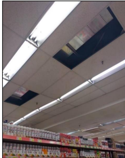
Figura 36. Desmontaje de luminarias antiguas en sala de ventas, nivel 1.
