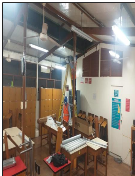
Figura 35. Desmontaje de luminarias antiguas, área de vestidores de trastienda, nivel 2.
