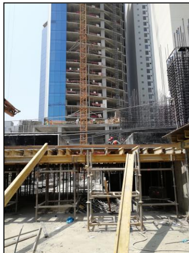
Figura 66. Encofrado horizontal con fenólicos y viguetas, sótano 10.
