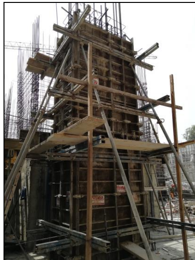
Figura 69. Encofrado vertical de columna, sótano 7.
