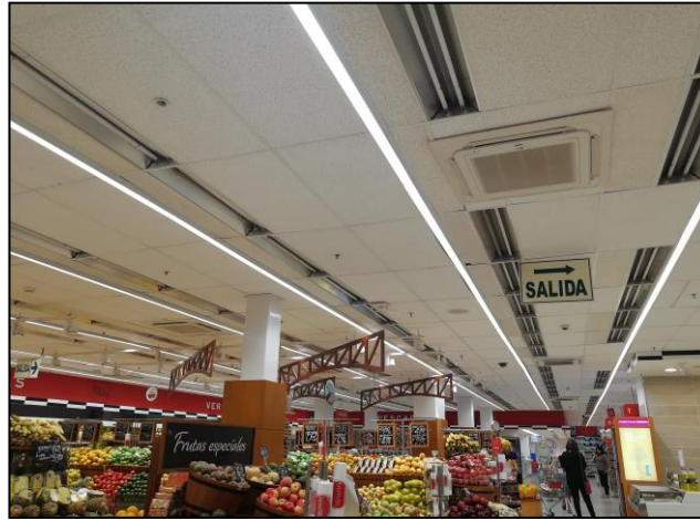
Figura 51. Instalación de luminarias lineales LED en sala de ventas, nivel 1.
