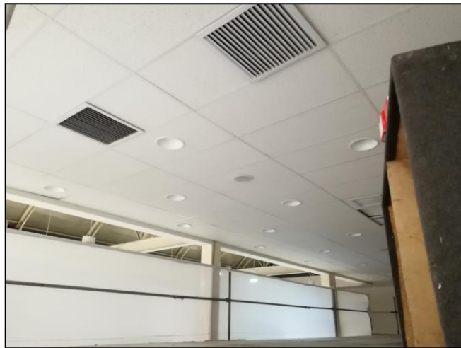
Figura 49. Instalación de downlights en baldosas, vista 2.
