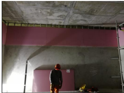
Figura 84. Instalación de perfilera de drywall, sótano 2.
