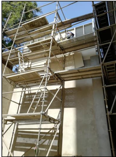
Figura 87. Instalación de perfilera y planchas de drywall en altura, sótano 1.
