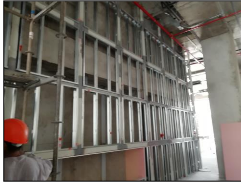
Figura 89. Instalación de perfilería de drywall vertical y horizontal, con refuerzos para instalación de planchas, sótano 1.
