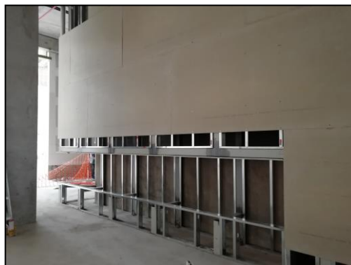
Figura 92. Instalación de plancha estándar en muro doble altura, sótano 1.
