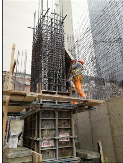
Figura 68. Encofrado vertical de columna, sótano 8.
