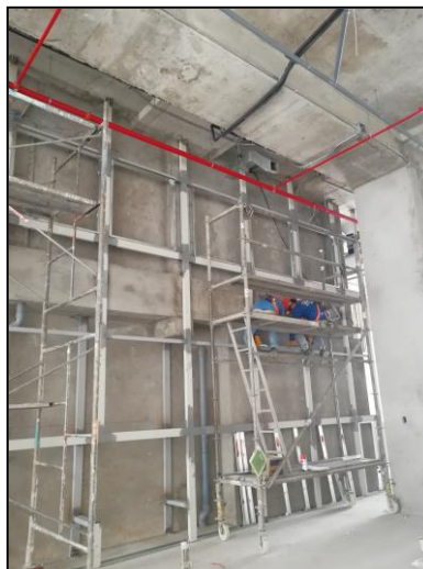
Figura 88. Instalación de perfilera de drywall en muro doble altura, sótano 1.
