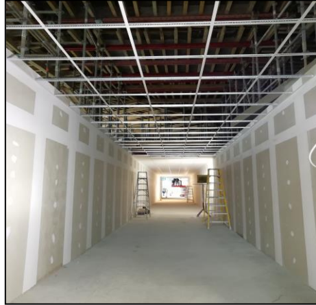
Figura 97. Instalación de perfilera de baldosas en pasillo peatonal, piso 1.
