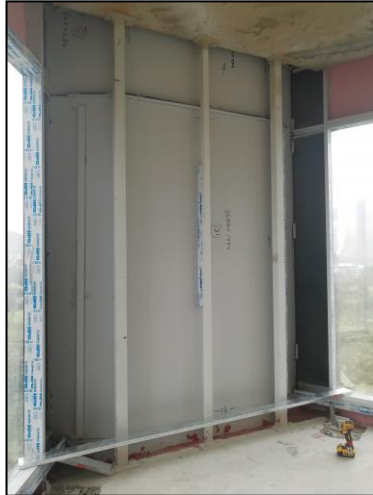
Figura 75. Instalación de estructura metálica de drywall en pac de fachada, piso 2.
