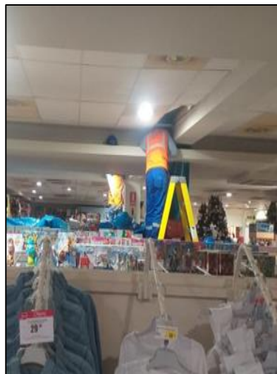
Figura 47. Tendido de alimentadores y canalización en sala de ventas, nivel 2.
