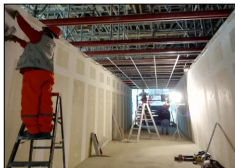
Figura 100. Masillado de planchas de drywall en pasillo peatonal, piso 1.
