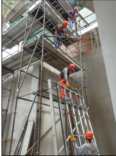
Figura 86. Armado de andamio para instalación de drywall en altura, sótano 1.
