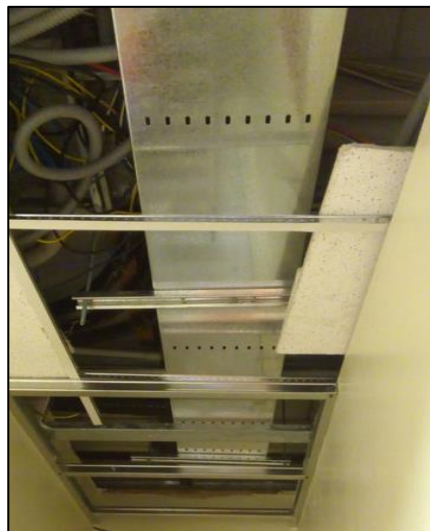
Figura 37. Instalación de bandejas portacables ubicado en trastienda, nivel 1.
