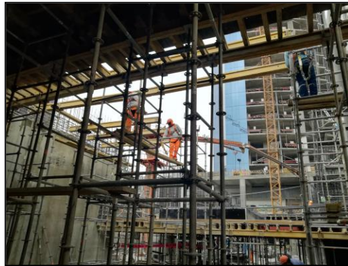
Figura 72. Encofrado horizontal con viguetas, sótano 4.
