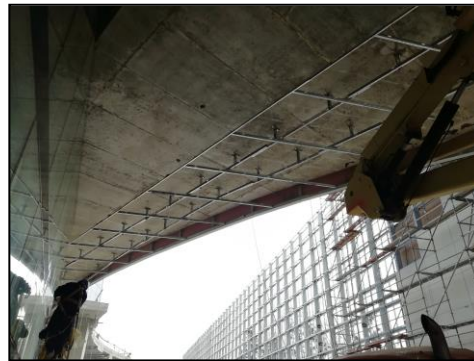
Figura 94. Instalación de perfilería de drywall horizontal en techo de concreto con refuerzos para instalación de planchas de aluminio, piso 1, vista 2.
