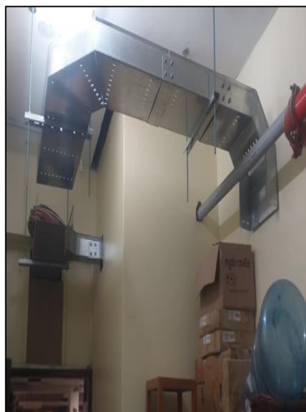
Figura 38. Instalación de bandejas portacables ubicado en trastienda, nivel 2.
