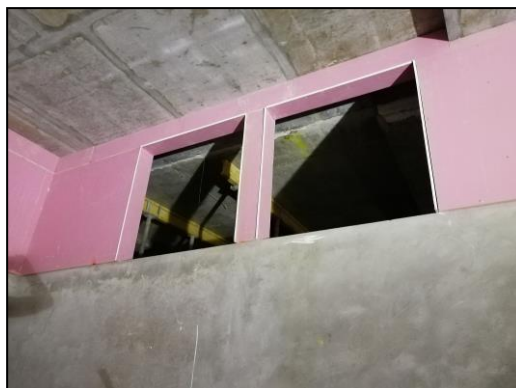
Figura 85. Instalación de plancha RF de drywall por ambos lados del muro, sótano 2.
