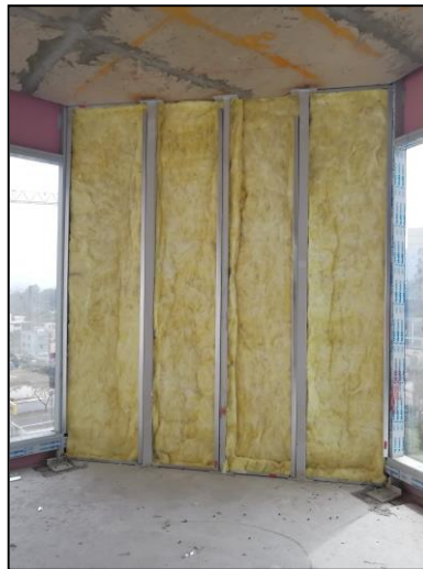
Figura 76. Instalación de lana de fibra de vidrio en pac de fachada, piso 2.
