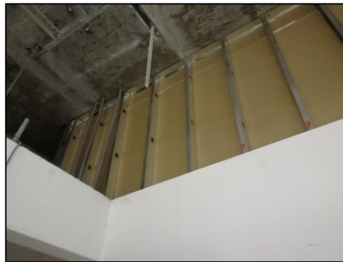
Figura 83. Instalación de plancha RF de drywall sobre muro de albañilería, sótano 2.
