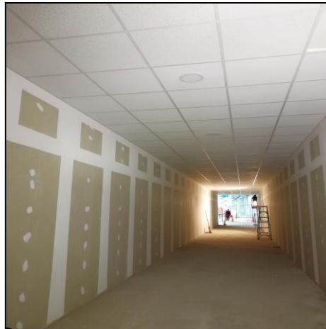
Figura 99. Instalación de planchas estándar de drywall para muros de pasillo de ingreso.
