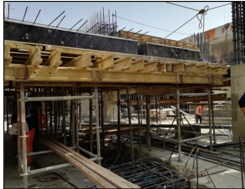
Figura 73. Encofrado horizontal con viguetas, sótano 3.
