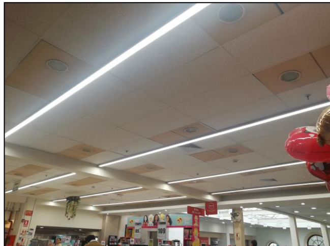
Figura 52. Instalación de luminarias lineales LED en sala de ventas, nivel 2.
