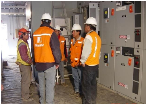
Figura 21. Pruebas iniciales de funcionamiento
