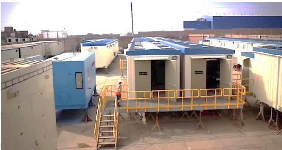
Figura 1. Planta de Ensamblaje de Salas Eléctricas de la empresa DIMATIC SAC
