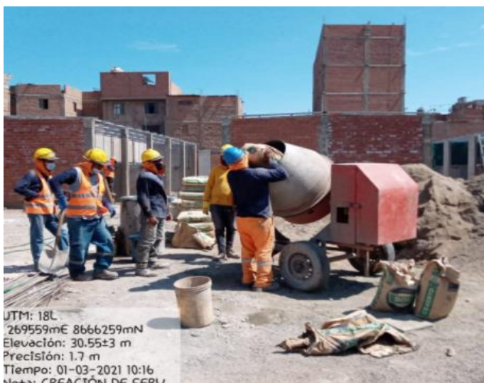
Figura 32 Evidencia de las labores de apoyo
