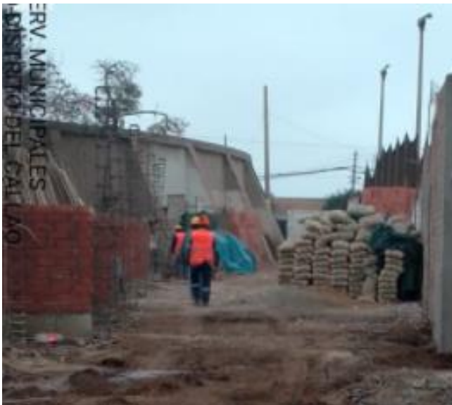
Figura 19 Trabajos de construcción
