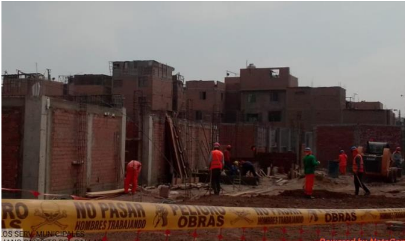
Figura 27 Evidencia del cuidado de la seguridad en los trabajos de construcción Elaboración propia
