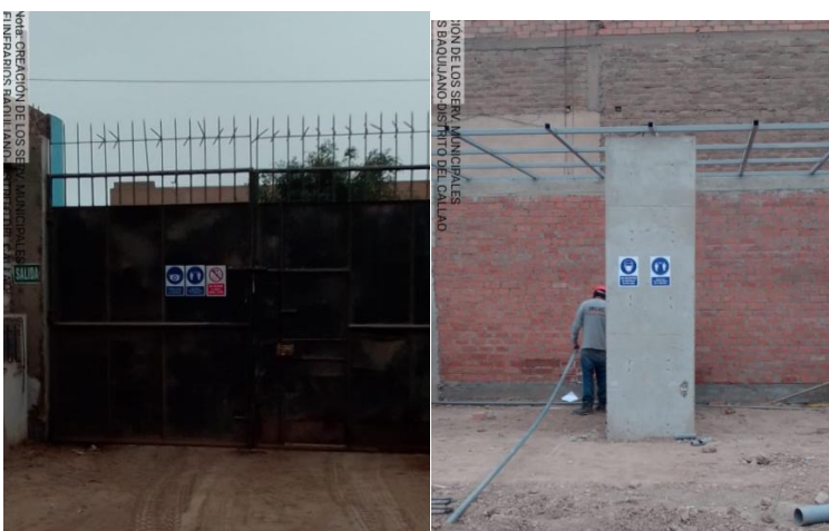
Figura 28 Evidencia de la señalización para el cuidado de la seguridad Elaboración propia
