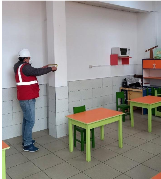
Figura 8. Medición de columnas pabellón A de la IE N° 055 Fuente: Elaborada por los autores
