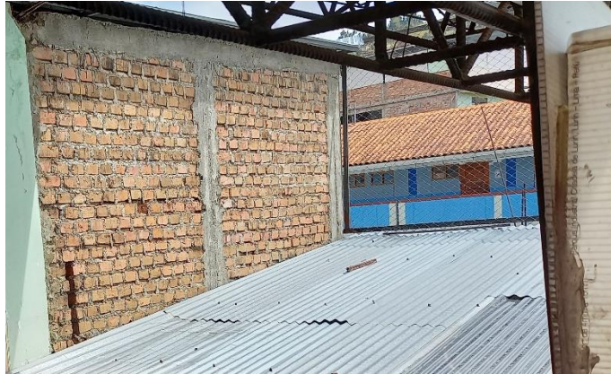
Figura 16. Ladrillo tipo macizo en los muros (Pabellón B) Fuente: Elaborada por los autores
