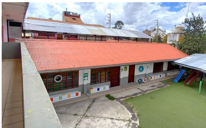
Figura 32. Cubierta pabellón D, amarrada y apoyada sobre losa aligerada Fuente: Elaborada por los autores
