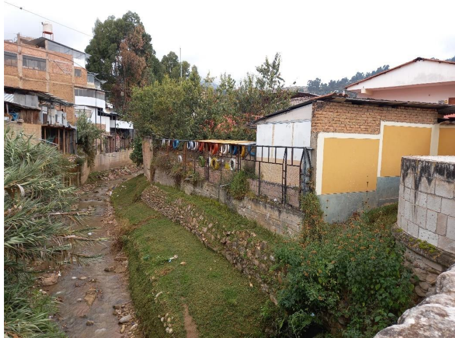
Figura 25. Vista posterior del pabellón E, colindancia con el río San Lucas Fuente: Elaborada por los autores
