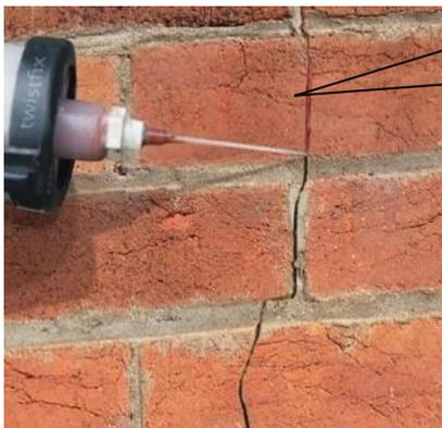
“Grieta” es la abertura incontrolada que afecta a todo el espesor del muro
