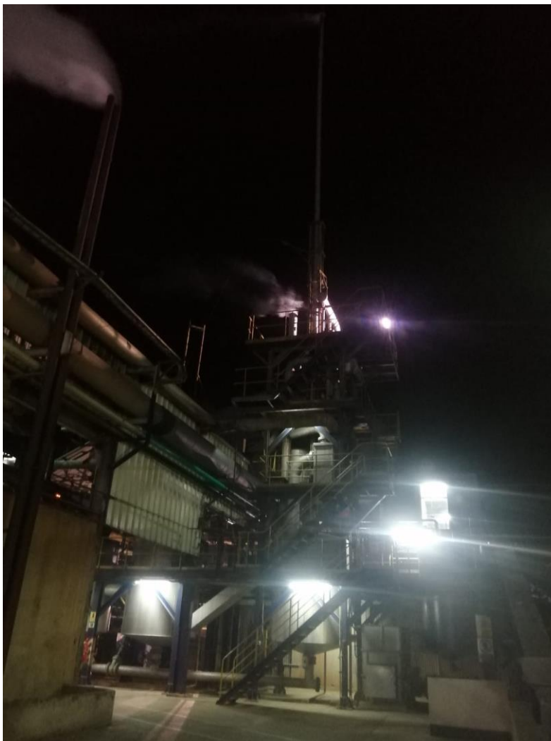
Figura 3: Tanques de encalamiento de jugo.
