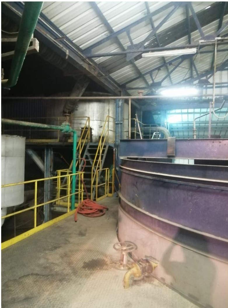
Figura 5: Clarificador de jugo SRI.
