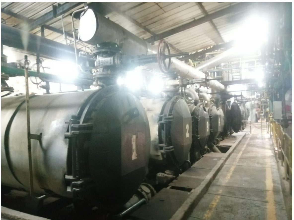
Figura 4: Calentadores de jugo encalado.
