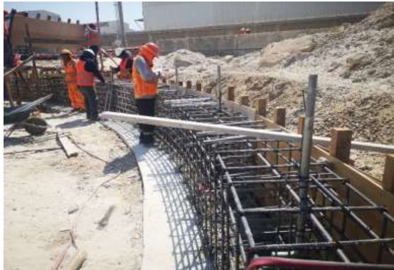
Figura 19. Colocación de perno de anclaje
