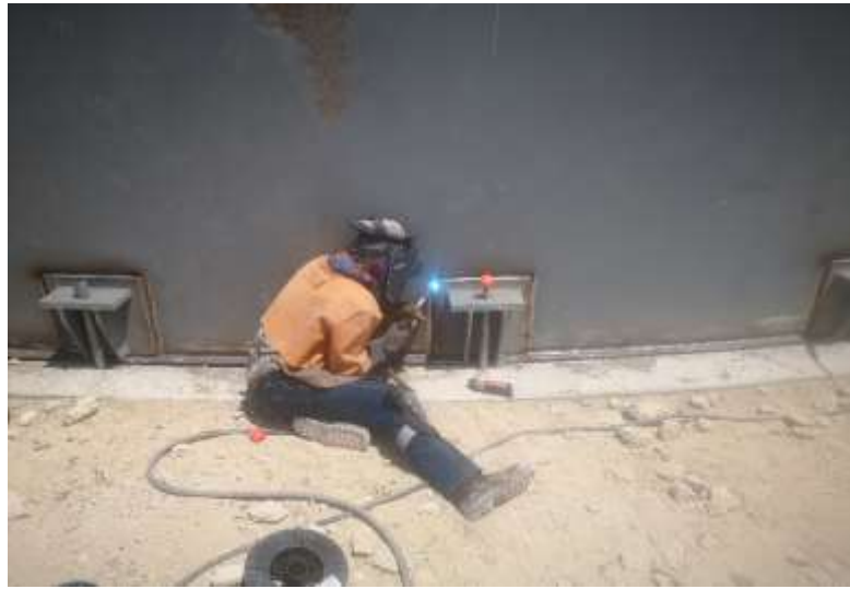
Figura 41. Soldeo de silletas
