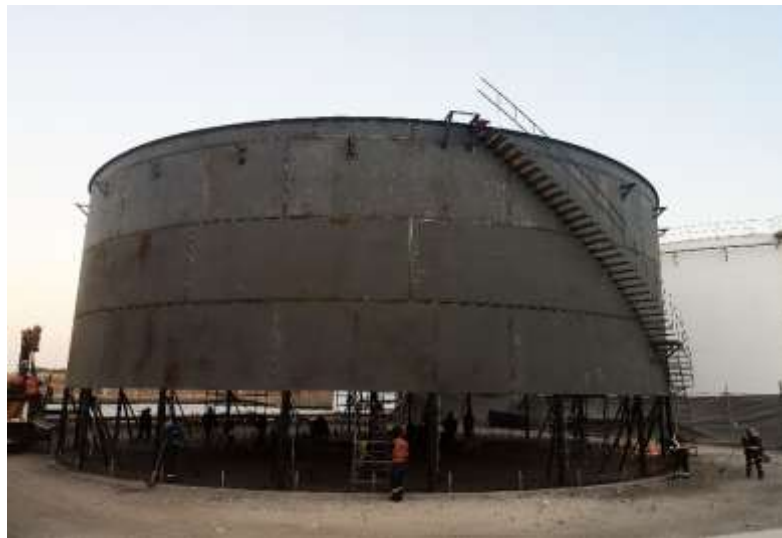
Figura 32. Montaje del tercer anillo
