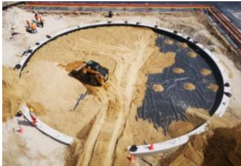
Figura 25. Colocación de relleno
