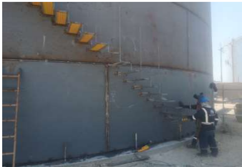
Figura 39. Soldeo de escaleras
