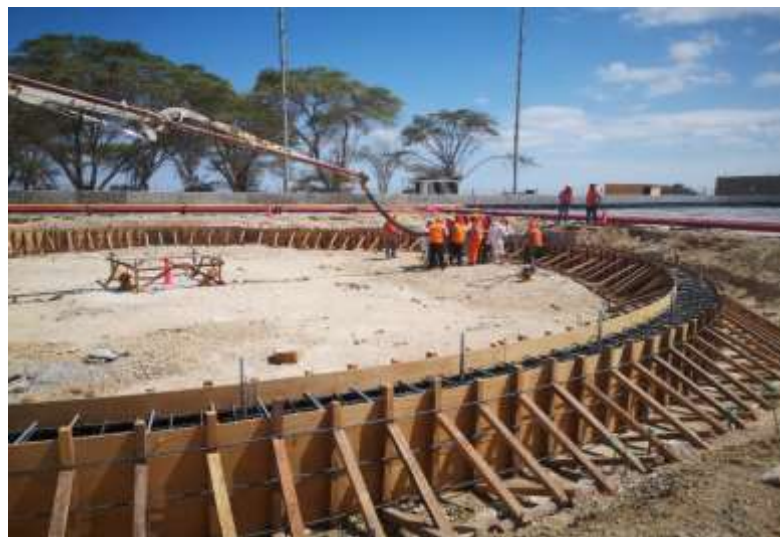
Figura 18. Encofrado
