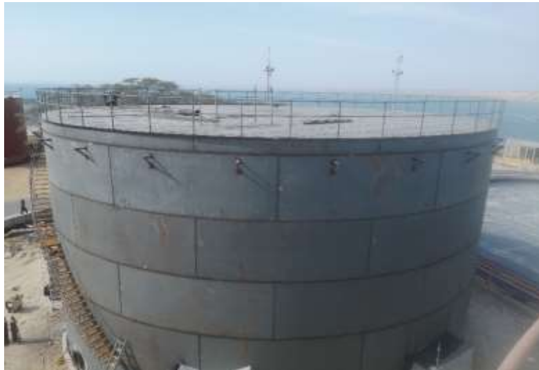
Figura 40. Colocación de barandas
