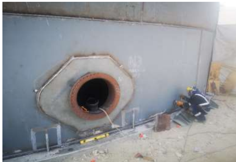
Figura 38. Colocación de manhole
