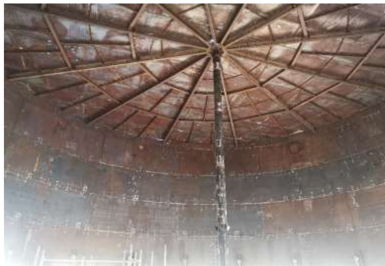
Figura 35. Montaje de techo
