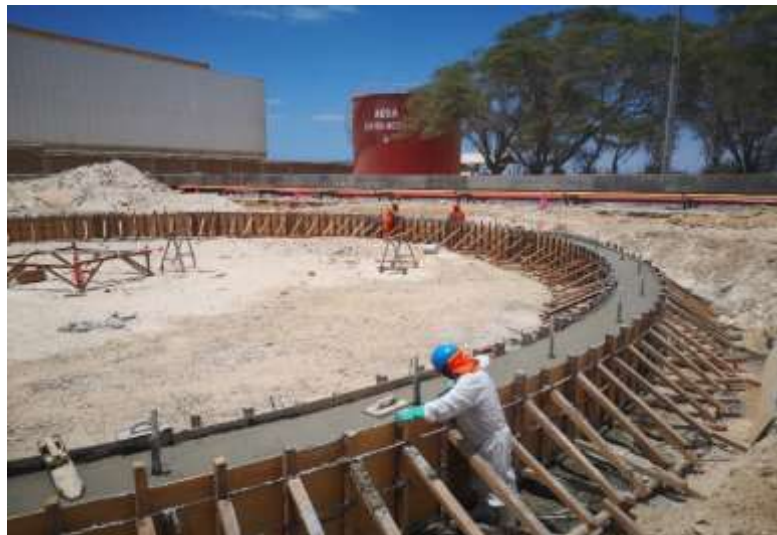
Figura 20. Vaciado de concreto
