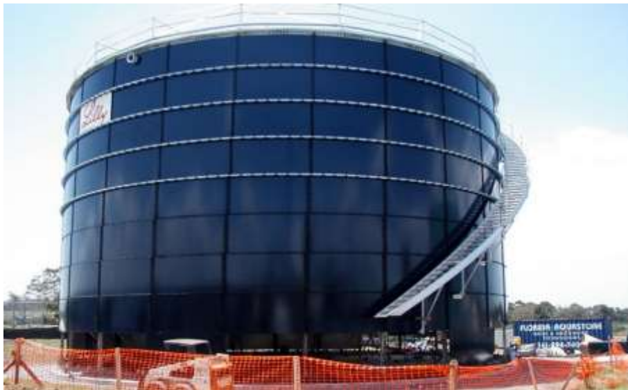
Figura 1. Tanque empernado
