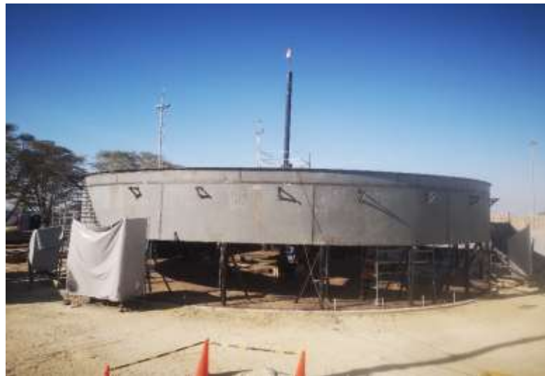
Figura 30. Montaje del quinto anillo
