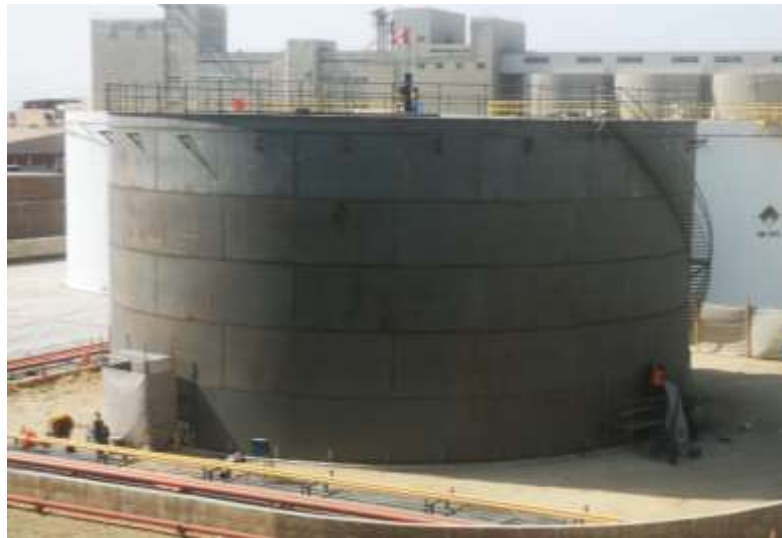
Figura 34. Montaje del primer anillo
