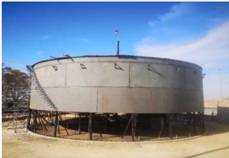
Figura 31. Montaje del cuarto anillo
