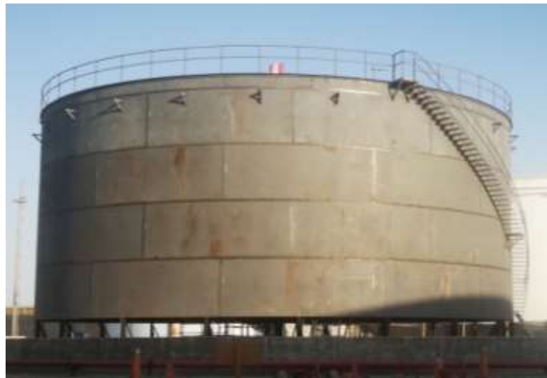
Figura 33. Montaje del segundo anillo
