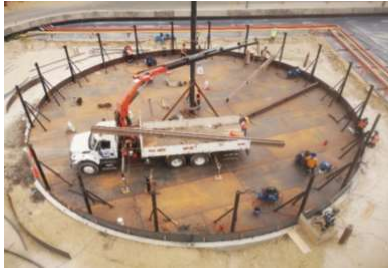
Figura 28. Colocación de teclas mecánicas
