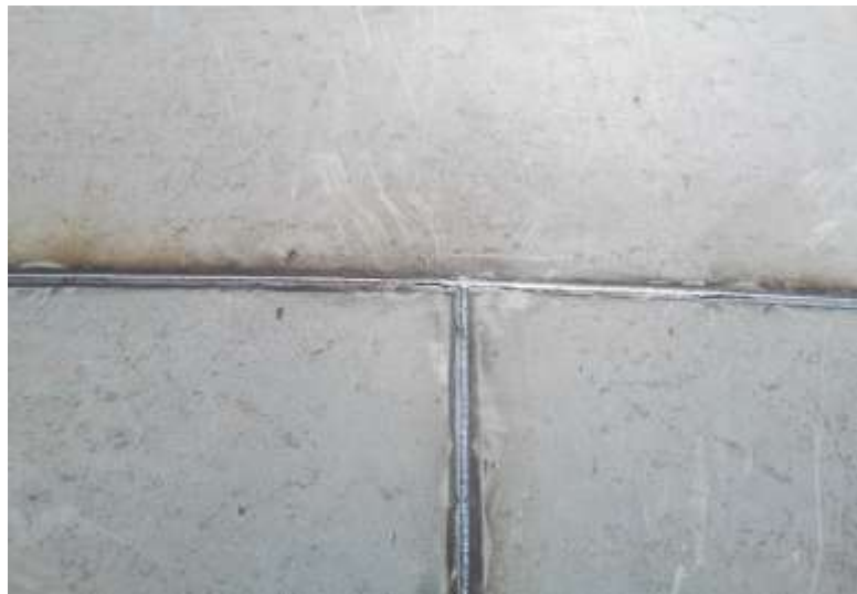
Figura 42. Inspección visual de soldadura
