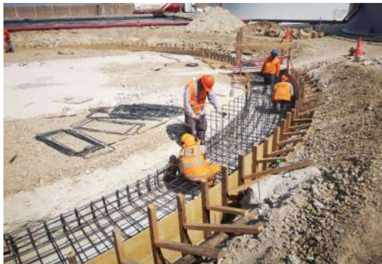
Figura 17. Armado de acero
