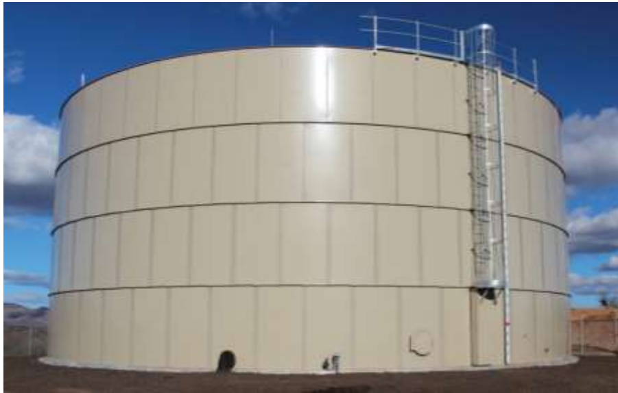
Figura 2. Tanque soldado
