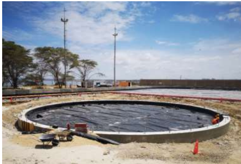
Figura 23. Colocación de geomembrana
