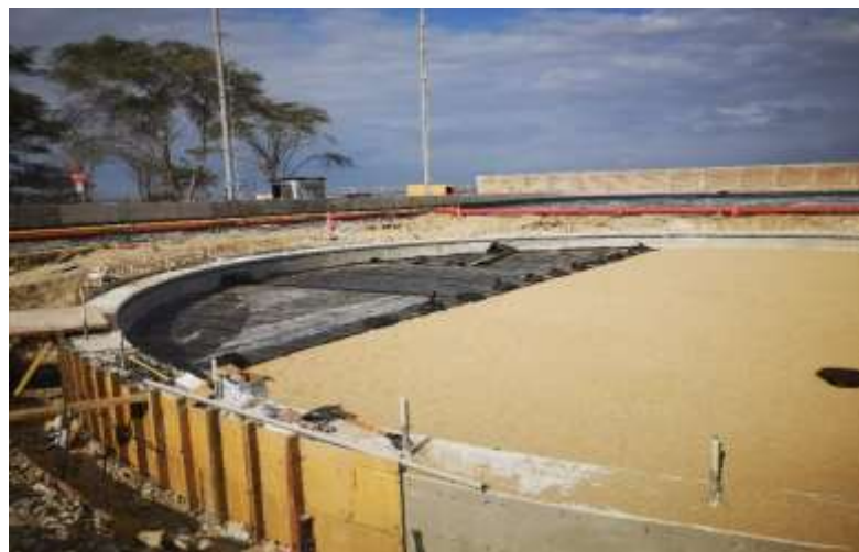
Figura 22. Desencofrado
