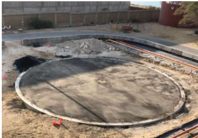
Figura 26. Colocación de asfalto
