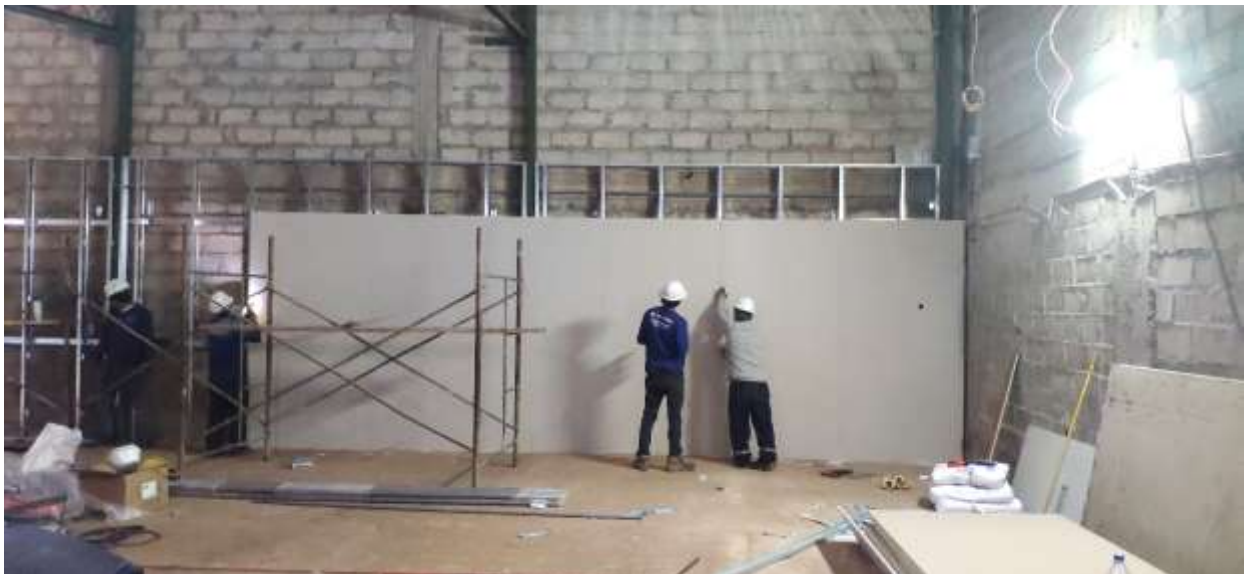
Colocación de Planchas de Drywall ST de 1/2" a 01 Cara
