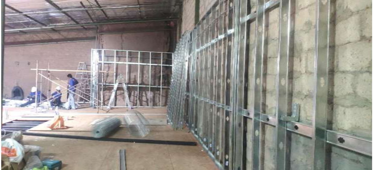
Armado de Estructura de Tabiquería Seca de Drywall Con Perfiles Galvanizados
