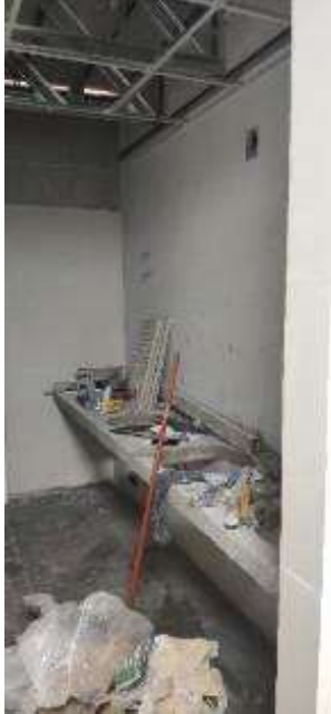
Armado de Mesa de Concreto para Lavatorios
