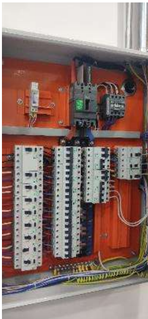
Instalación de Llaves Termomagnéticas, Llaves Diferenciales y Peinado de Cableado
