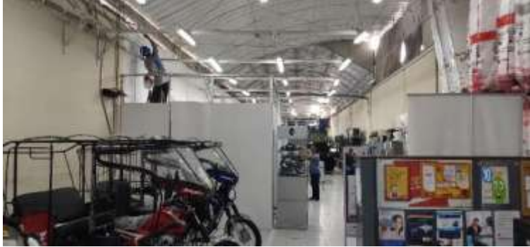
Pintado de Paredes en Zona de Cerramiento 01
