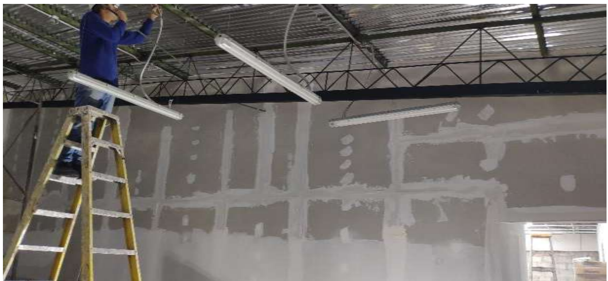
Instalación de Luminarias Herméticas Colgantes en Almacén
