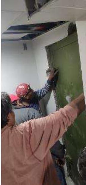
Instalación de Puerta de Bóveda
