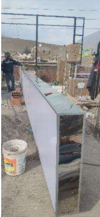
Fabricación de Letrero Publicitario con Estructura Metálica y Lona para Fachada
