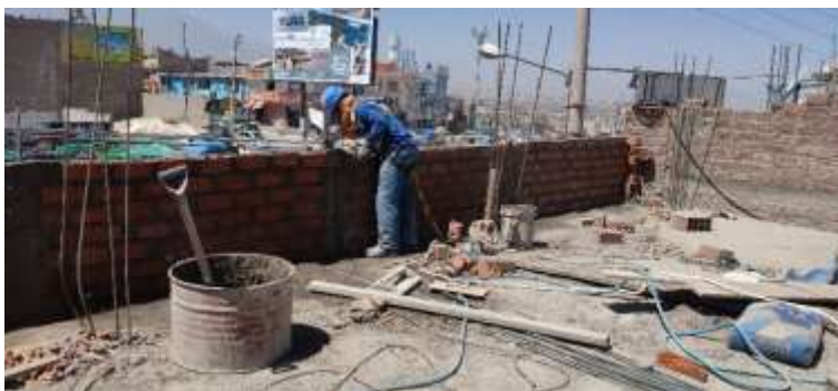
Asentado de Ladrillo para Parapeto, Armado y Vaciado de Concreto en Columneta de Amarre
