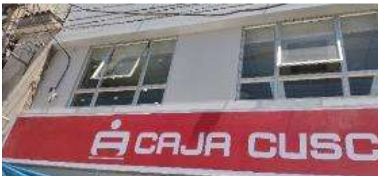
Instalación de Letrero Publicitario en Fachada
