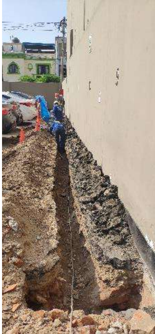
Picado de Pavimento Exterior para Nueva Red de Desagüe
