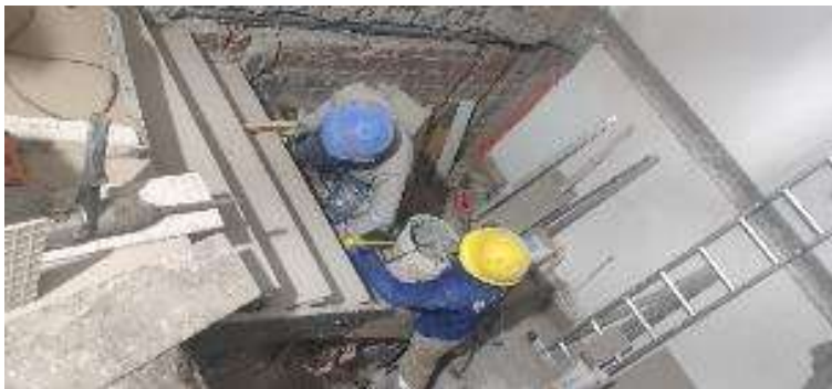
Trabajos de Enchape de Porcelanato en Escalera
