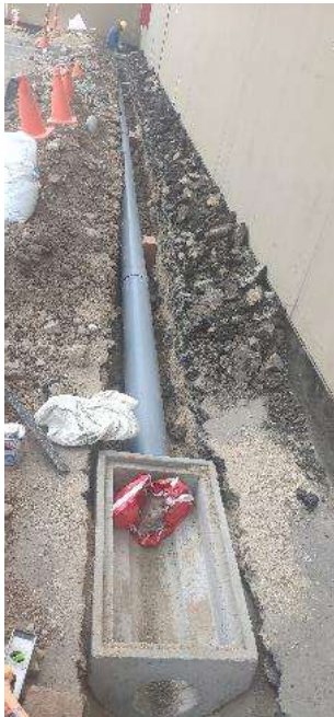
Instalación de Cajas de Desagüe y Tuberías de 6" PVC para Nueva Red
