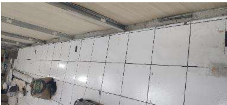
Trabajos de Enchape con Mayólica en Zonas Picadas por Entubados PVC
