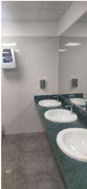
Instalación de Piedra, Lavatorios, Grifería y Accesorios
