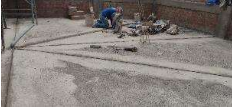
Realización de Bruñas y Frotachado de Piso en Azotea
