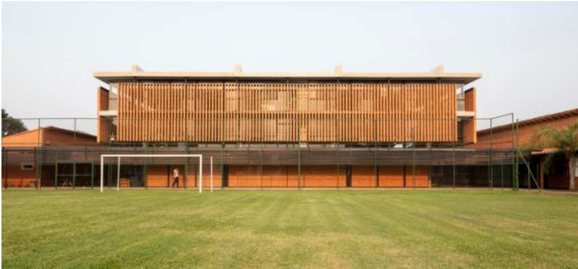
Figura IV Vista de la Fachada del Caso4
