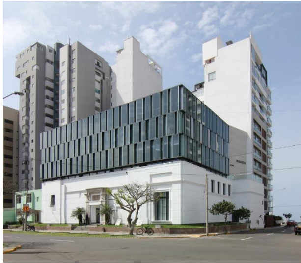
Figura I Vista de la Fachada del Caso I
