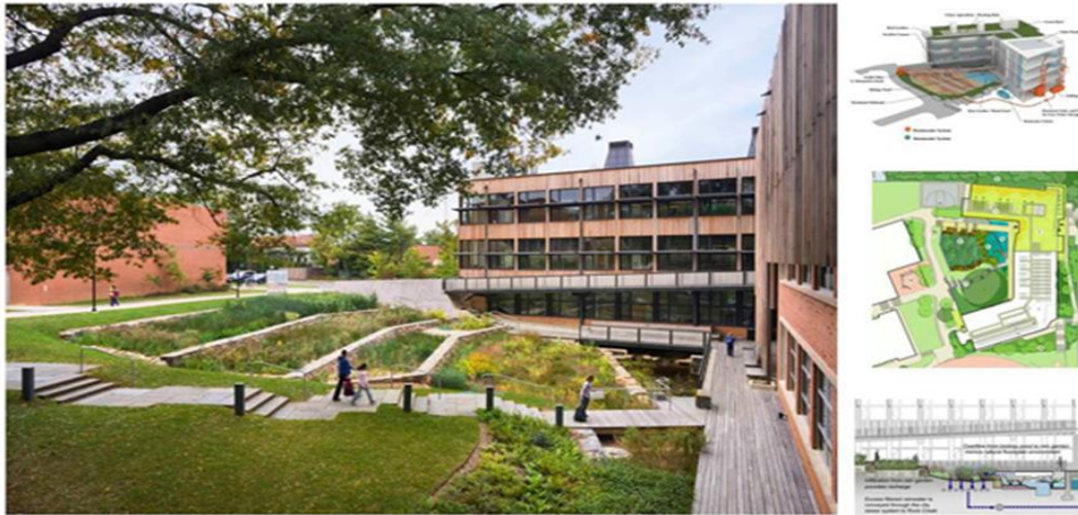
Figura 1. Humedales artificiales para la depuración de aguas residuales de un centro escolar (Sidwell Friend School, Washington, D. C.). MON Arquitectura y Biología (2013)
