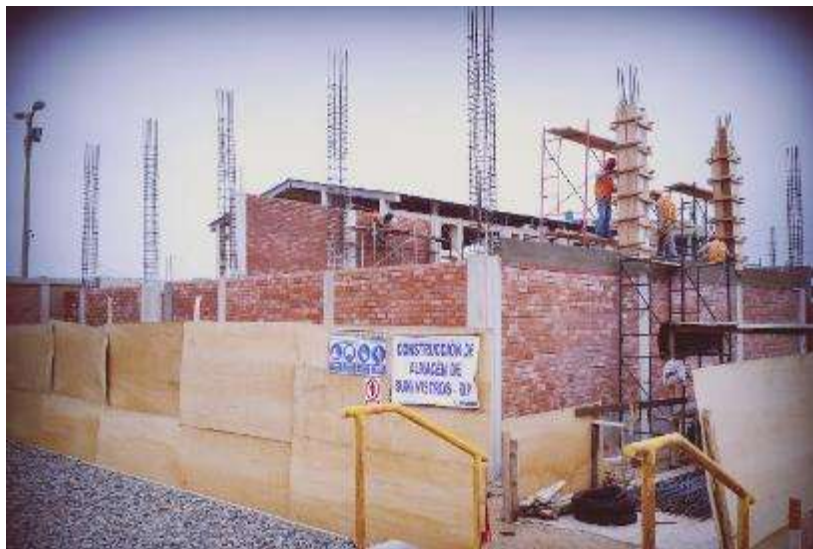
Figura 11. Proceso constructivo del almacén de suministro para REP. 2014. Extraído del perfil público de RB.
