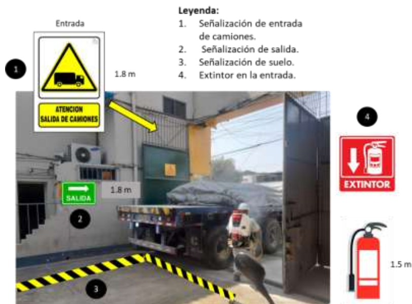
Figura 33: Señalización de la entrada en la parte interna.
