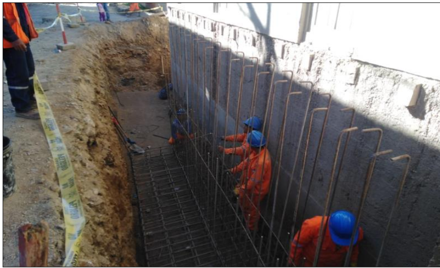
Figura 5: Colocación de acero horizontal en cuerpos de muros de contención.
