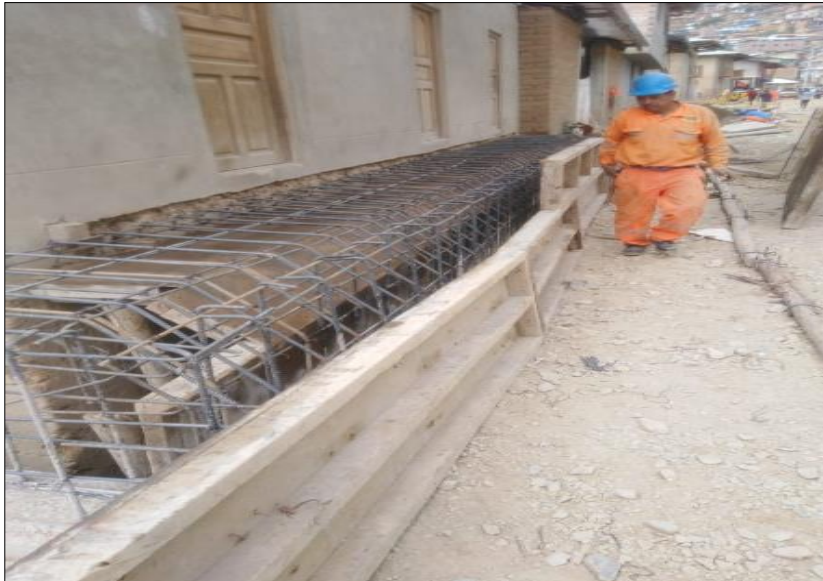
Figura 7: Colocación de acero y encofrados para muros de contención con veredas armadas y en voladizo.
