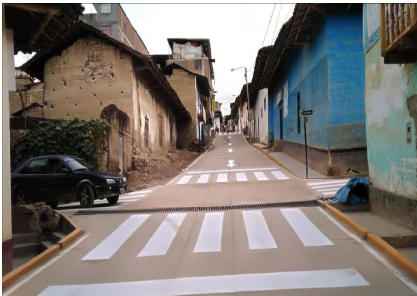
Figura 12: Señalización con pintura de tráfico en el Jr. Bolívar.
