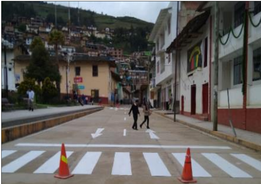
Figura 11: Pintado de gibas (correspondiente a trabajos complementarios aportados por el contratista).
