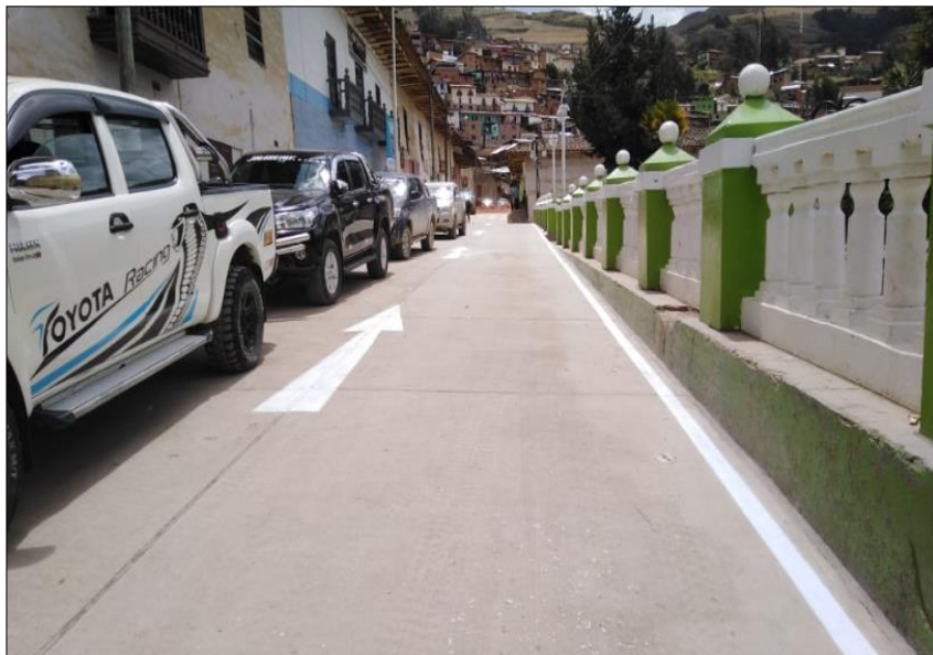
Figura 14: Señalización con pintura de tráfico en el Jr. Miguel Grau.
