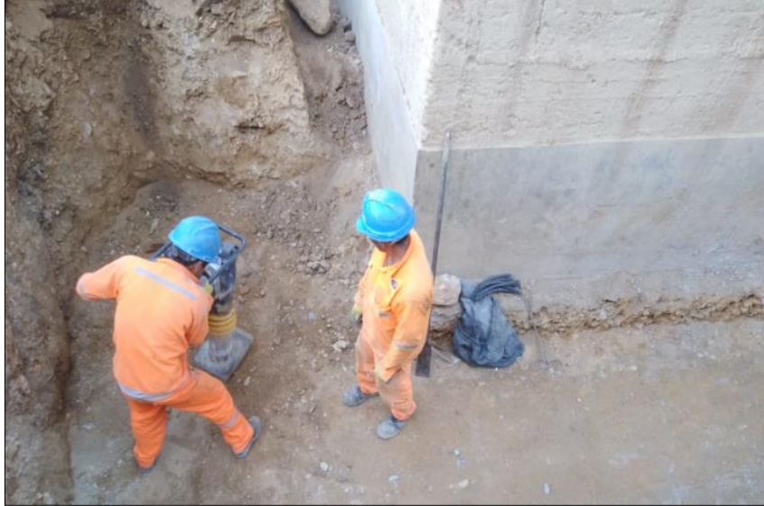
Figura 3: Trabajos de conformación de subrasante para la fundación de muros de contención armados.
