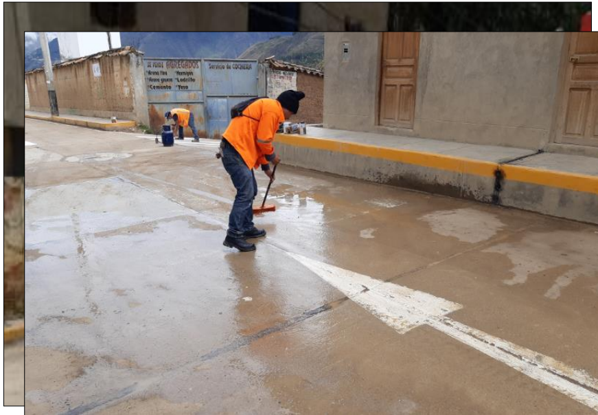
Figura 9: Previo al trabajo de pintado se realizó la limpieza en el área a pintar para evitar que la pintura tenga contacto con partículas de polvo y grasa.
