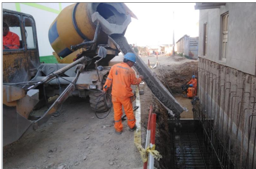
Figura 6: Aprobados los trabajos de colocación de acero y encofrados se procedió al vaciado de concreto en zapatas de muros de contención.
