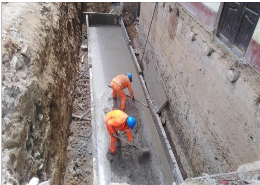
Figura 4: Trabajos iniciales de encofrado y vaciado de concreto para solados.
