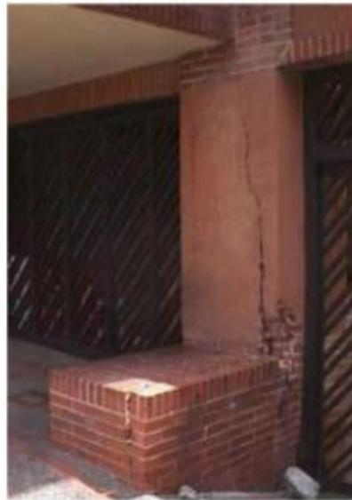
**FOTOGRAFIA No. 22** – Daño en la fachada de la mampostería que cubre la estructura en el lugar del empalme entre la edificación y la zona de la plataforma. Para realizar la reparación primero debe asegurarse la estabilidad de la torre del edificio y posteriormente la intervención de las zonas afectadas tanto en lo que respecta a la estructura como a los acabados y otros elementos no estructurales como en este caso las puertas de acceso a los parqueaderos.
