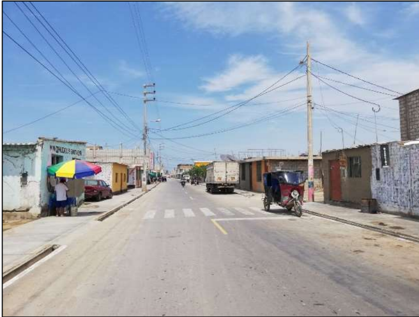
Figura 19 Pavimento terminado de la calle Real.
