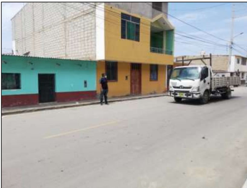
Figura 20 Pavimento terminado de la calle Real.
