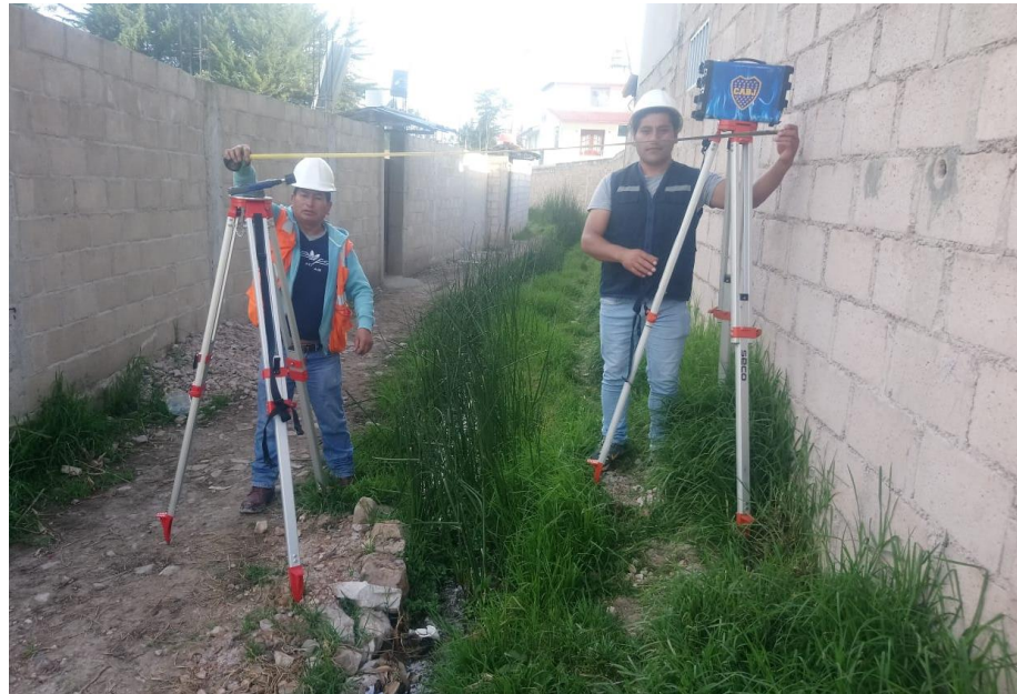
Figura 10 Instalación del sonómetro
