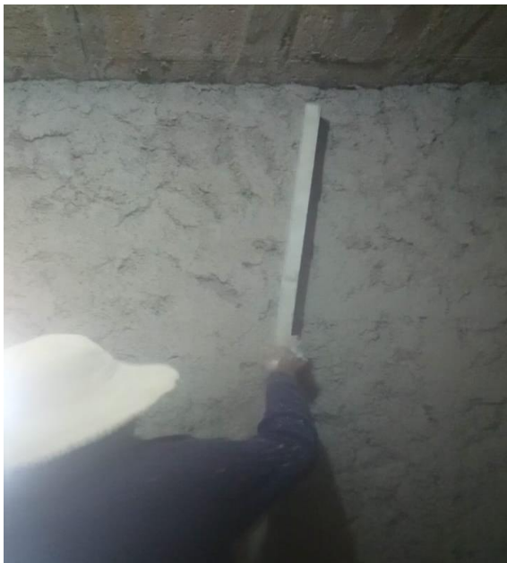
Figura 7 Revestimiento de muros con arcilla y afrecho de cebada
