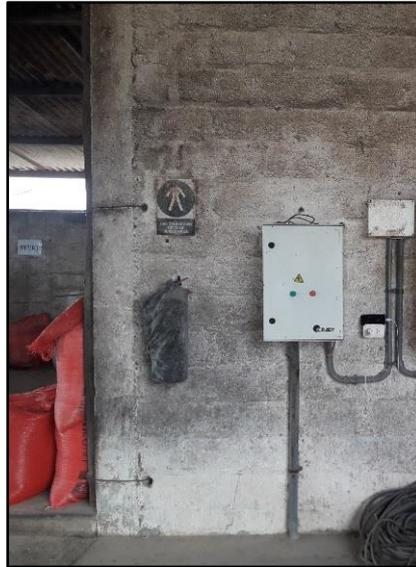
*Figura 14:* Panel de comando de galpón automático
