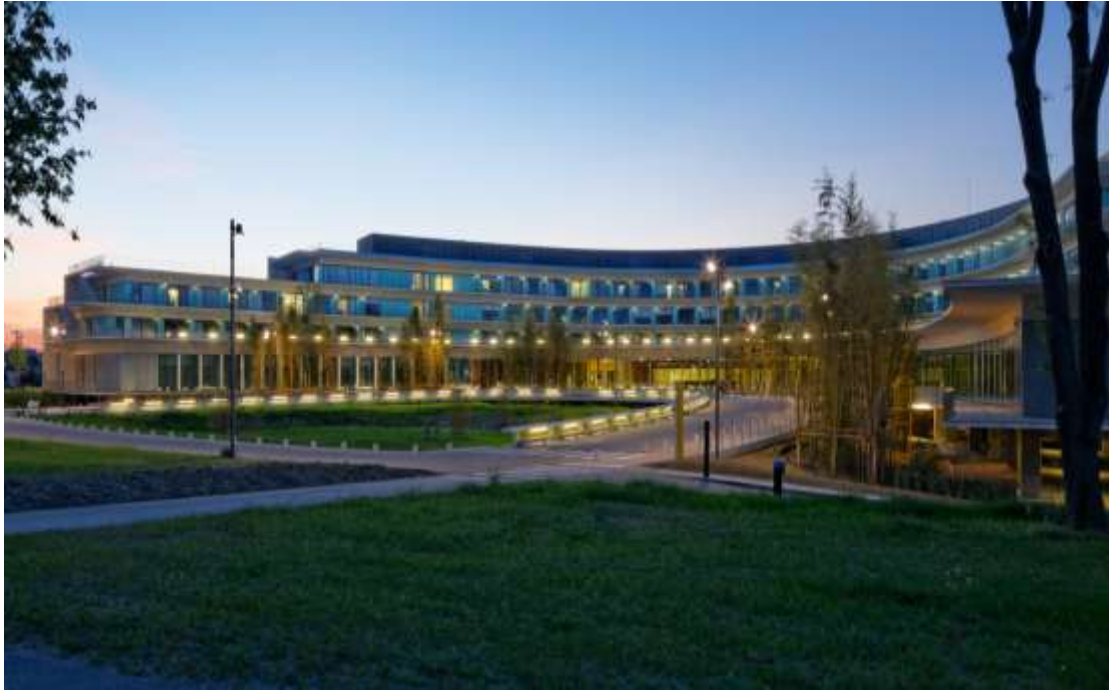
Figura 2: Vista frontal del caso N°2
