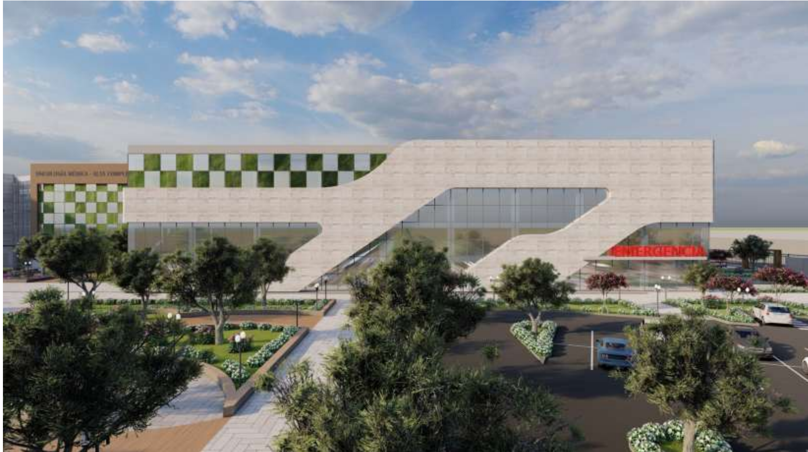
Figura 74: Vista frontal a Unidad de Emergencia
