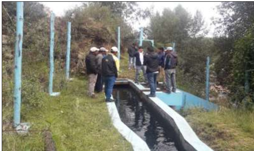
Figura 22. Situación actual del desarenador
