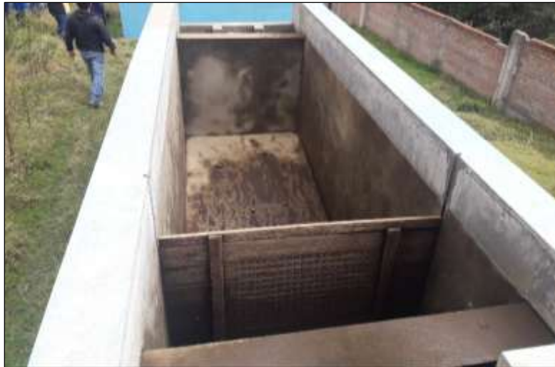
Figura 23. Situación actual del sedimentador
