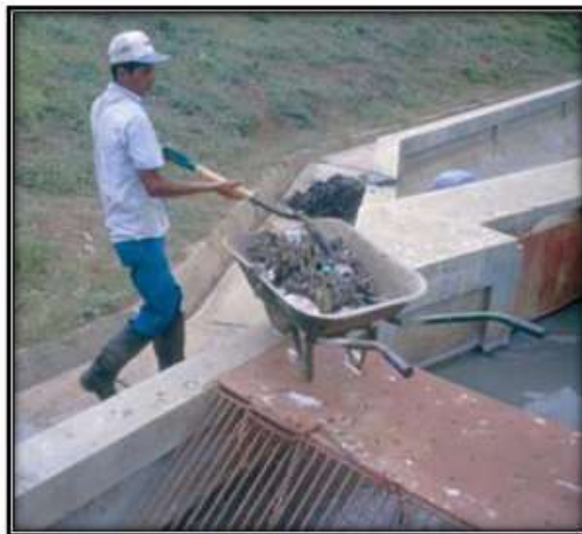
Figura 4. Mantenimiento de cámara de rejas.
