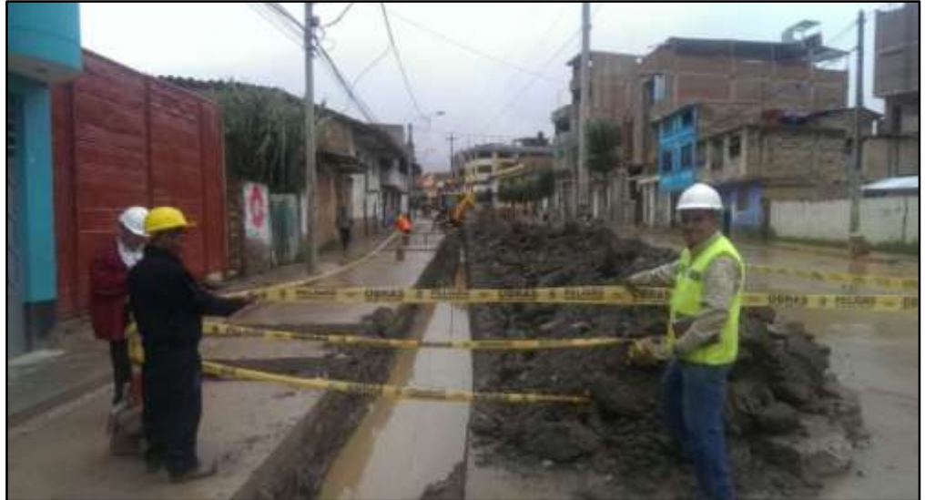
Figura 1. Canalización de tubería
