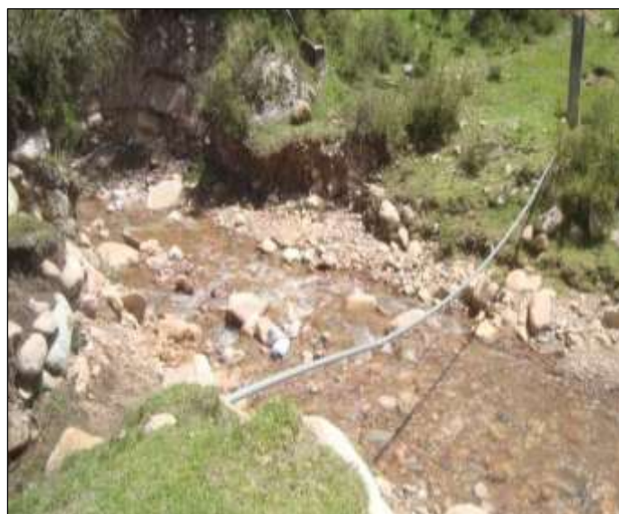
Figura 18. Vista panorámica de pase aéreo
