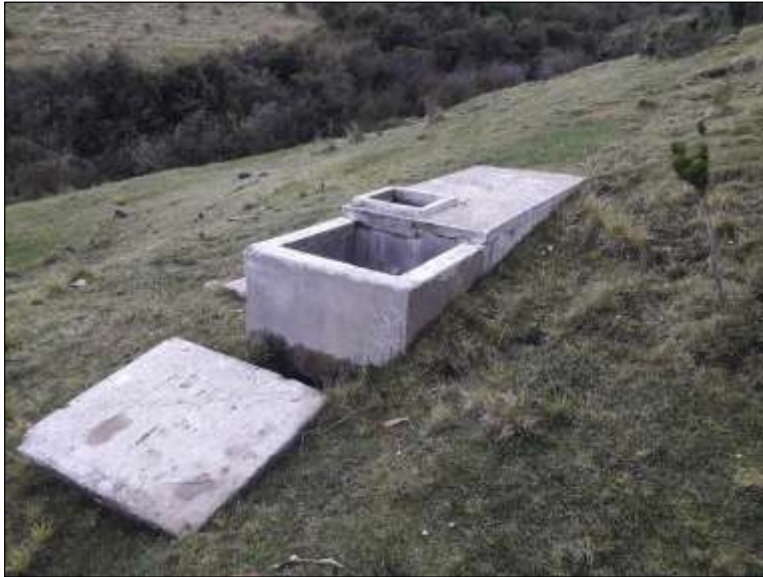
Figura 17. Cámara de reunión, en el sector de Nahuinhuaylla
