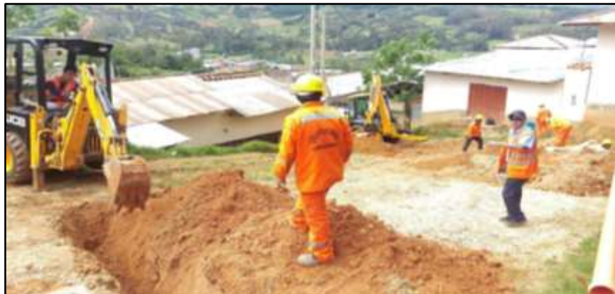
Figura 2. Excavación y movimiento de tierra
