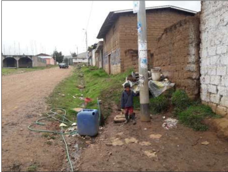
Figura 29. Situación actual de las conexiones domiciliarias
