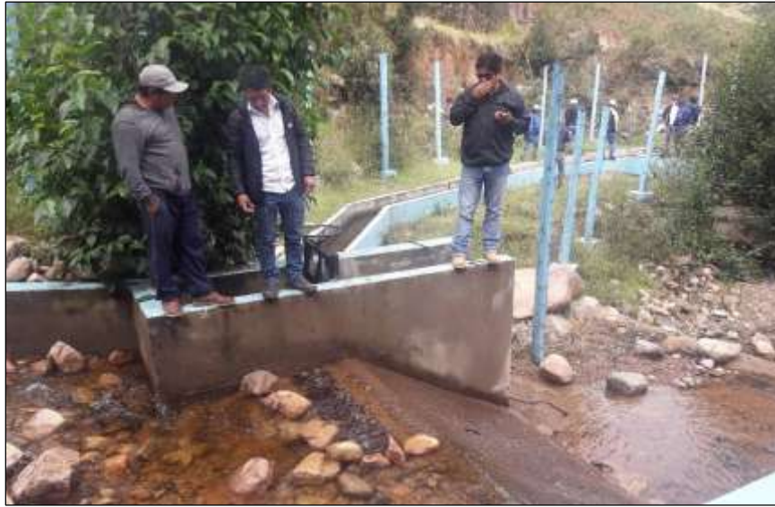
Figura 21. Situación actual de la captación
