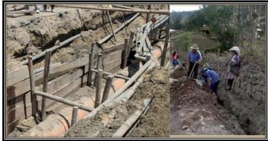
Figura 3. Corte y cambio de la tubería rota o rajada.
