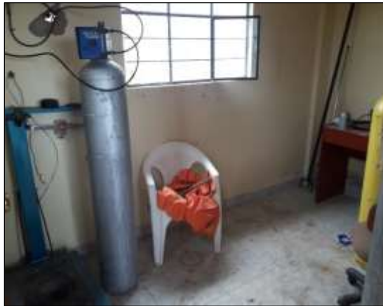
Figura 26. Situación actual de la caseta de acloración.
