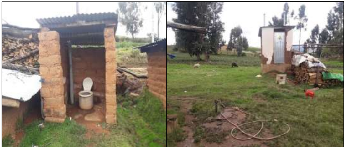
Figura 30. Situación actual de las letrinas.
