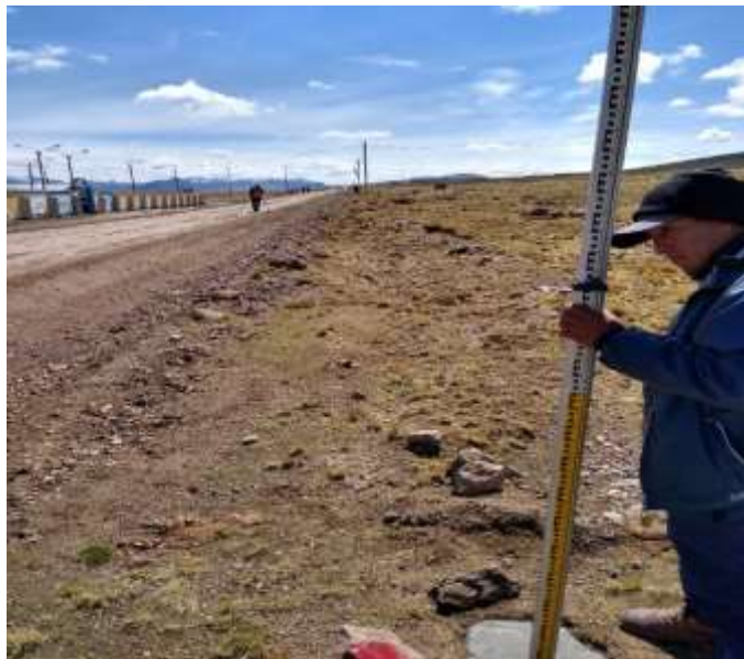
Figura 22 Realizando el control vertical
