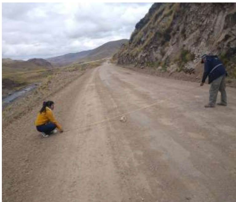
Figura 15 Mediciones del ancho de calzada
