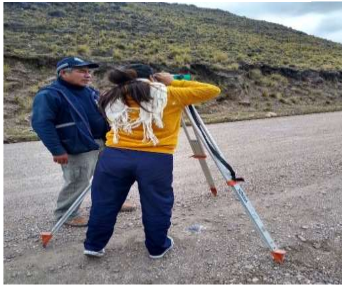
Figura 23 Realizando la nivelación del tramo
