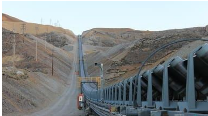
Figura N° 03: Mantenimiento faja transportadora 200CV003 Área Chancado Proyecto Toromocho– Mainin
