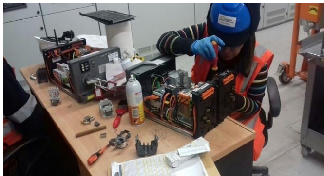
Figura N° 04: Mantenimiento arrancadores Sala Eléctrica 255ER028 Proyecto Toromocho – Mainin
