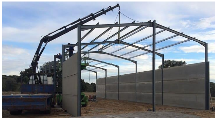
Figura N° 05: Montaje de Estructuras Industriales AK21 Proyecto Toromocho – Mainin
