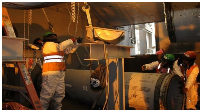
Figura N° 07: Cambio de tuberías Planta Concentradora Proyecto Toromocho – Mainin
