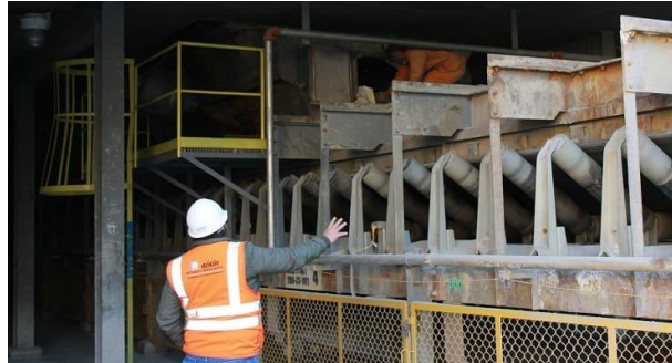
Figura N° 06: Cambio de polines y estructuras Proyecto Toromocho – Mainin
