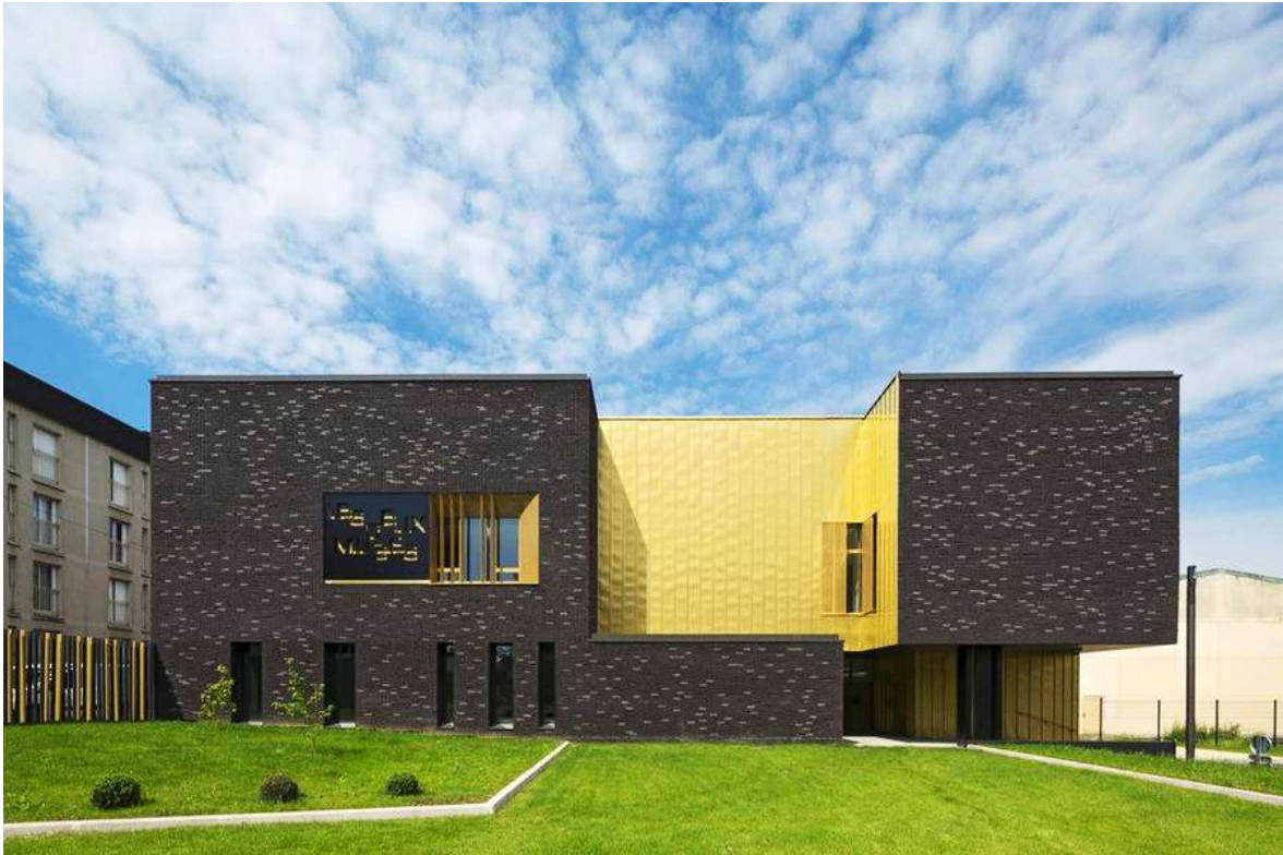
Ilustración 2 Vista general del caso N°2
