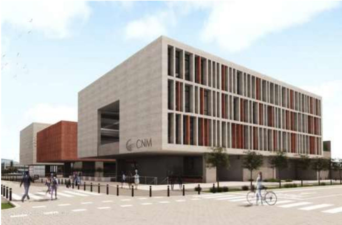
Ilustración 4 Vista general del caso N°4
