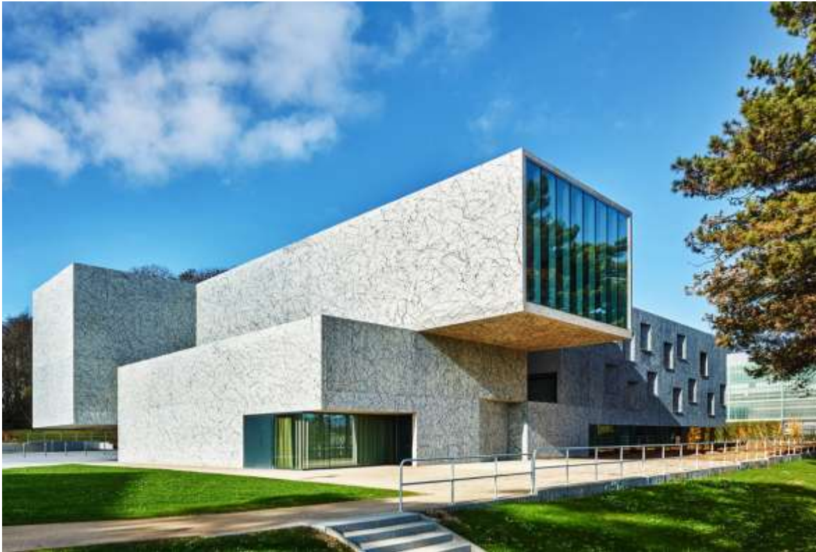
Ilustración 1 Vista general del caso N°1
