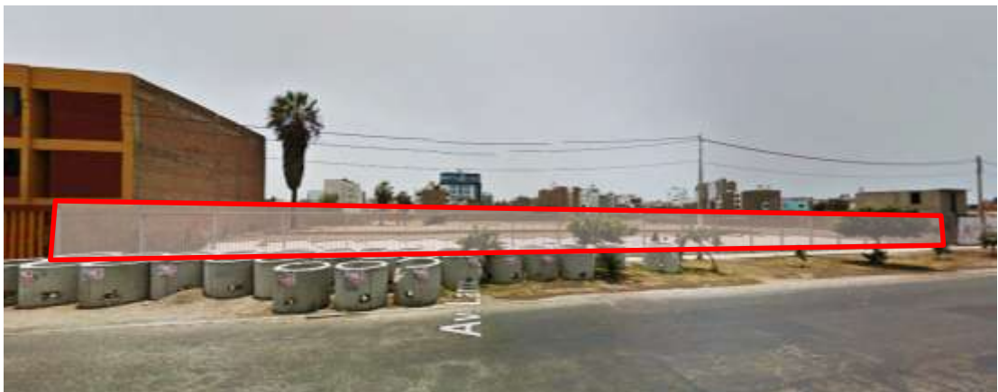
Ilustración 30 Vista del terreno N°3 desde la Av. Larco
