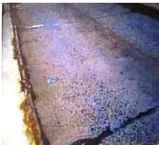
Pulimiento de agregados
