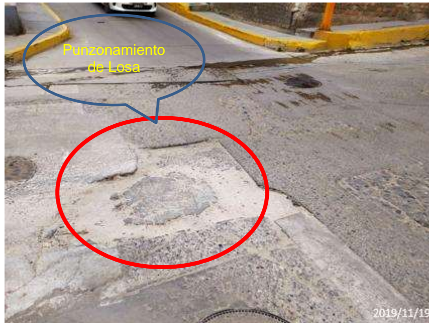
Anexo 48: Losa Dividida de severidad alta en Jr. Huánuco cdra. 10-11
