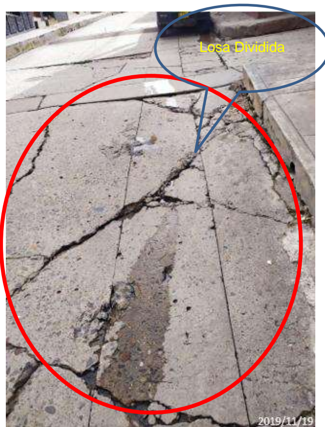
Anexo 48: Losa Dividida de severidad alta en Jr. Huánuco cdra. 10-11
