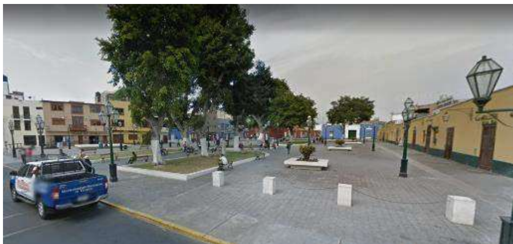
Figura 35. Vista del estado actual de la plazuela el recreo.
