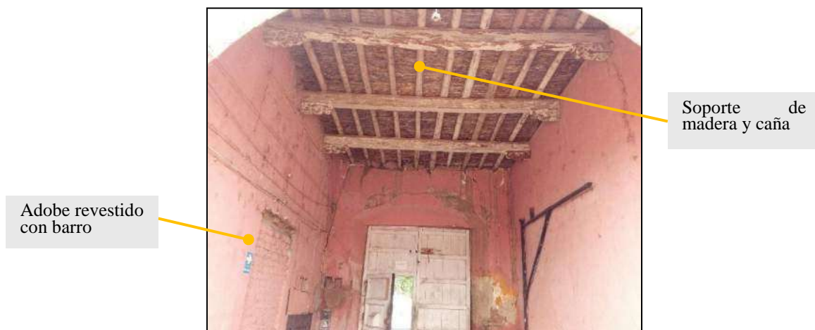
Figura 53. Materialidad de la zona intangible
