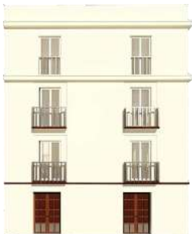
Figura 13. Vista 1 del frente de la casa Recacha.
