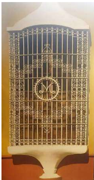
Figura 70. Ventana de la Casa de la Emancipación
