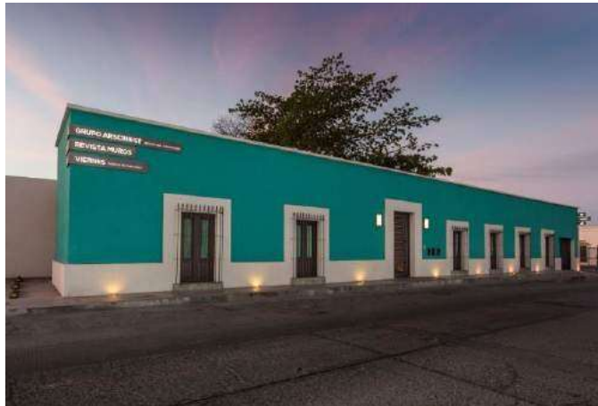
Figura 1. Revitalización Edificio Niños Héroes
