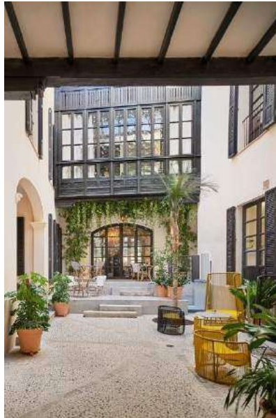
Figura 3. Renovación del hotel Can Bordoy
